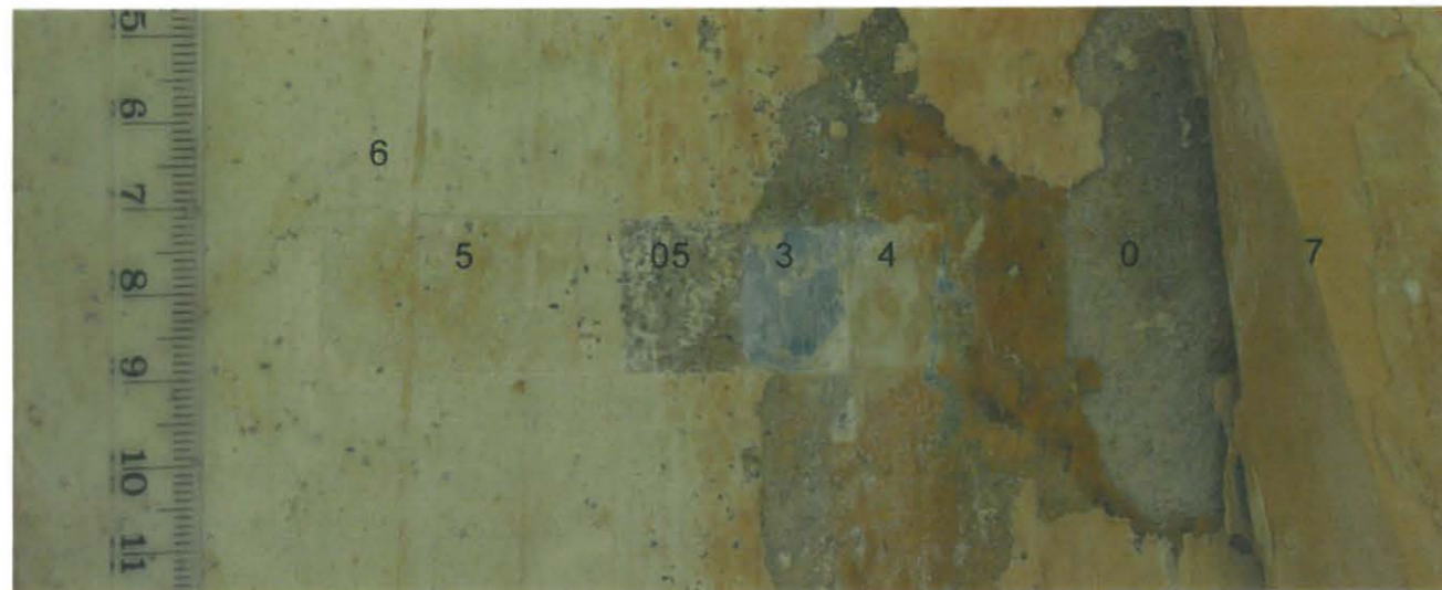
Kerrokset 1 ja 2 näkyivät parhaiten seinän yläosassa. Tämän vuoksi ne eivät näy kuvassa.
