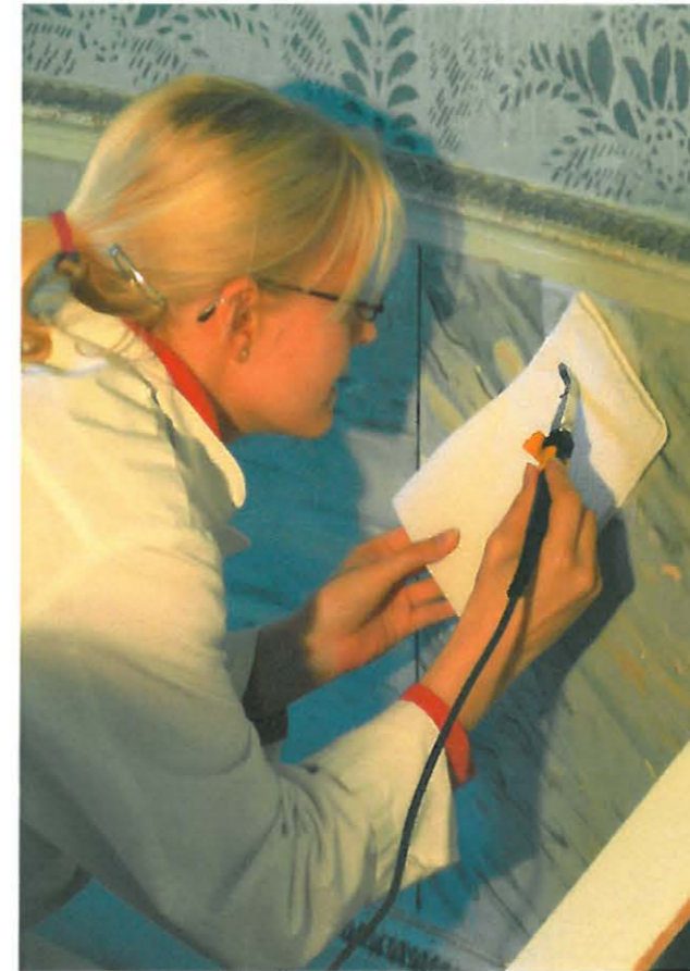
Maalipinnan kiinnittäminen taustaan lämpölusikan avulla.
