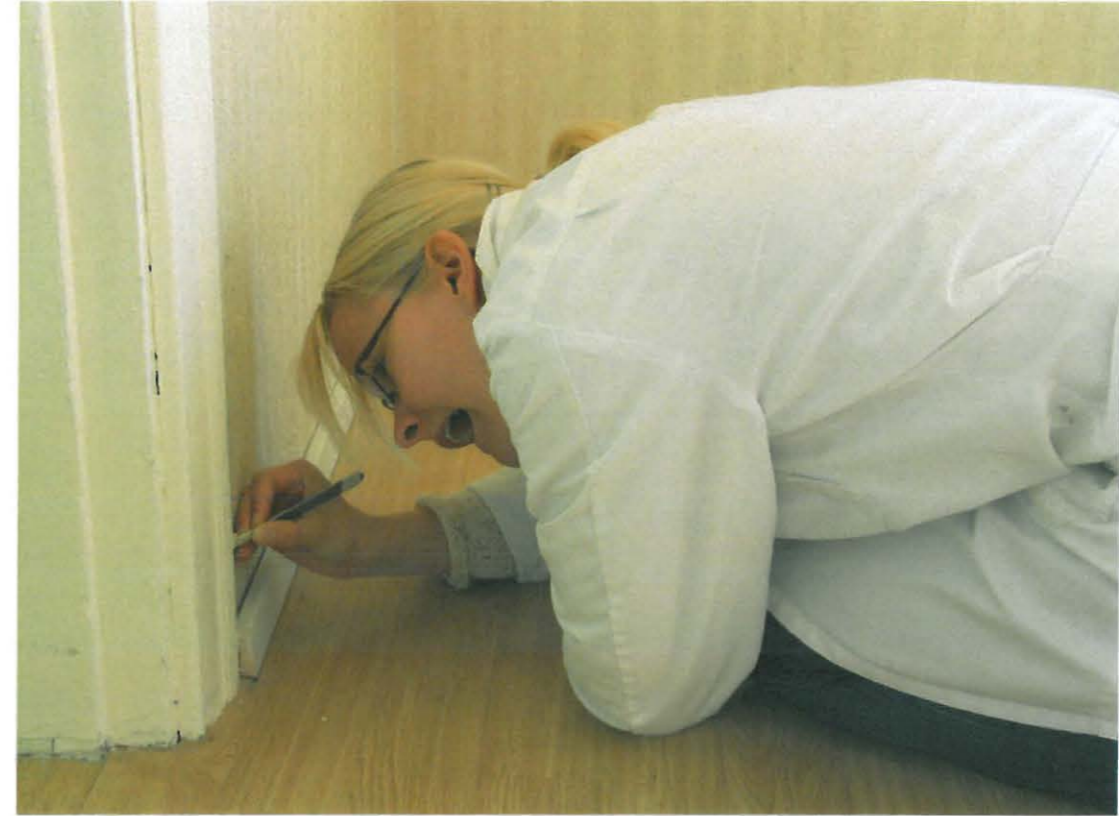
Huoneessa 2 tutkittiin tarkkaan rakenteita ennen koeaukon tekemistä.
