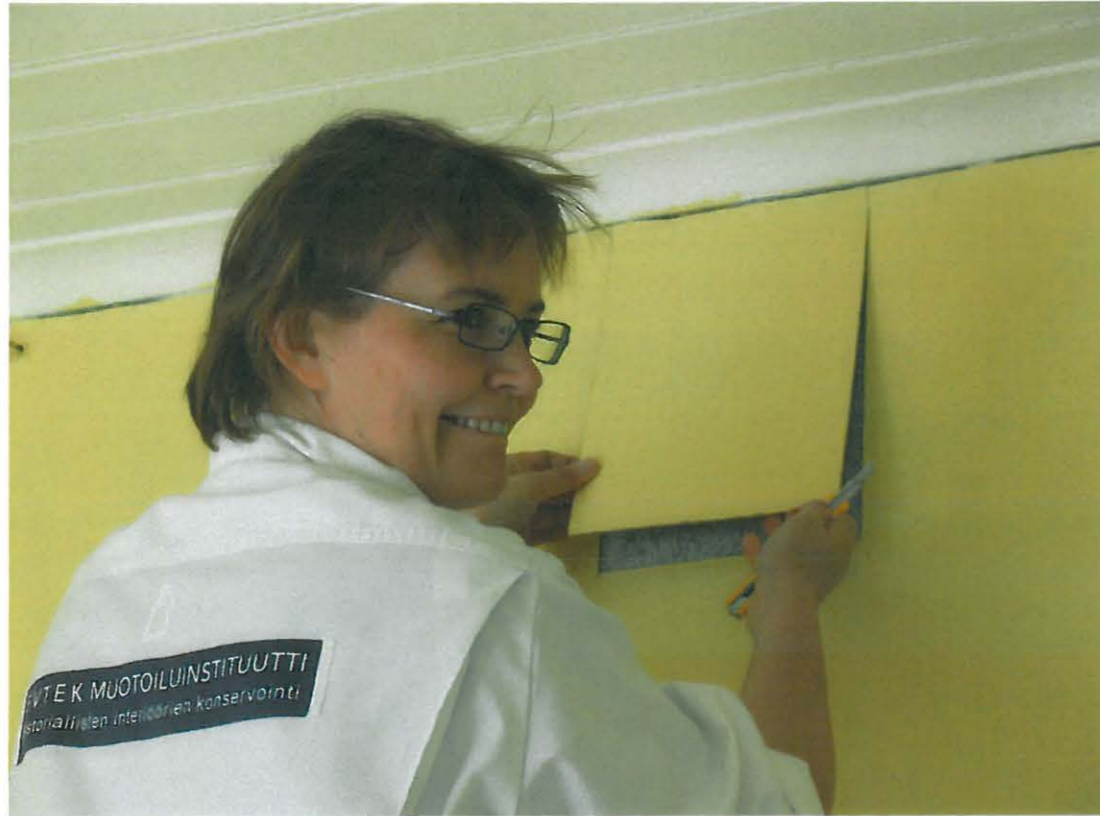
Päällimmäinen seinälevy huoneessa 1 irrotettiin veitsellä leikkaamalla.
