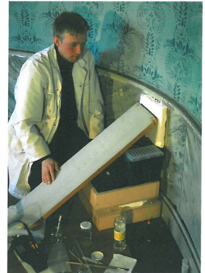
Tukien asettaminen liiman kuivumisen ajaksi
