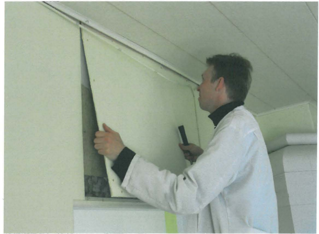
Sähköjohdon irrottamisen jälkeen levy vähitellen irtosi.
