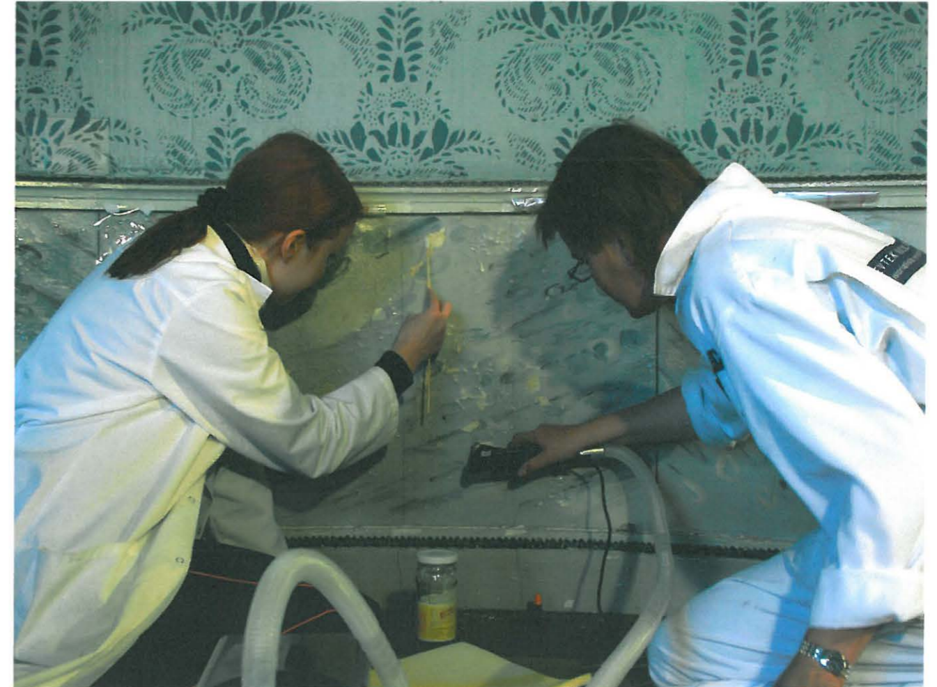
Maalipinnan pehmentäminen lämpimän ilman avulla ja ylempänä aiemmin tehdyn liimausalueen puhdistus.
