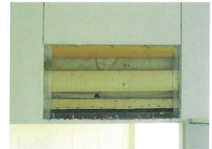
Seinä lastulevyn irrottamisen jälkeen.
