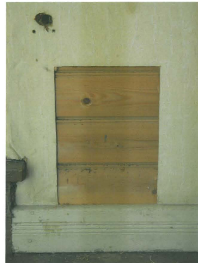
Avattu aukko huoneessa 5.
