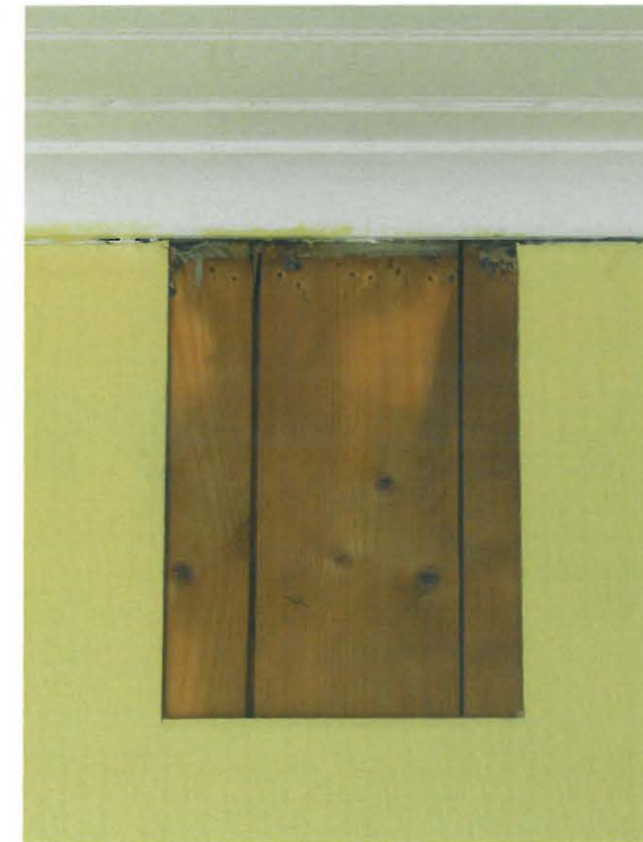
Avattu aukko huoneessa 1.
