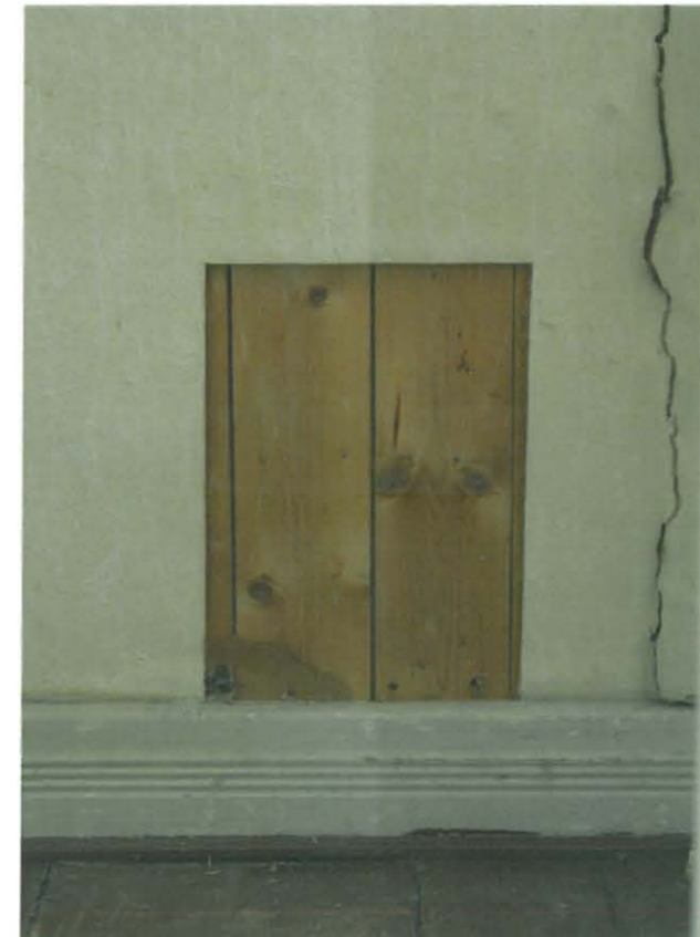
Avattu aukko huoneessa 6
