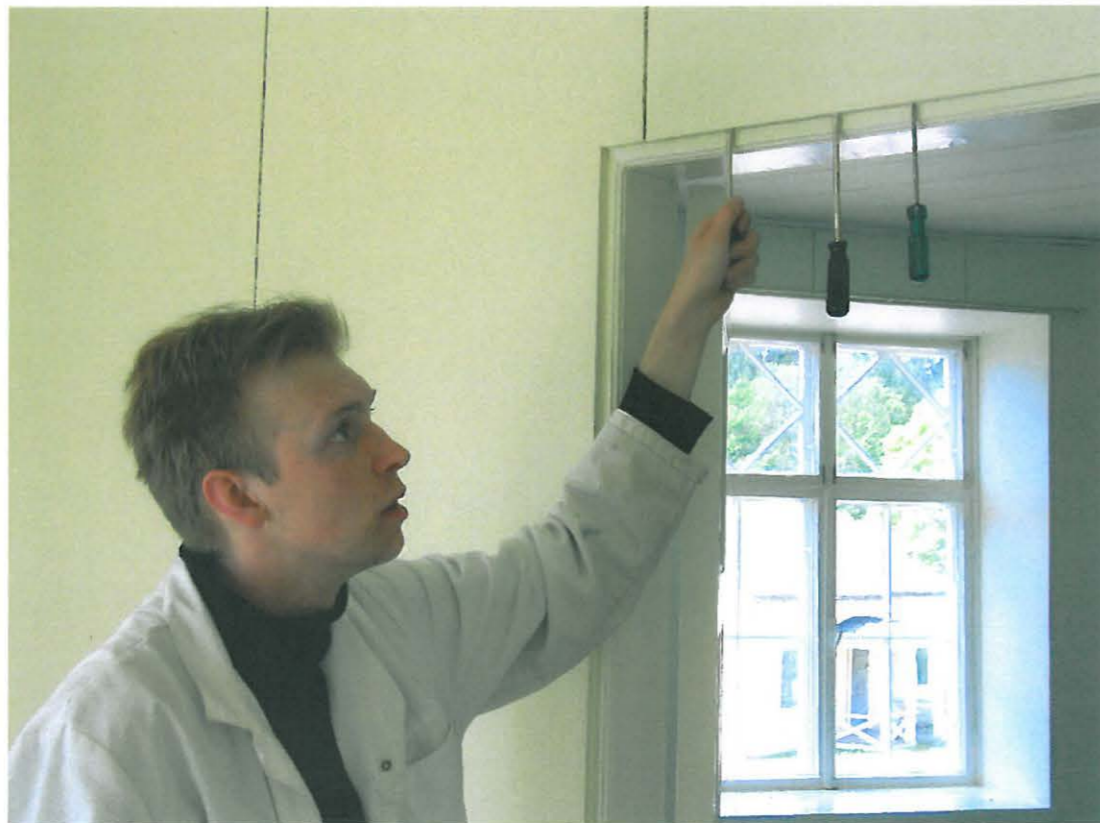
Lastulevy huoneessa 3 irrotettiin ruuvimeisseleitä apuna käyttäen.
