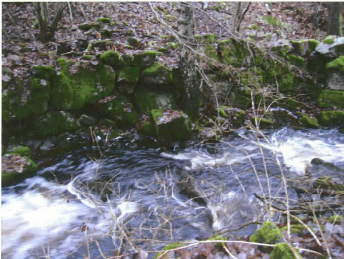
Kuva 7. Rakenteen 21 luoteinen seinärakenne. (KU)
