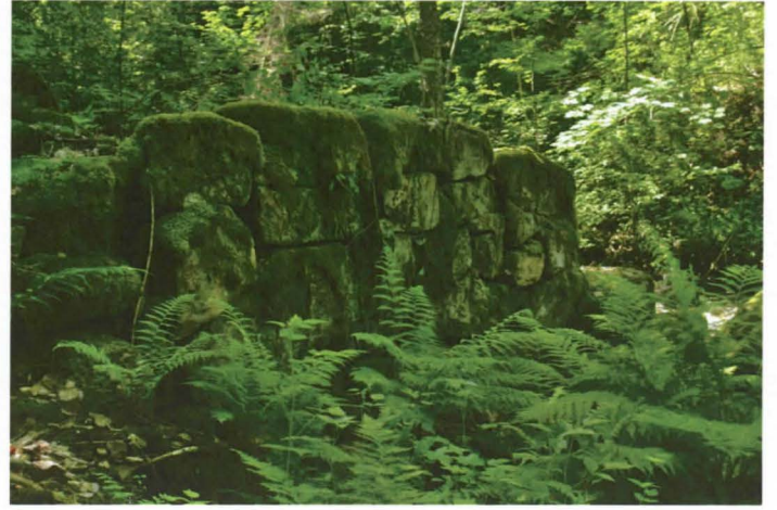
Kuva 16. Rakenne 22 pohjoisseinä. (MK)
