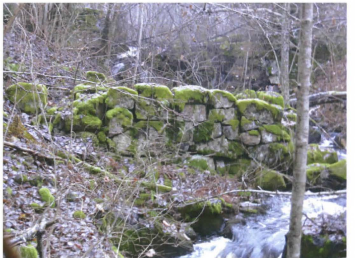
Kuva 18. Rakenne 22 pohjoisseinä. (MK)
