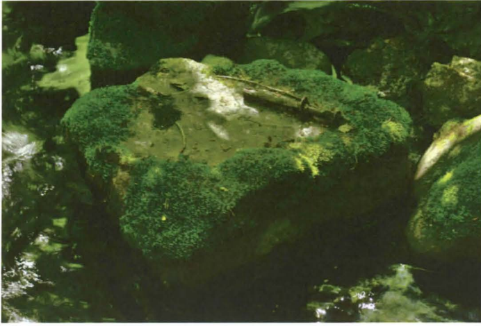
Kuva 13. Rakenteen 21 metallikiinnike. (MK)
