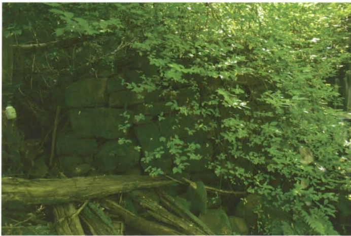
Kuva 20. Rakenne 23 pohjoisseinä. (MK)
