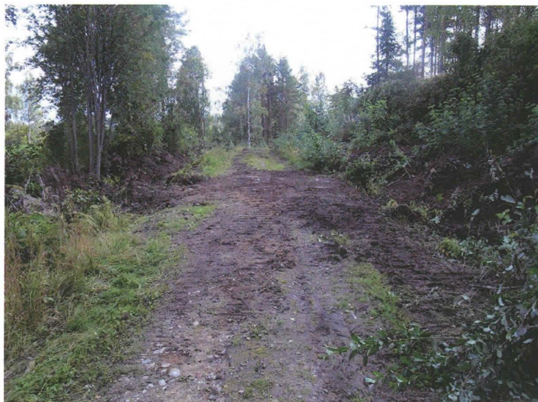
Kuva 4. Valvontalinja kaivettiin tien poikki, minkä jälkeen kaivanto täytettiin. Raportin digitaalikuva 09. Kuvattu luoteesta. Kuvaaja KL.
