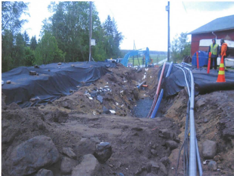
Kuva 1. Valvottavan alueen keskikohta sähköpylväiden välissä. Kuvattu W-suunnasta.
