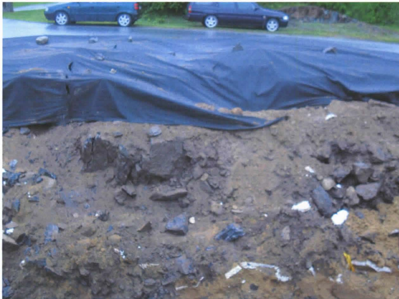
Kuva 3. Kaivannon pohjoisreunan profiilia. Keskellä kuvaa räjäytettyä kalliota. Kuvattu S-suunnasta.
