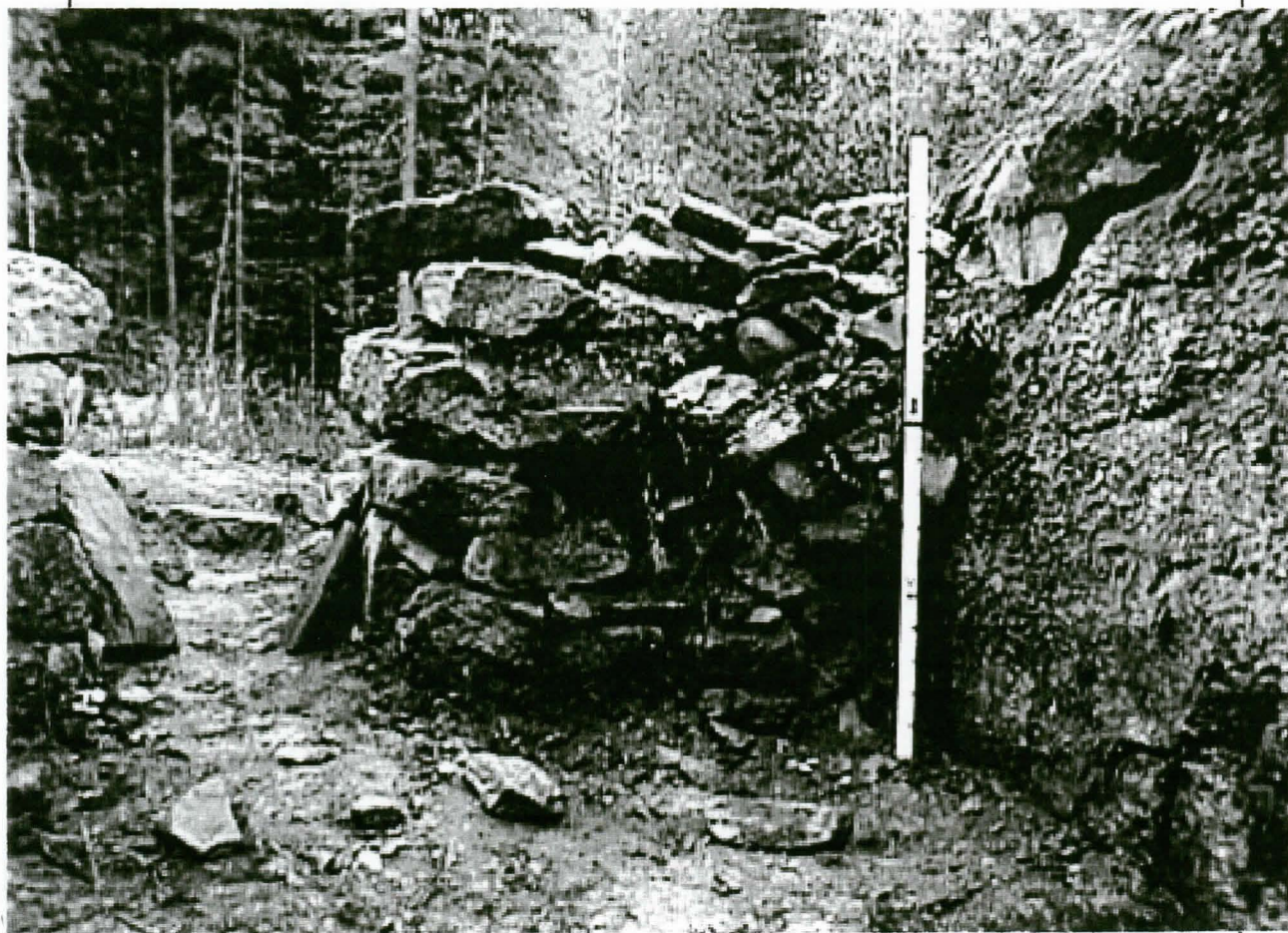
8. OVIPÄÄDYN ETELÄSEINÄ RAKENNUKSEN SISÄLTÄ KUVATTUNA (MATTI RIKKONEN) EKM 1311:9
