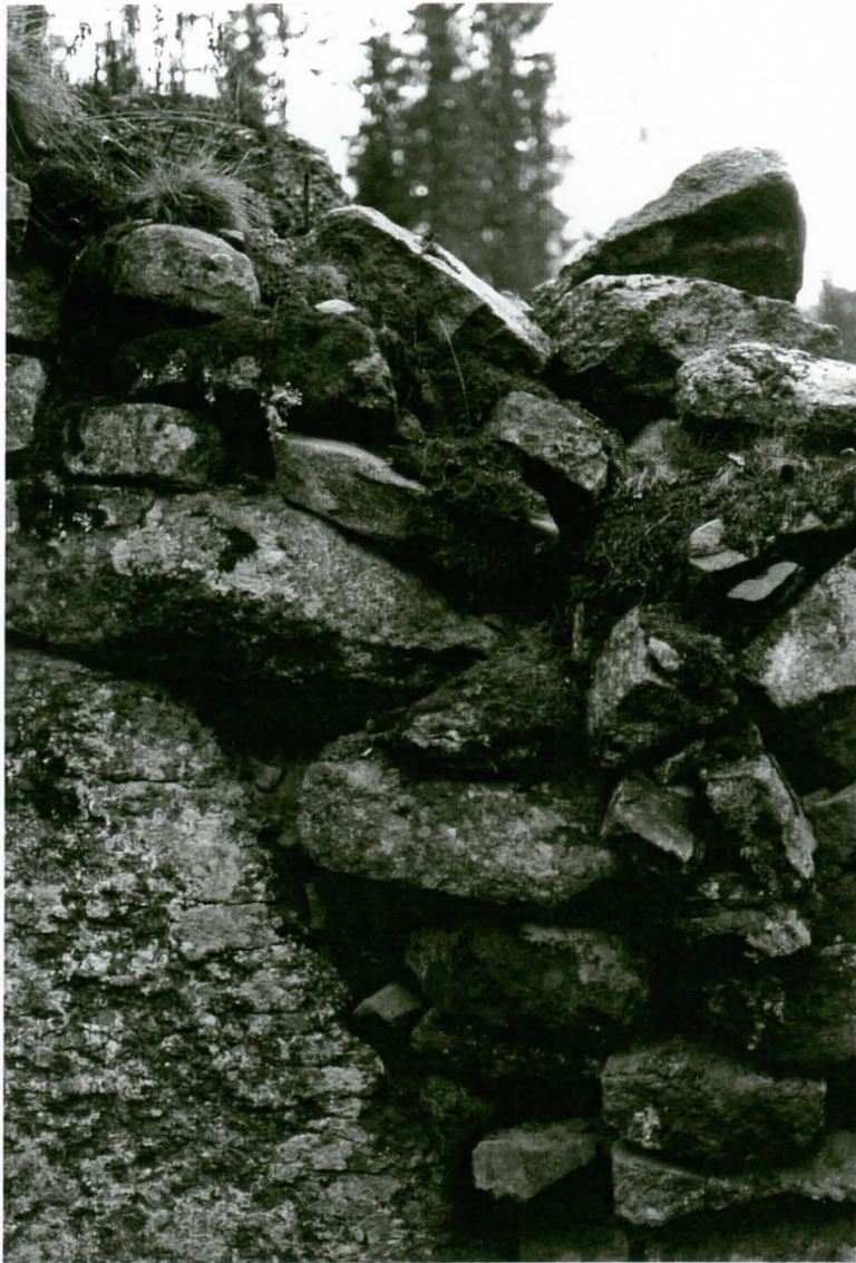
18. KIVILATOMUSTA PISTEEN E KOHDALLA POHJOISSEINÄLLÄ (J.LUOTO) EKM 1311:20
