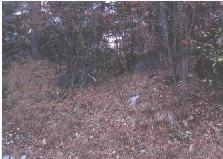
Kuva 6: Rakenne A. Suuaukon reunakivet
