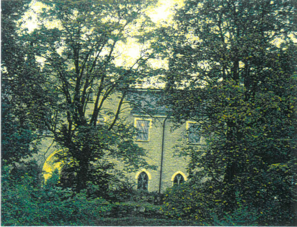
Kuva 1. Saitian kartanolinnan päärakennus etelästä. - Kuva T. Lempiäinen
