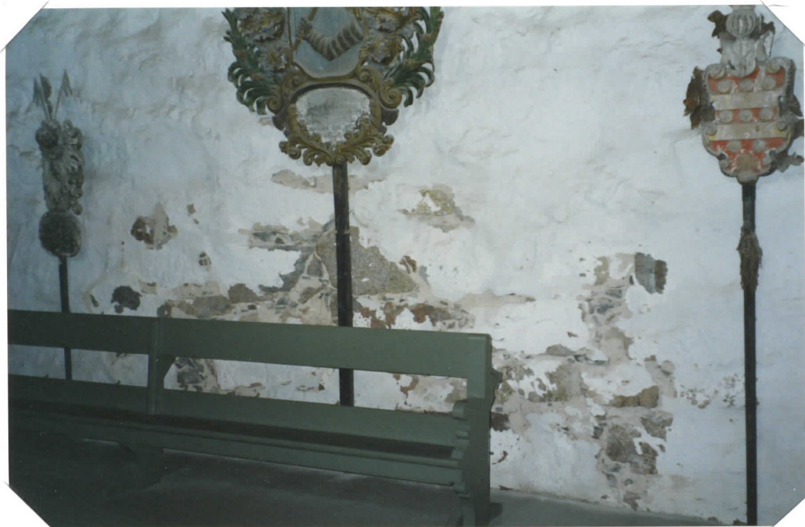
ETEISAULAN POUH. SEINÄN ALAOSA
