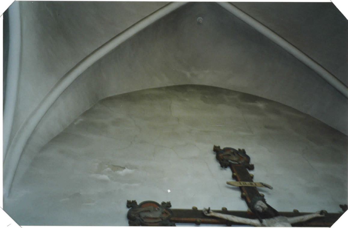
II POUJOISLAINAN IRTOILEVAA SEINÄPINTTÄÄ
