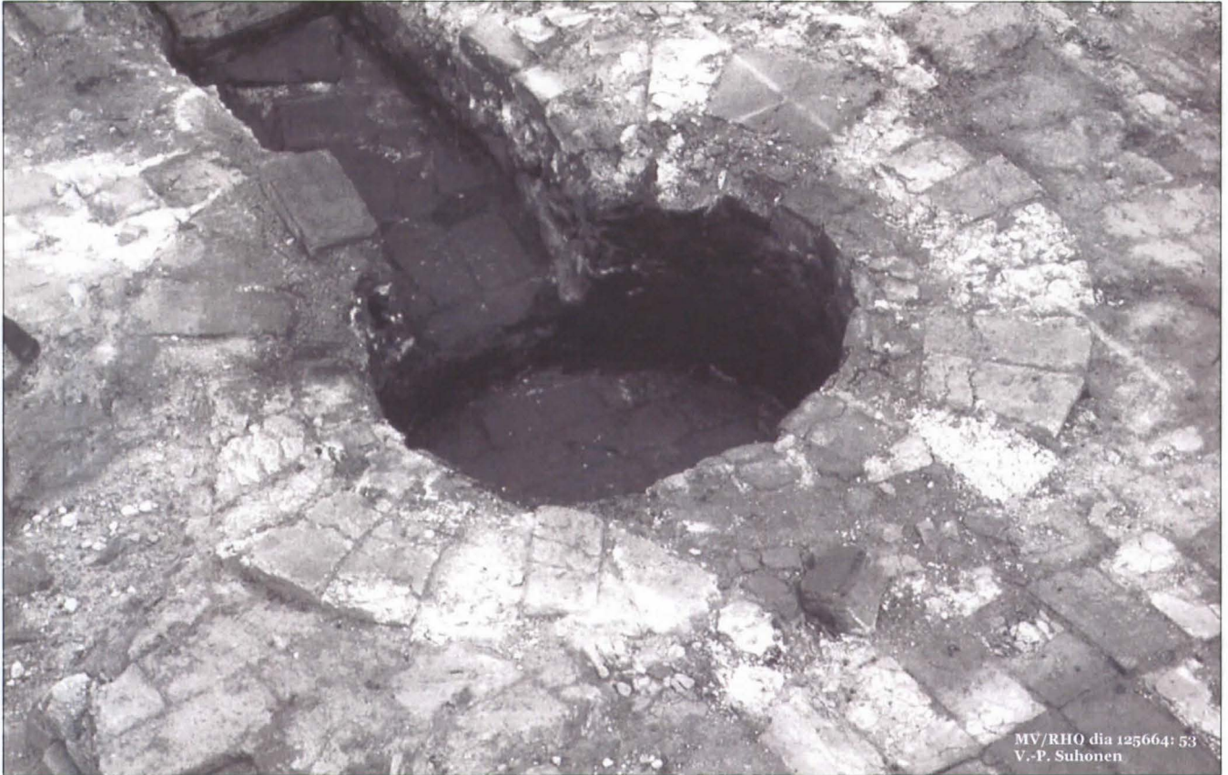
Kuva 35: Höyrykoneen savupiipun pohjan keskus.
