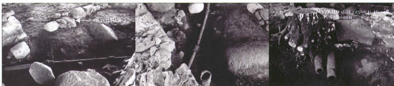
Kuvat 25–27: Raastuvan eteläosan länsipuolelta esiin tulleet rautaputket.
