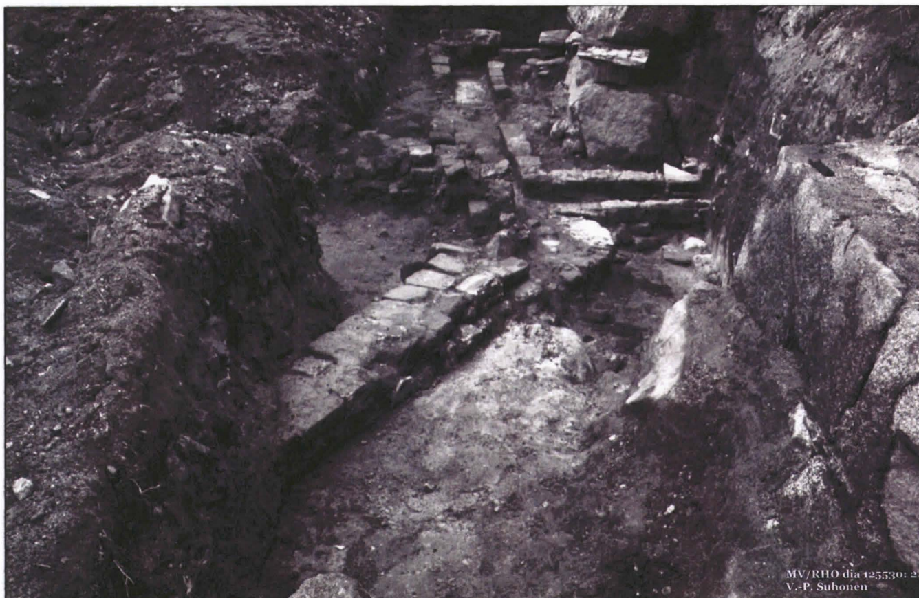
Kuva 16: Masuunin perustuksen vierellä pohjoisessa olleet rakenteet vuonna 2004
