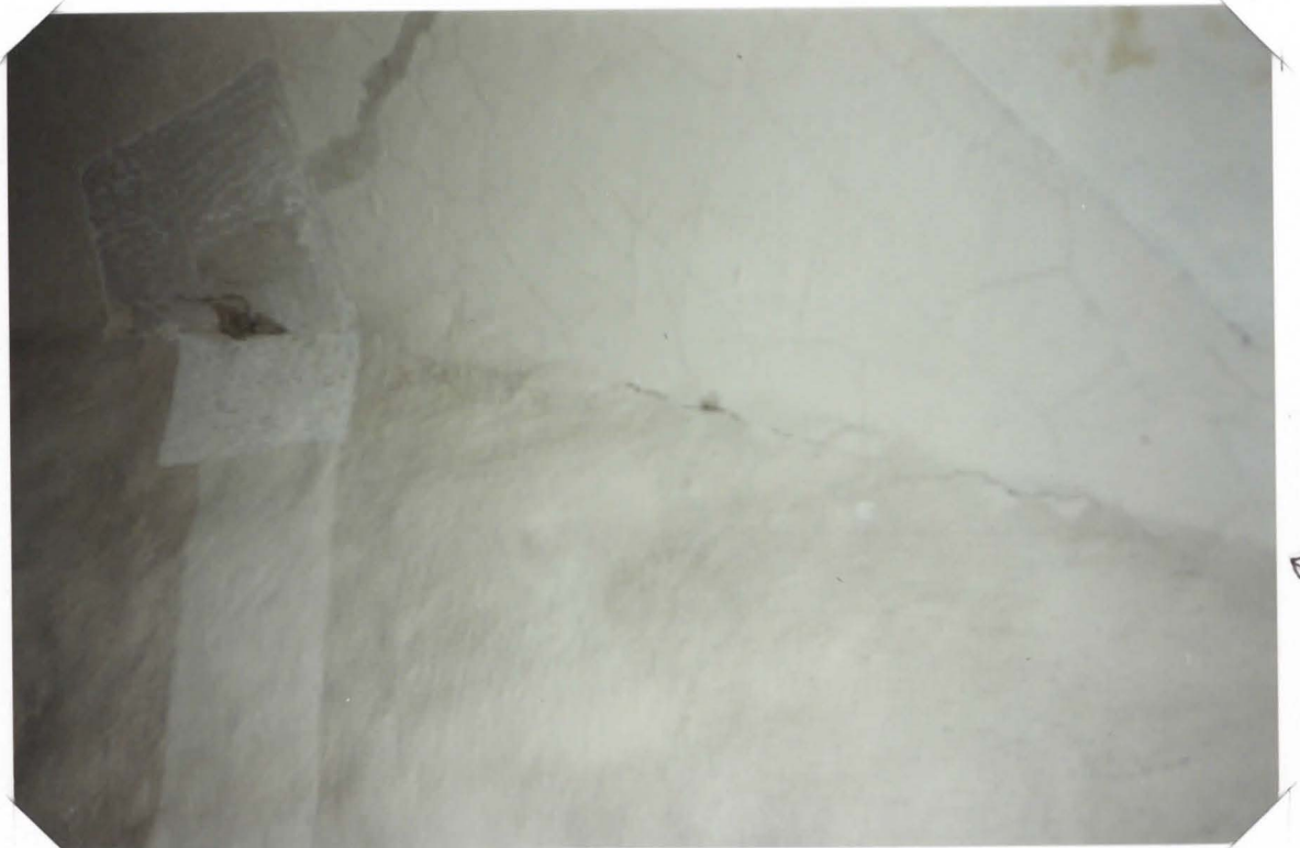
↑ SEINÄPINNAN JA HOLVIYAIKAN TAITEKOHTA └ PUHDISTUSPINTAA: YLÄOSA NAPUTETTU ALOSA LIINSIN
