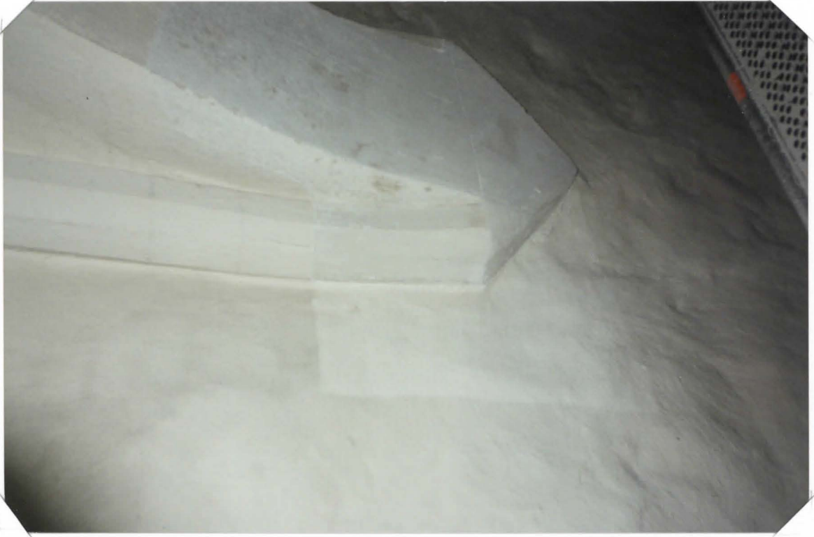
RUSTEEN PÄÄ JA KONSOLI NARUTETTU JA HARAPESTY. VIER. PINTA PUHD. LIINOIN
