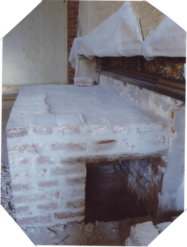
ÄNÖHEMPI TIILISOKKELI POISTETTU.
