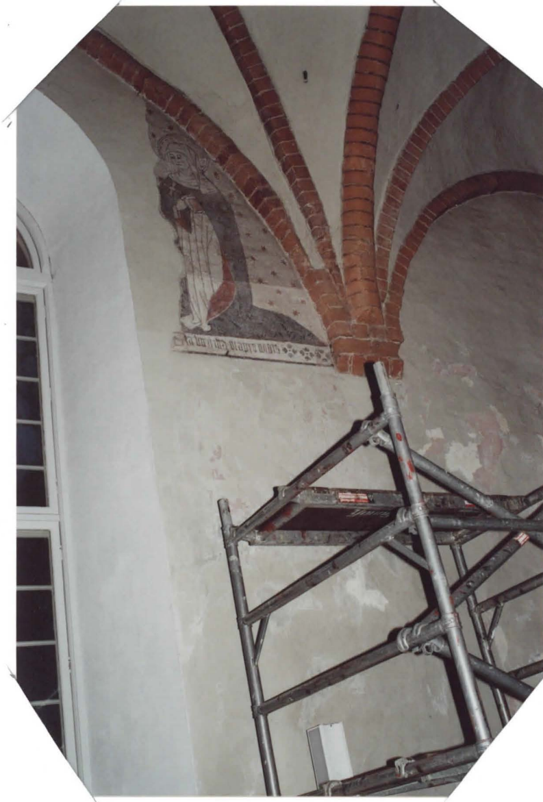
MAALAUKSEN KOE- PUHDISTUS (RAJA)
