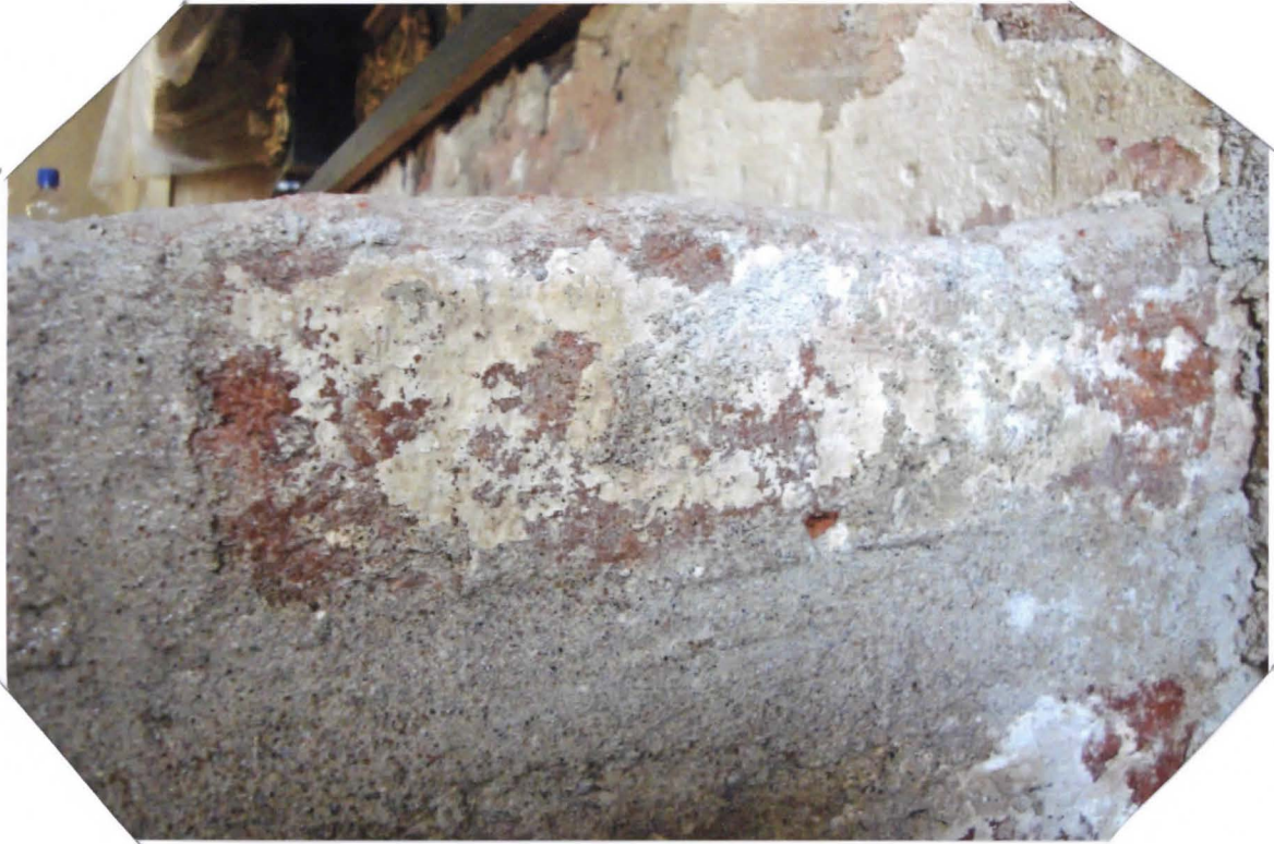
- ALTтарIPIDÄN ALKUP. TIILIKADELMAAN - VANHINTA KERROSTUMMA VIELÄ JÄLVELLÄ
