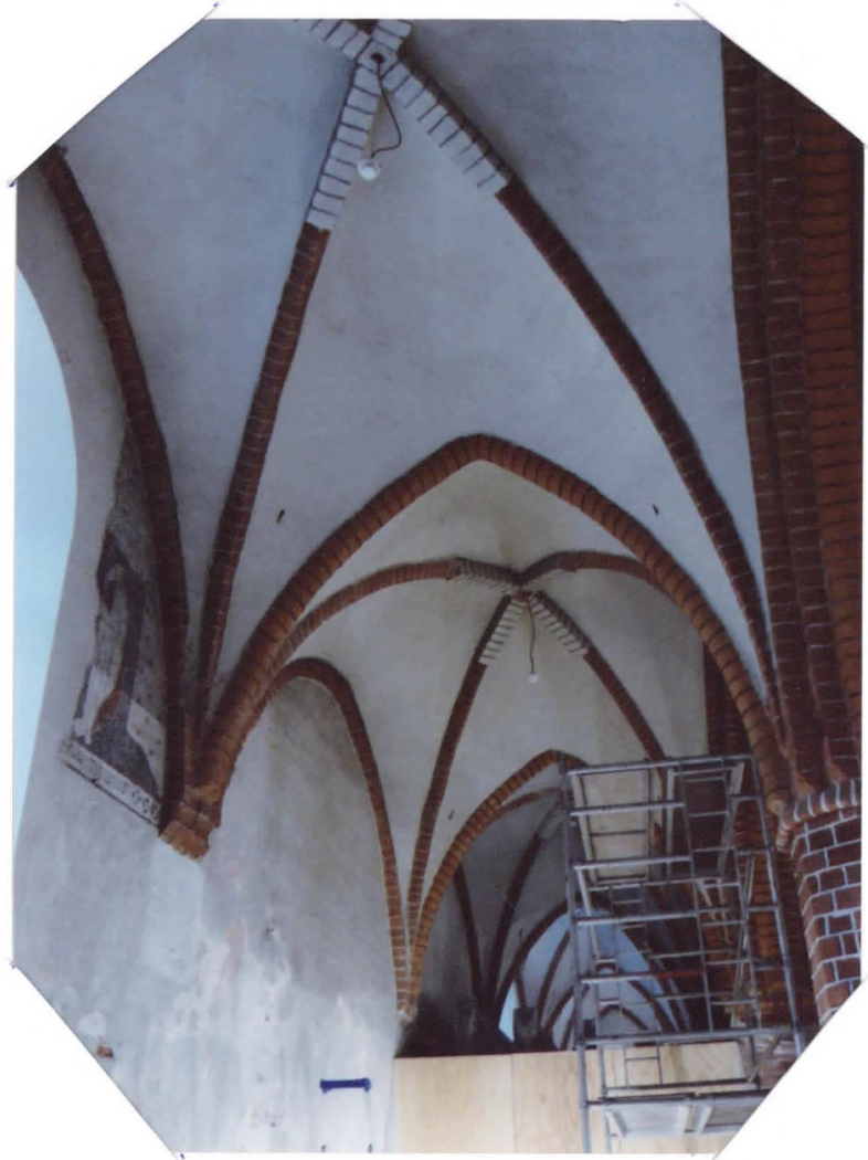
PUHDISTUSVAIHEESSA - HUOM. PUHDISTUSRAJAT
