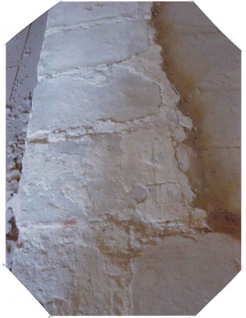
VANHAA KALKKIRAPPAUSTA ALKUP. TIILI- KERROKSEN PÄÄLLÄ
