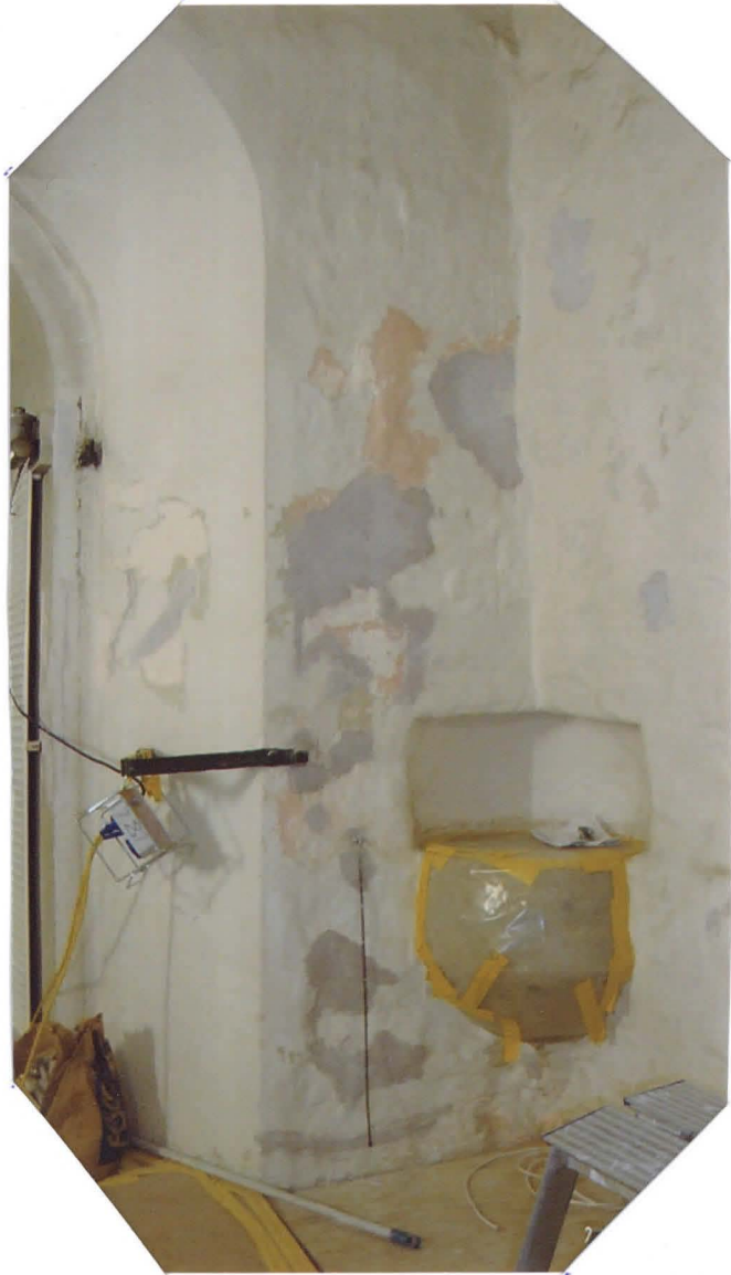
- RAPAUTUNEET ALUEET POISTETTU - KALKKILAASTI PÄIKKÄYSTÄ
