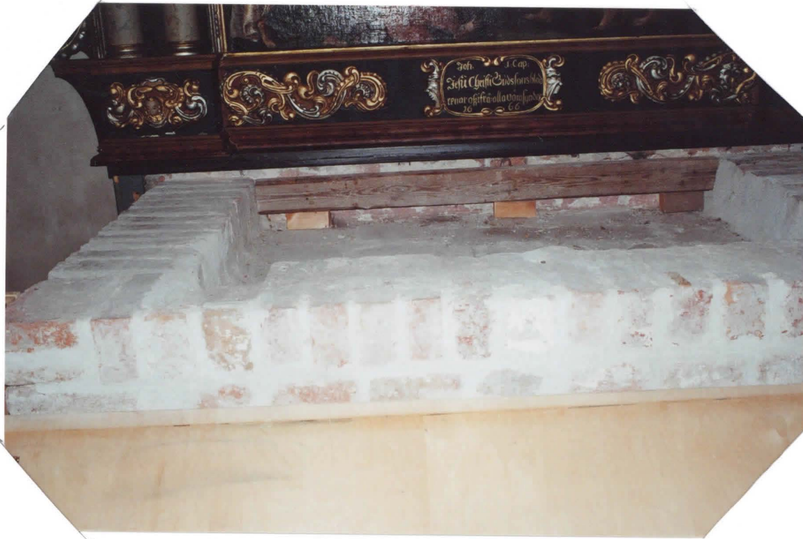
KOKOTUSSASSA ON KÄYTETTY VAAHAA JA UUDEN- PAA TIILTÄ
