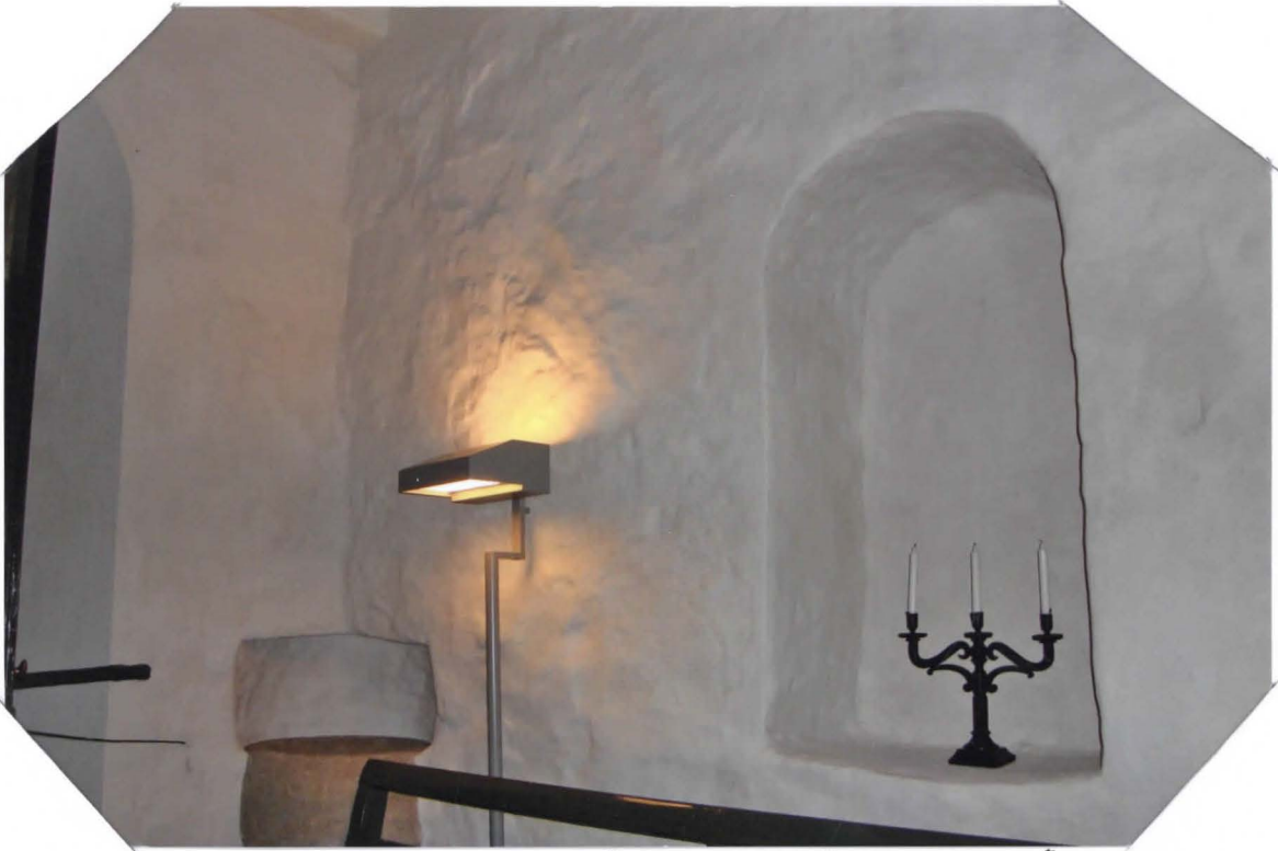
-ASEHUONEEN SEINÄPINTAA KÄSITELTYNÄ
