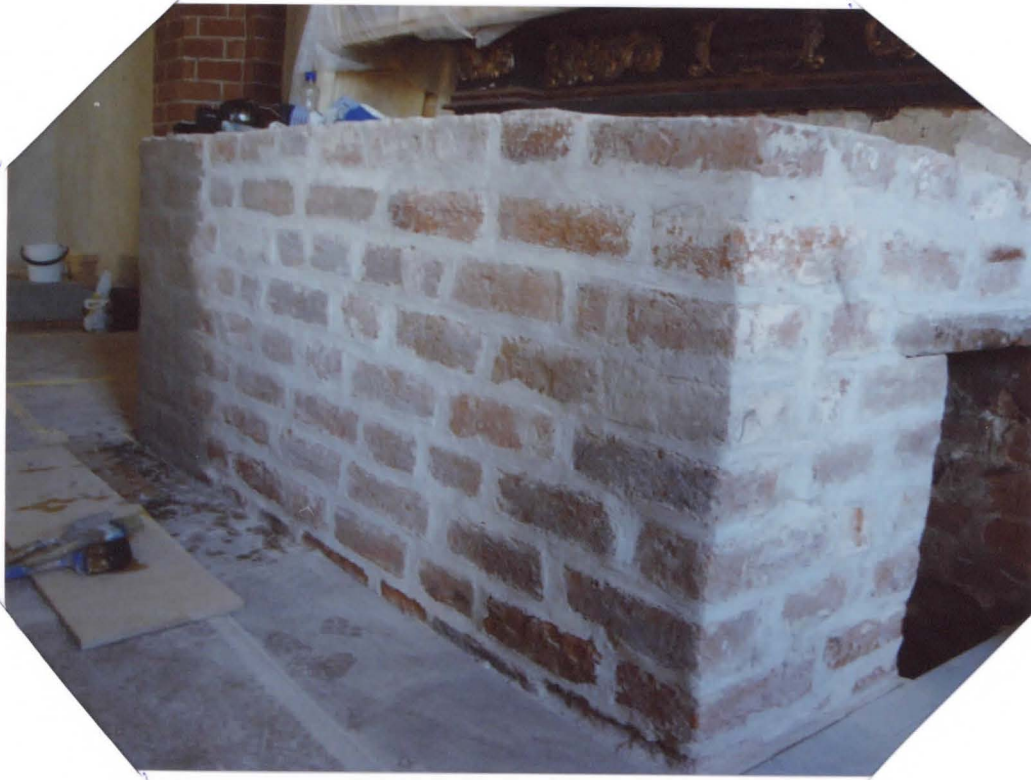
- KOROTUS POISTETTU, RAPPAUS ALOITETTU.
