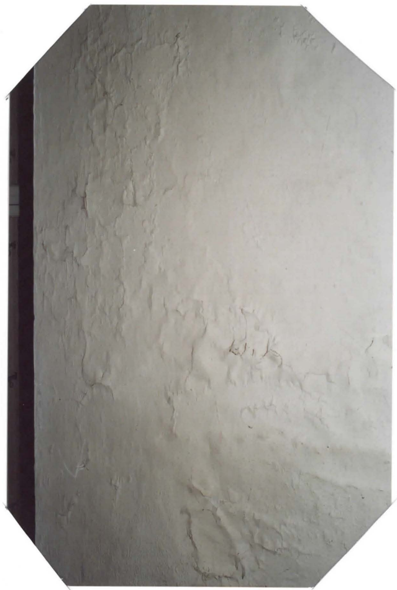
IRTOAVAA UUDEMPAA PINTAKÄSITTELYÄ - PINTAT TUTKIMUSVAIHEESSA
