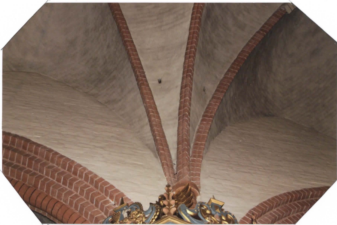
VAIN OHUT RAPPAUS TILILADELMIEN PÄÄLLÄ MUODOSTAA ERÄÄNLÄISEN HYLLYSTÖN, JONKA PÄÄLLE PÖLY LASKEUTUU TEHOKKAASTI.
