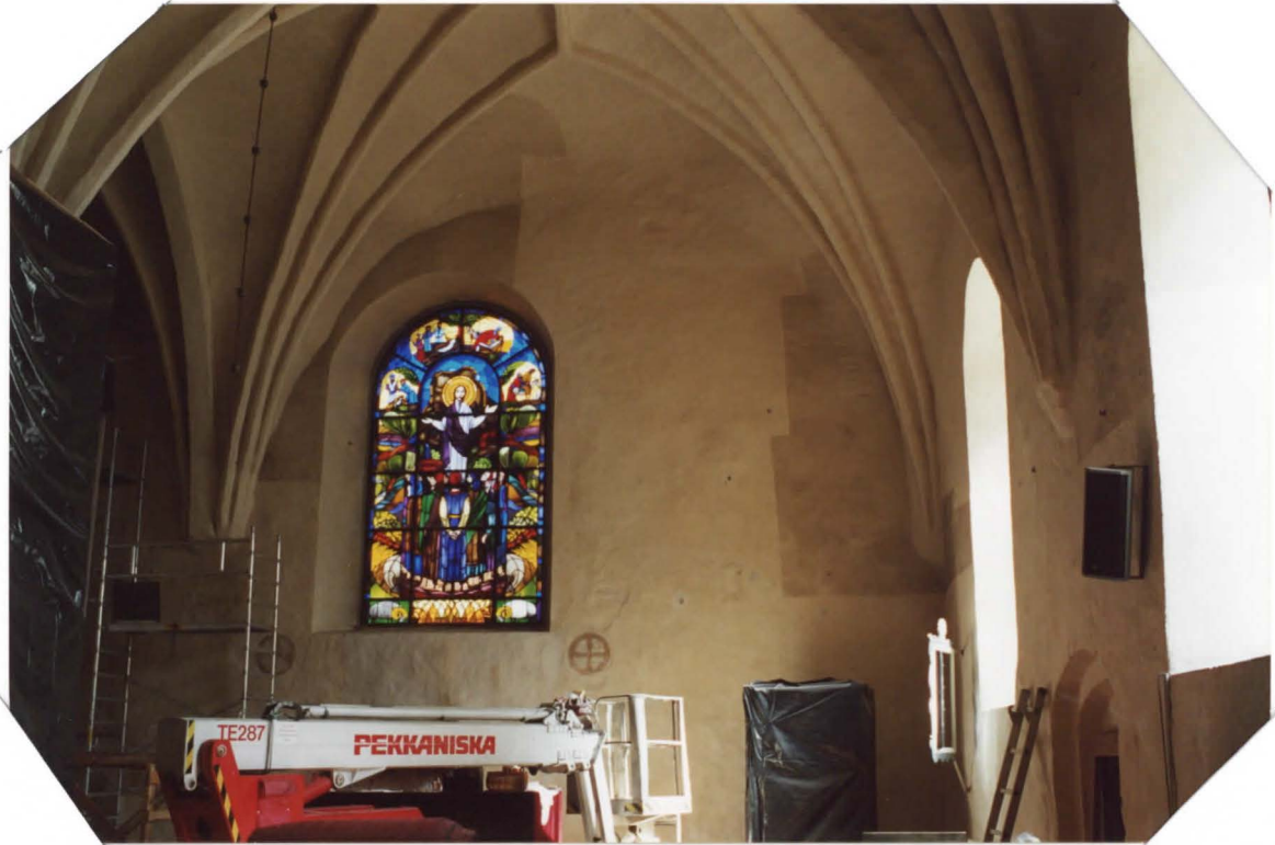
KUORI PUHDISTUSVAIHEESSA. - PUHDISTUSRAJAT
