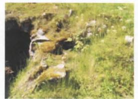
Ikkuna-aukko ennen raivausta
