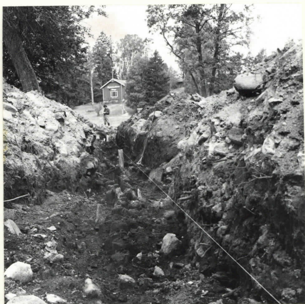
Paalutus eteläisen kehämuurin eteläpuolella Neg. n o 4/69
