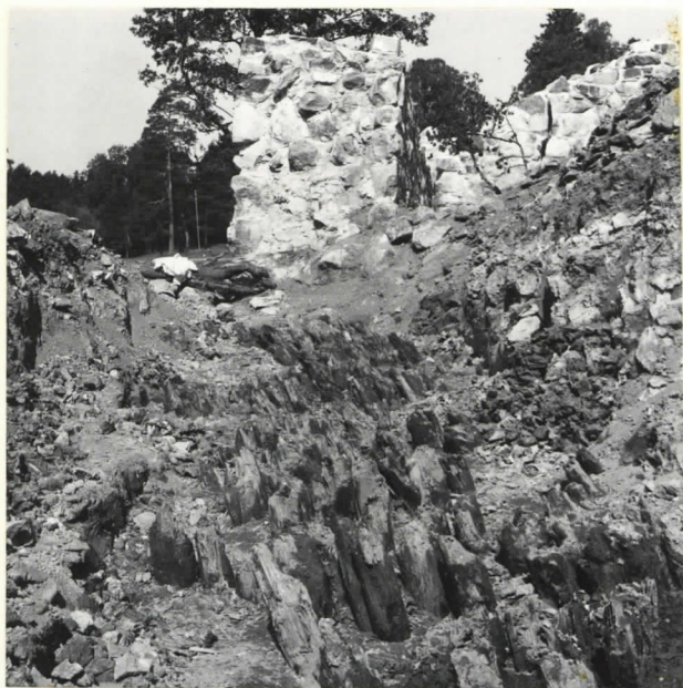
Eteläisen kehämuurin paalutusta Neg. n o 1/69
