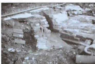
41 (11). Yleiskuvia koskenrannan rakenteista. 10.7.
