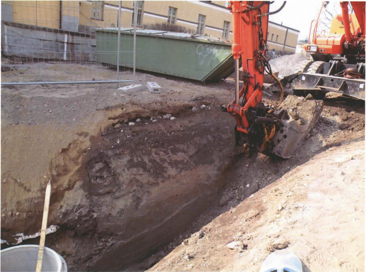
Kuva 1. Kaivaustyö käynnissä Tampereen teatterin ja Vanhan kirjastotalon välillä. Kerrokset pinnasta: hiekka, kivitie, sora ja savi. Kuvattu luoteesta. Kuvaaja: Kalle Luoto. KYY 11: 12.
