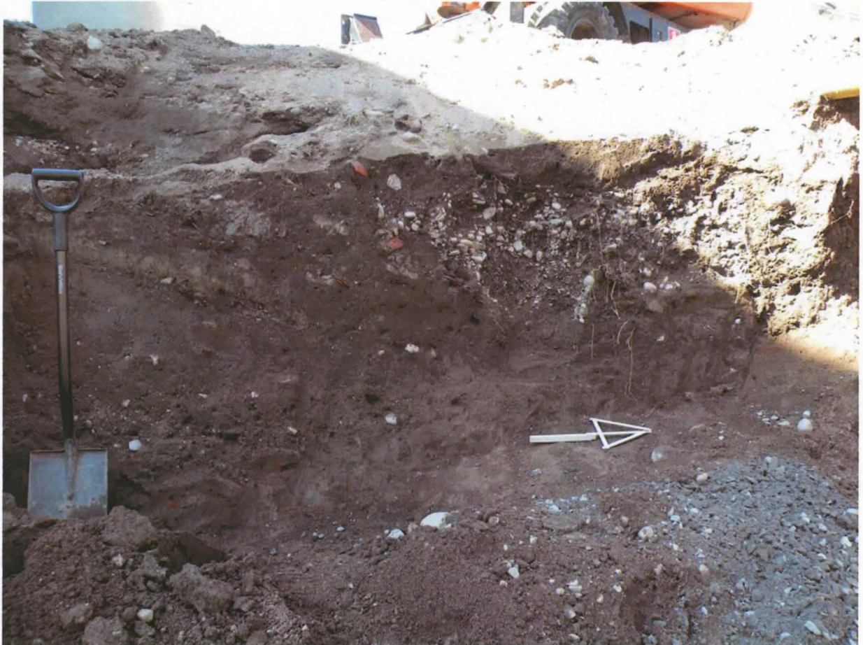
Kuva 5. Kaivannon profiili, jossa erottuvat Y104 ja Y 105. Oikealla aiemmin kaivettu putkilinja on tuhonnut osan yksiköistä. Kuvattu idästä. Kuvaja Kalle Luoto. KYY 11:10.
