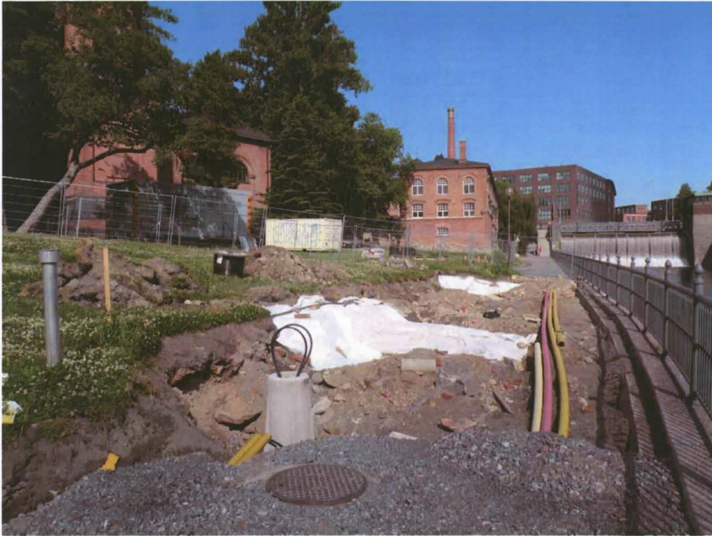
Kuva 18. Tammerkosken rannasta paljastuneet rakenteet peitettiin dokumentoinnin jälkeen. Kuvattu kaakosta. Kuvaaja Kalle Luoto. KY 11: 85.
