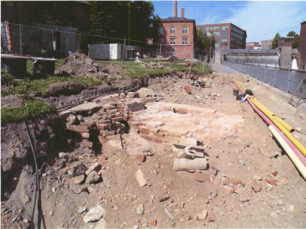
Kuva 14. Tammerkosken rannasta paljastunut rakenne S. Kuvassa Frencellin massahiomon tiiliset perustukset. Taustalla Frencellin rakennuksia, oikealla Tammerkoski. Kuvattu kaakosta. Kuvaaja Kalle Luoto. KY 11:75.
