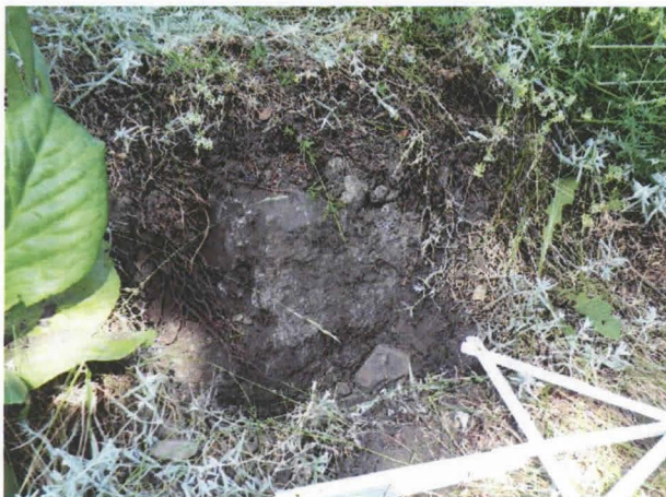
Kuva 2. Mäkikatu 24:n betonista kattorakennetta. 7.7.2009, Kalle Luoto. KY 18: 12.
