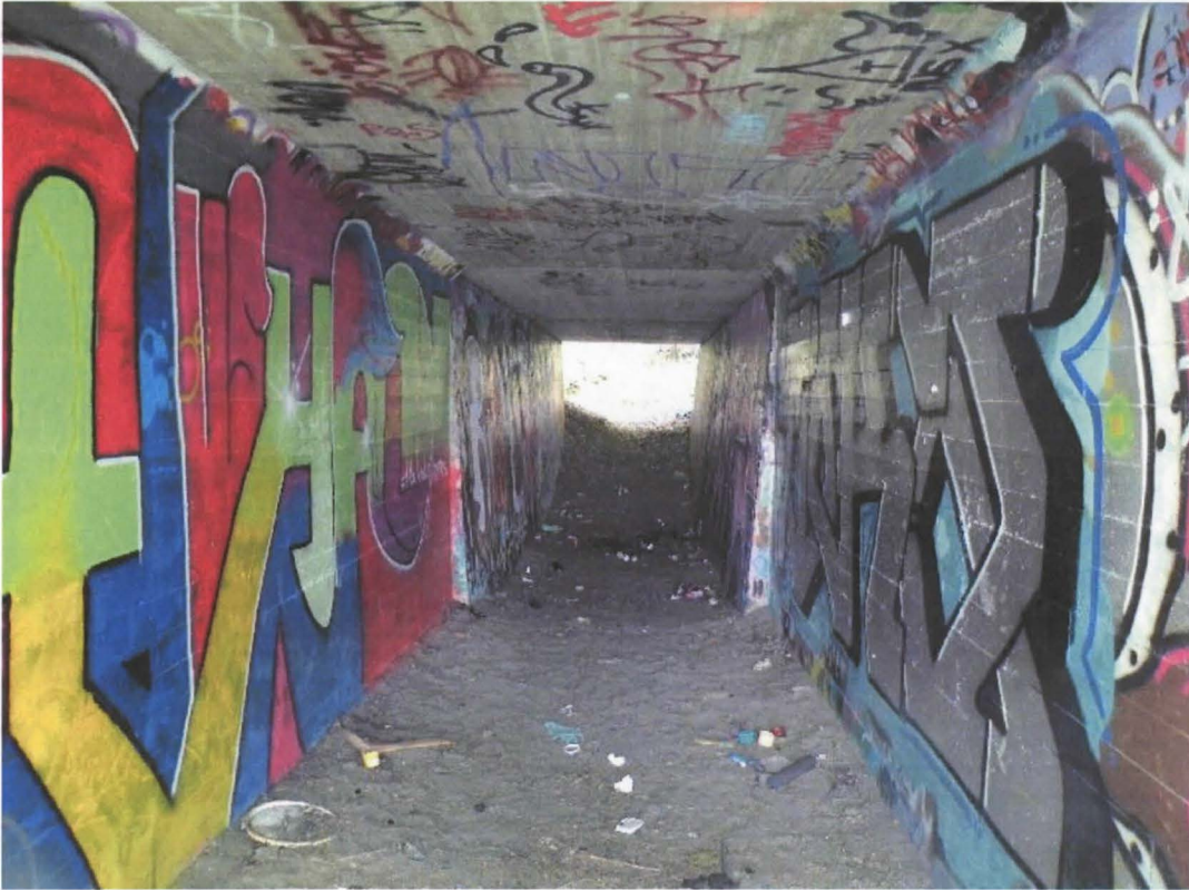
Kuva 12. Näkymä tunnelin Näsijärven päästä kohti lounasta. 22.7.2009, Kalle Luoto. KYY 18:25.
