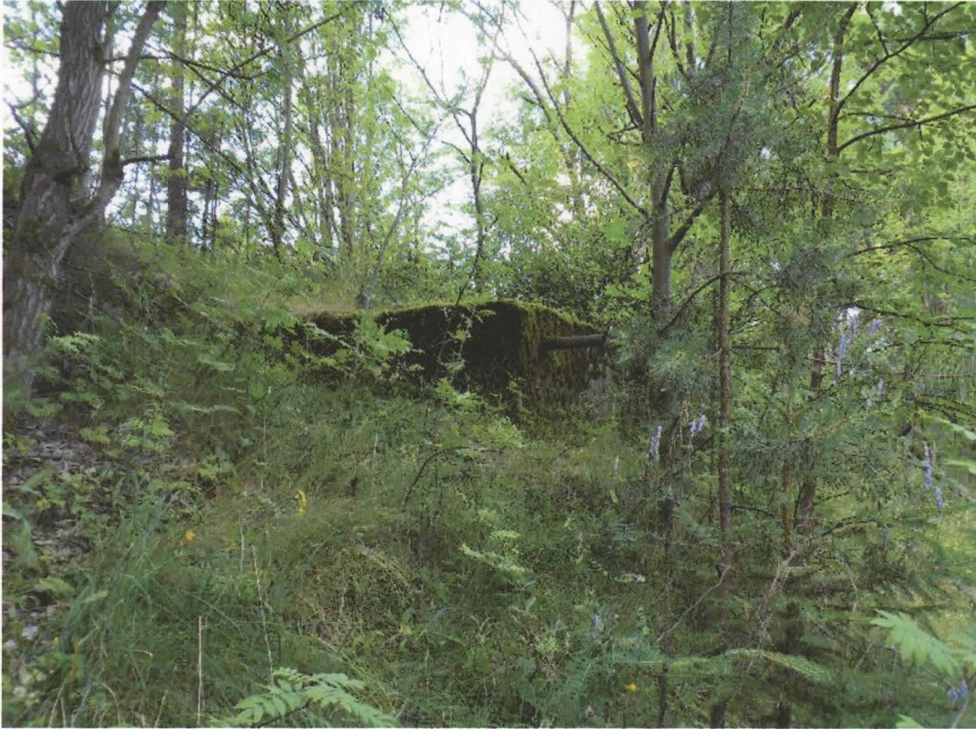
Kuva 22. Betonirakenne radanvarressa Rantatie 9:n kohdalla. 24.7.2009, Kalle Luoto. KYY 18:20.
