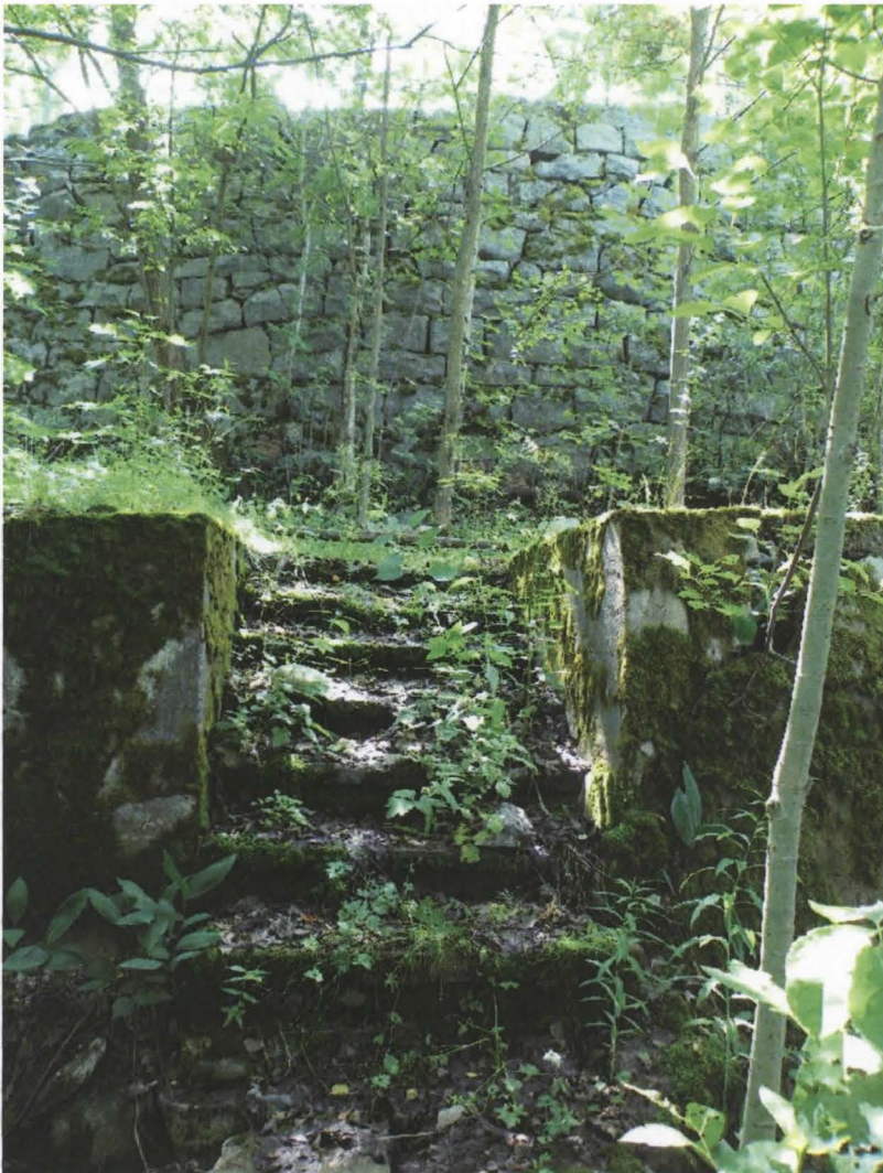
Kuva 7. Santalahden aseman rakenteita. Kuvattu pohjoisesta. 22.7.2009, Kalle Luoto. KY 18:5.
