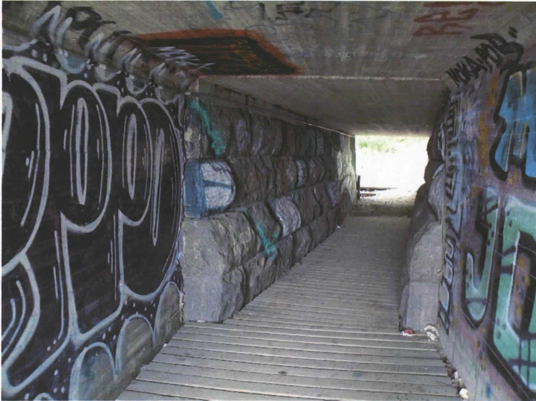
Kuva 9. Ahjolan alikulkutunneli nykyasussaan. 22.7.2009, Kalle Luoto. KY 18:22.
