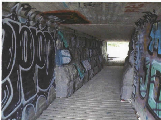
Kuva 8. Ahjolan alikulkutunneli nykyasussaan. 22.7.2009, Kalle Luoto. KY 18:22.
