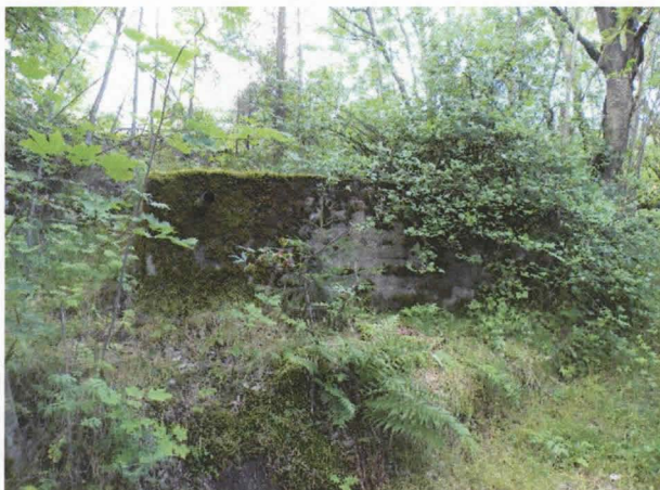
Kuva 19. Betonirakenne Rantatie 9:n kohdalla junanradan varressa. Kuvattu koillisesta. 24.7.2009, Kalle Luoto. KYK 18:19.
