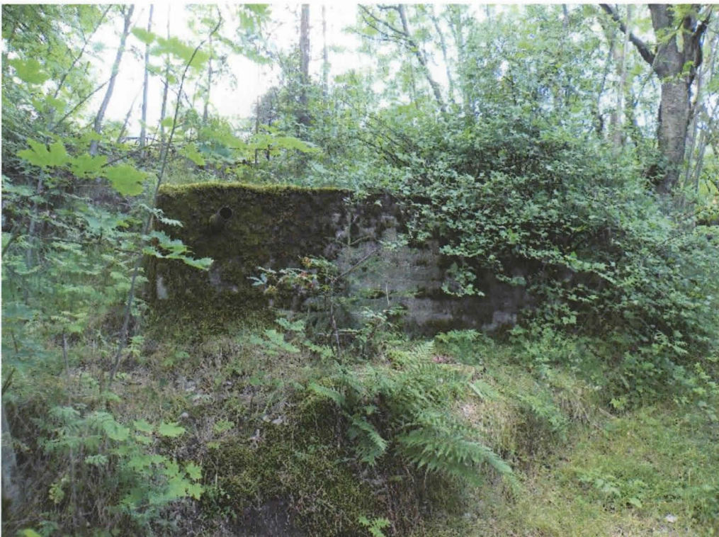
Kuva 21. Betonirakenne Rantatie 9:n kohdalla junanradan varressa. Kuvattu koillisesta. 24.7.2009, Kalle Luoto. KYY 18:19.
