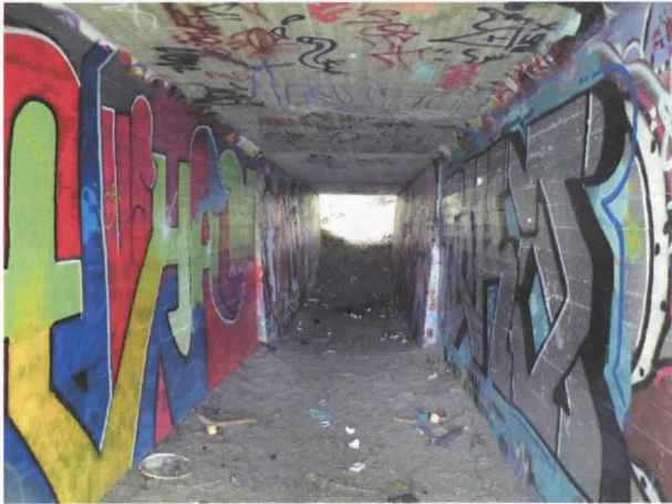
Kuva 11. Näkymä tunnelin Näsijärven päästä kohti kirkkoa. 22.7.2009, Kalle Luoto. KY 18:25.
