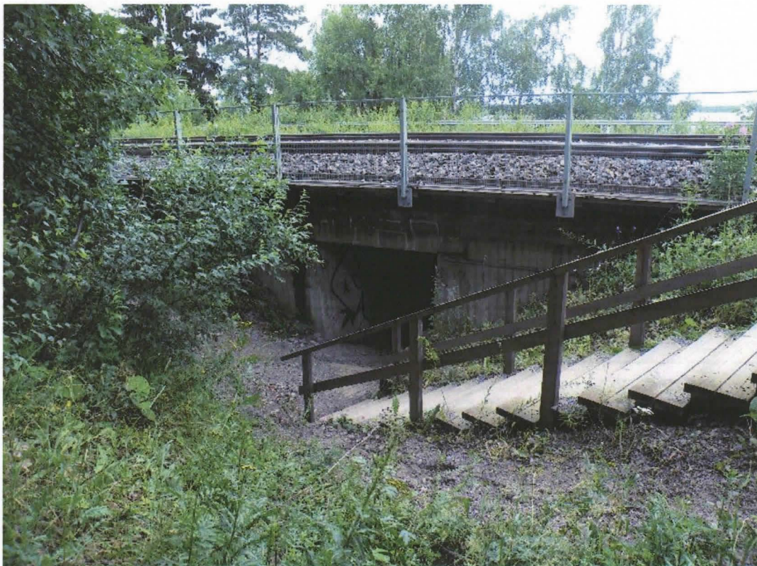
Kuva 10. Ahjolan alikulkutunnelin eteläinen suuaukko. Kuvattu kaakosta. 22.7.2009, Kalle Luoto. KY 18:24.
