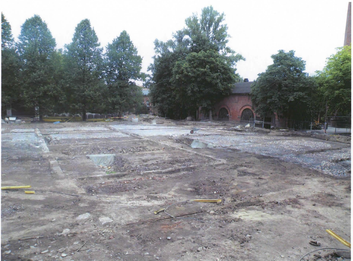
Kuva 9. Kuvan etualalla kartoitusalueen lounaisosaa, joka koostui rakentamis- tai purkukerroksesta, jonka päälle oli yksikertaisesti rakennettu kiskot. Alueella risteili myös nuorempia sähkölinjoja, joiden keltaiset suoja-putket erottuvat kuvassa. Kivetyn teollisuuspihan reuna erottuu selkeänä alueena taustalla. Kuvattu lounaasta. Kuvaja: Kalle Luoto. 27.8.2010.
