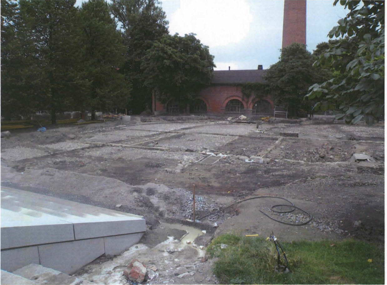
Kuva 10. Kivettyä teollisuuspihaa kartoitusalueen lounaisosassa. Vasemmalla etualalla uudet kiviportaat. Kuvaja: Kalle Luoto. Kuvattu lounaasta 27.8.2010.
