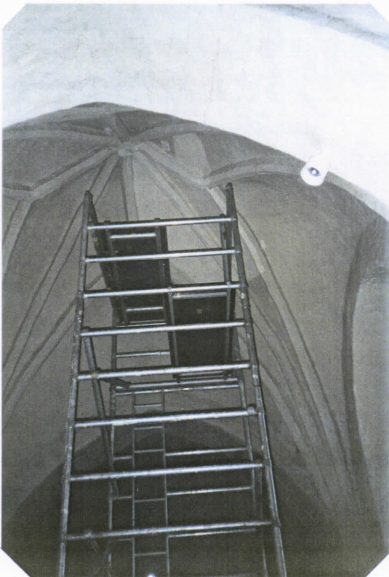
telineen yllä puhdistettua holvipintaa
