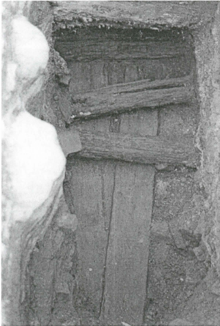
Kuva 4. Lautalattiaa kuvan 2 hirsirakennuksessa. Kuvan yläkulmassa näkyy rakennuksen toista veistettyä hirsiseinää. Lattialautojen päällä on luultavasti kattoa tukeneita kurkihirsiä.
