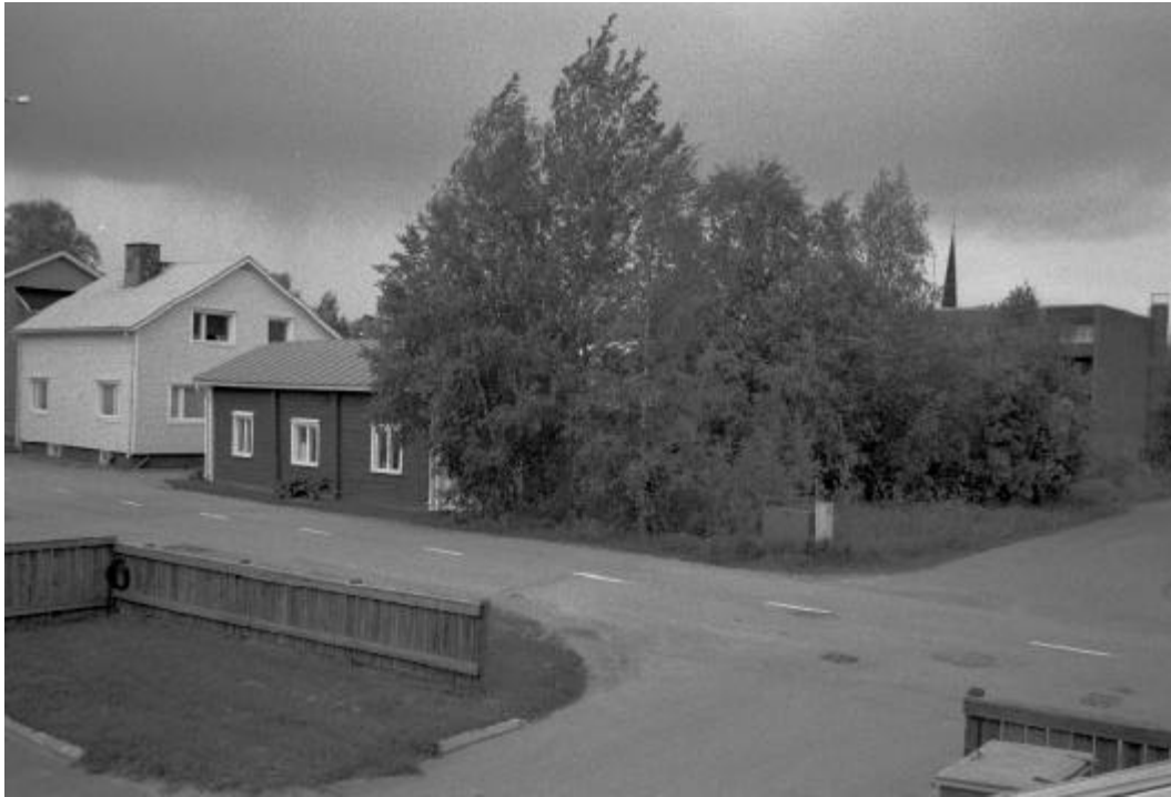
124530: 3. Tontit 00500040010 ja 00500040014 kuvattuna Keskikadun yli. Rakennetun tontin (00500040010) oikealla puolella Keskikadun ja Nahkurinkadun kulmassa oleva ruohoalue on tonttia 00500040014. Kohti NE.
