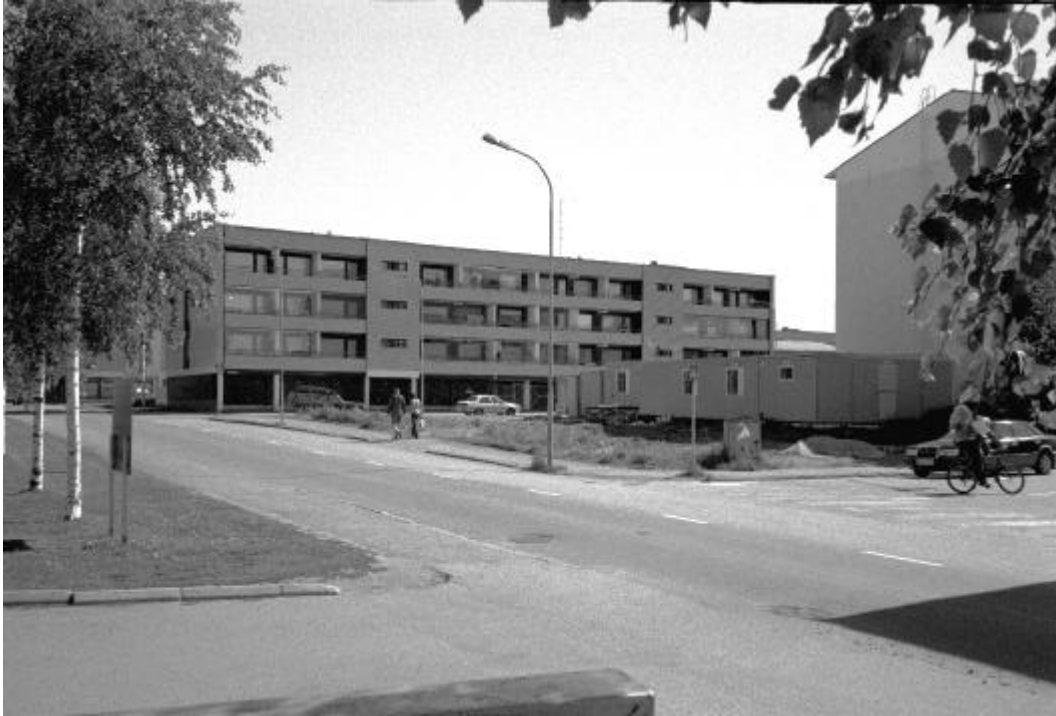
124530: 26. Tyhjällä tontilla (00200030008), kuvan oikeassa reunassa auton takana, on irtomaakasa, joka kätkee allensa vanhan kellarin. Taustalla näkyvän kerrostalon (00200060001) kuvassa vasemman puoleisen kulman alla on myös todennäköisesti säilynyt kellari. Kohti E.
