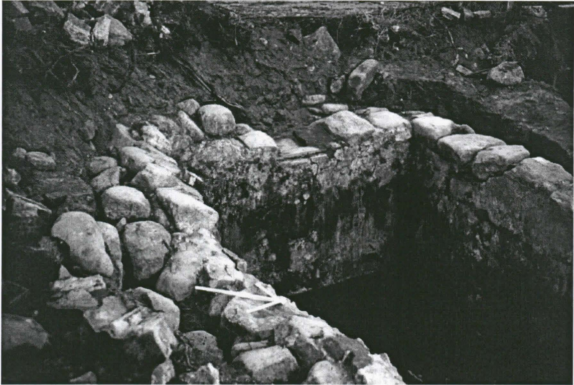
Kuva 3. Tornio Govenius (dia nro. 41). Kellarin takaosa ja seinien kivirakennetta kaakkoisseinän päältä kuvattuna. Suunta 300. (Kuva Tornionlaakson maakuntamuseon kokoelmassa).
