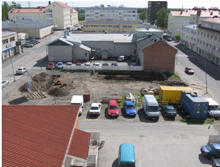
Kuva 1. Digitaalinen kuva 217922: 95. Tontti II/2/4 kuvattuna itään. Kuva on otettu viereisen tontin (II/3/6) tuolloin rakenteilla olleen kerrostalon katolta.
