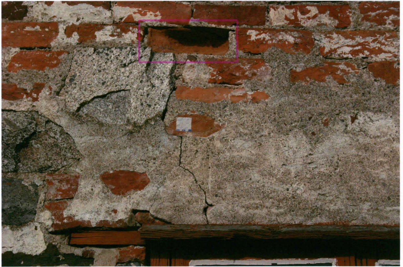
Ikkunan F4 yläpuoli
