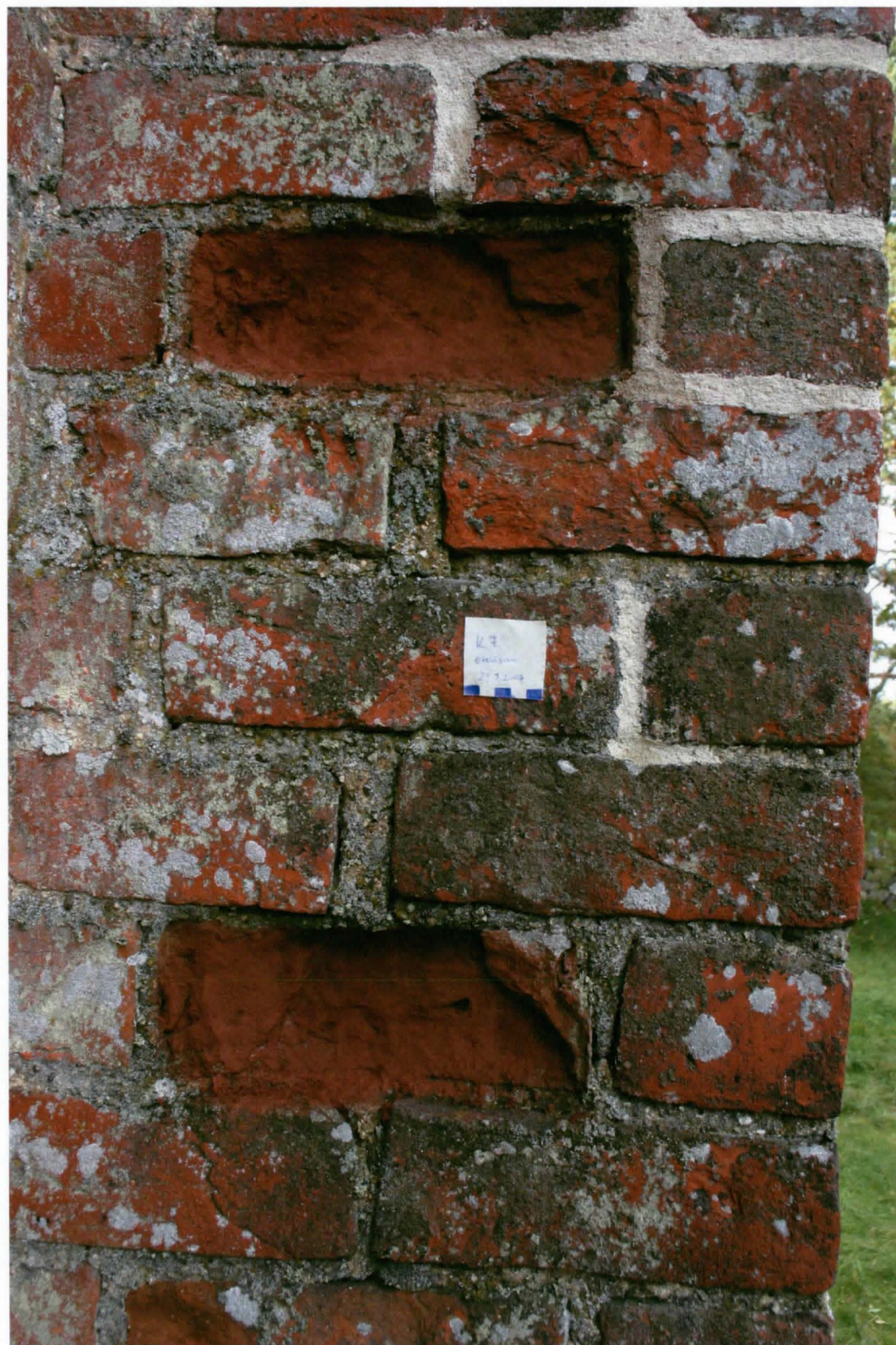
Itäseinän K7-tukipilarin eteläpuolen uhrilaastilla käsitellyt tiilet.
