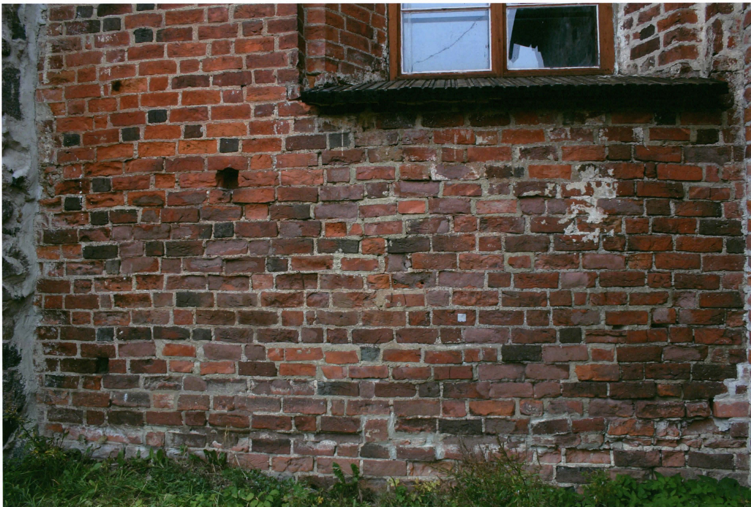
Eteläseinä, F3-ikkunan alapuoli, kokonaisuudessaan
