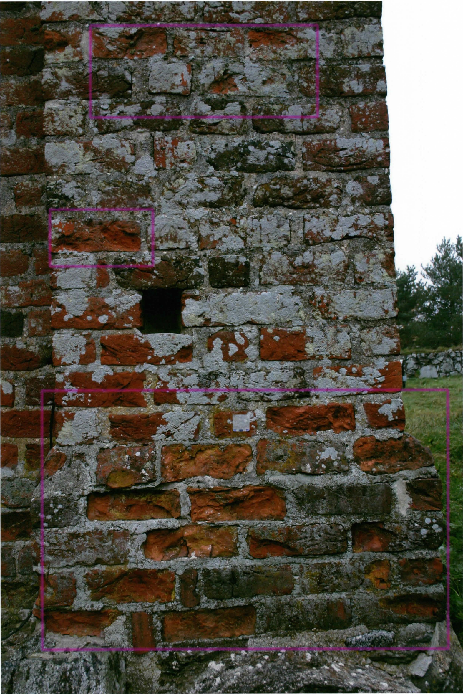
Sakastin K8-tukipilarin itäpuolen alaosan rapautuneet tiilet
