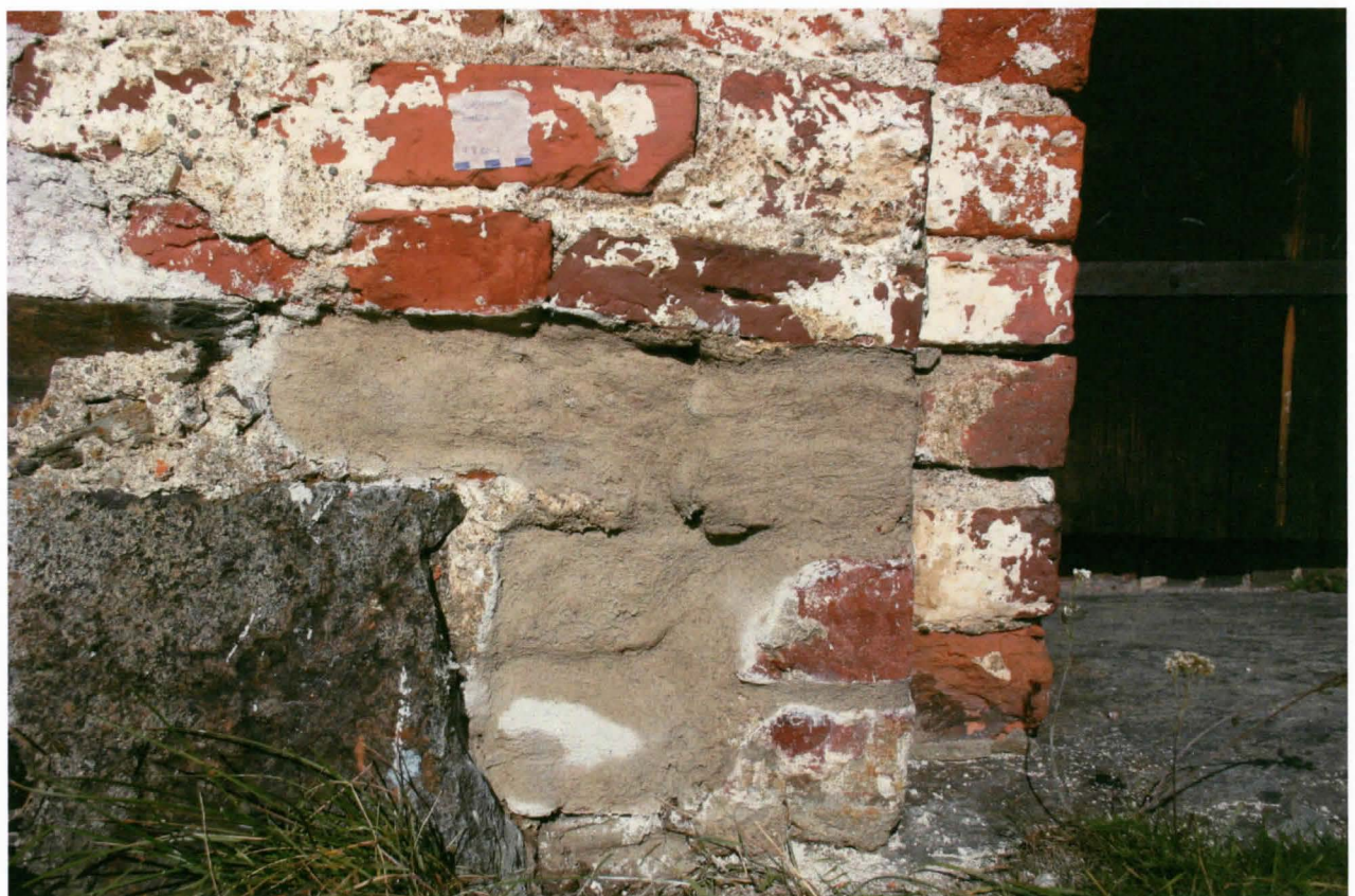
Asehuoneen oven vasen puoli
