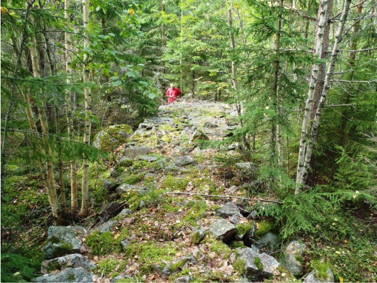
Kuva 8: Loviisan Kuggomissa (Lurens) törmättiin kiviaidan pätkiin, jotka osoittautuivat 1900 –luvun alussa tehdyn turvesuolle menneen rautatien varteen kasatuiksi rakennelmiksi. Rautatie on hävinnyt jo aikoja sitten ja sen paikalla menee nykyisin tavallinen tie. Haastattelussa saadun muistitiedon varmisti oikeaksi kirjallinen lähde ja näin kohteen tarkoitus ja ajoitus saatiin selvitettyiksi.
