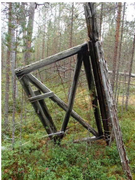
Piikkilankaportti rakennuksen 2 vieressä, kuvattu lounaaseen.
