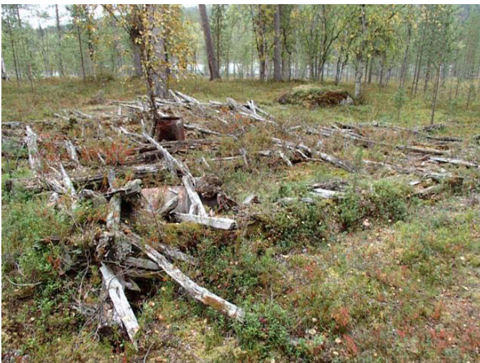
Kämpästä 3 on jäljellä lähinnä kattorakenteita, kuvattu etelään.
