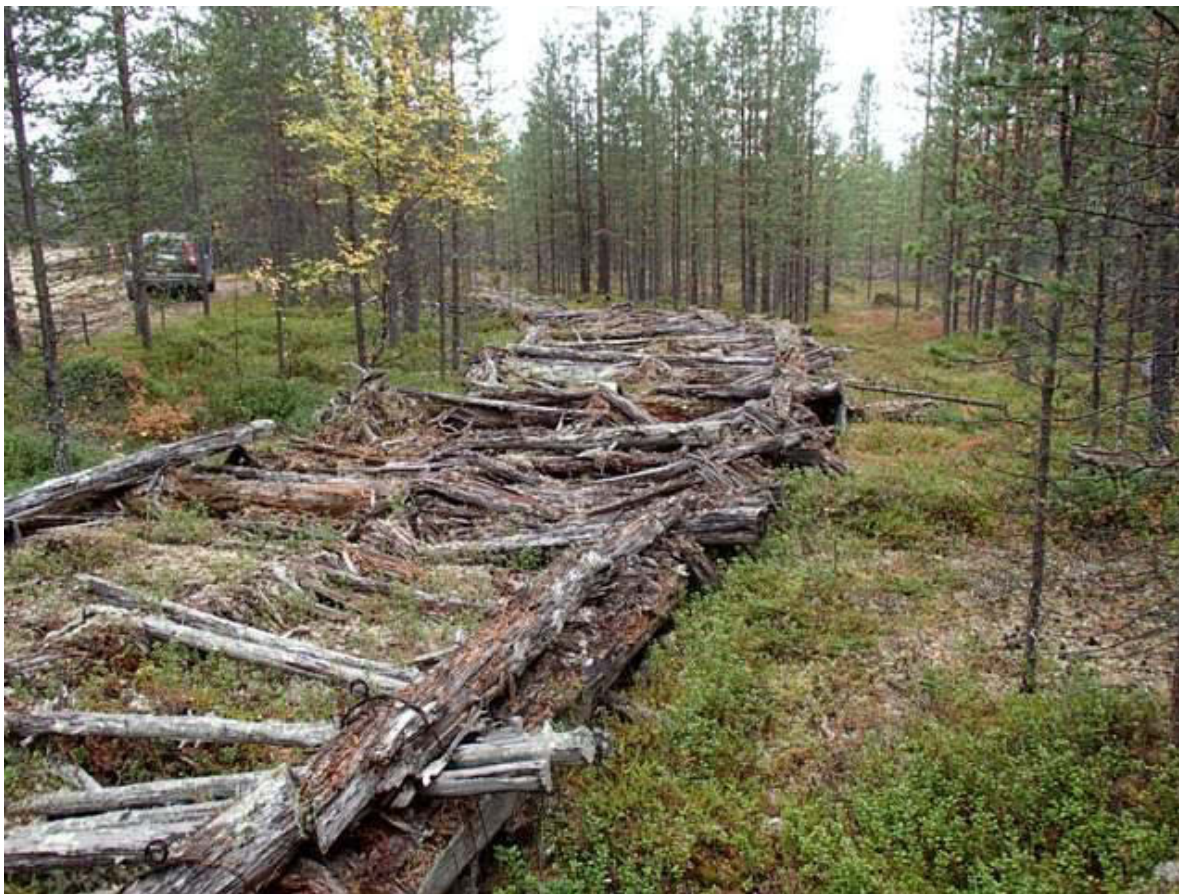
Kapulatie nykyisen tielinjan luoteispuolella, etualalla näkyvässä rautalankasidos jolla reunapuut on kiinnitetty, kuvattu lounaaseen.
