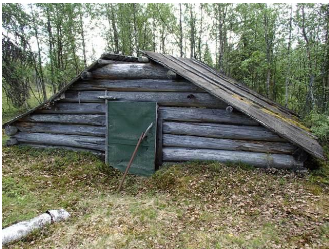
Yleiskuva ulkoa, kuvattu kaakkoon.
