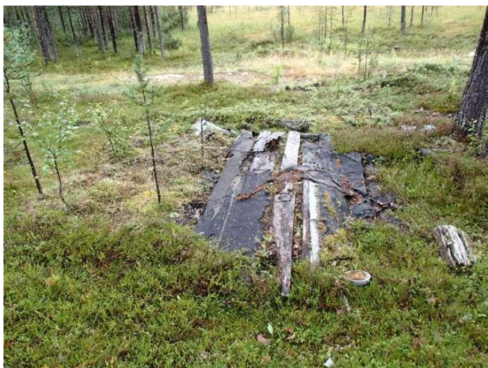
Pienen rakennuksen pohja ja katon jäänteitä, kuvattu länteen.
