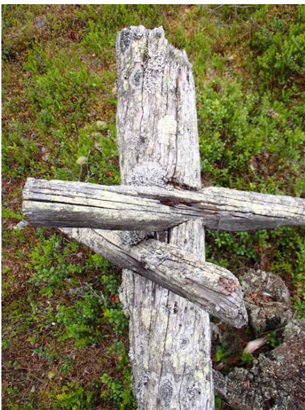
Jalat on kiinnitetty lohenpyrstöliitoksin.
