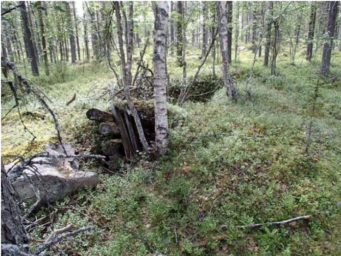
Kellarin katto on sortunut, kuvattu etelään.
