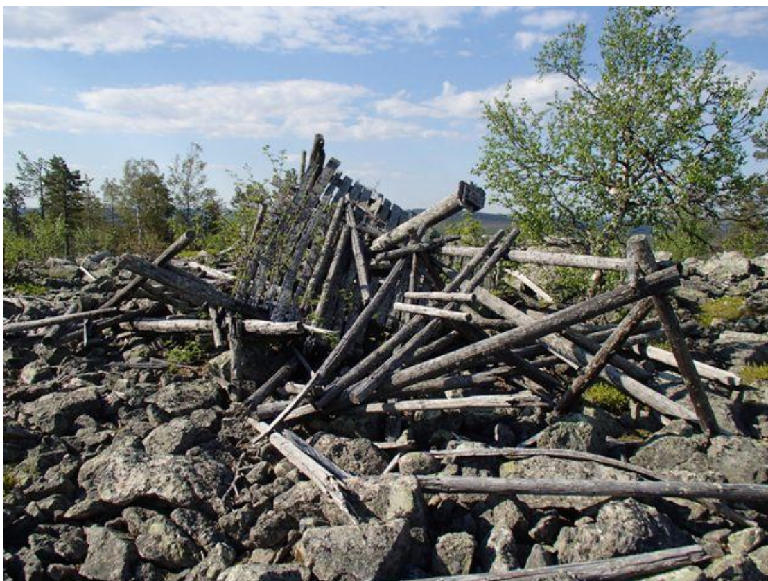
Kolmiomittaustornin yläosan rakenteita kuvattuna etelään.
