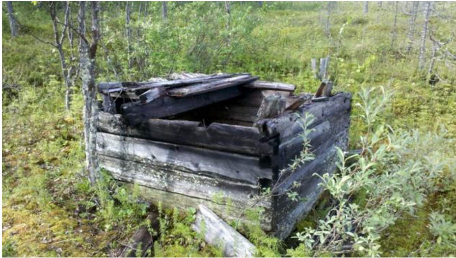
Kaivon 1 nurkissa on lohenpyrstösälvokset, kuvattu lounaaseen.
