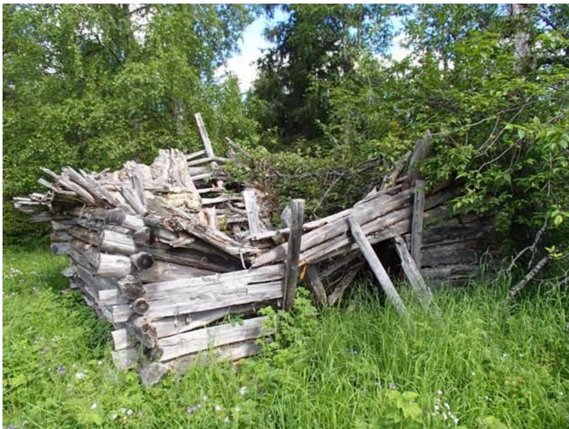
Yleiskuva ladosta, kuvaussuunta luoteeseen.
