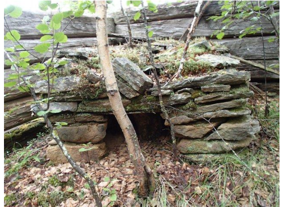
Rakennuksen 3 sisällä oleva piisi, kuvattu luoteeseen.
