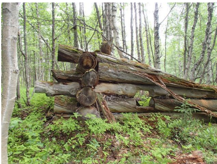
Rakennuksen 1 länsinurkassa on säilynyt useita hirsikertoja, kuvattu koilliseen.
