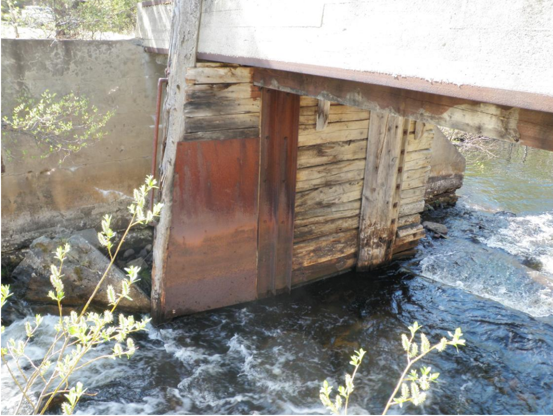
Uittopadon rakenteita nykyisen sillan alla.
