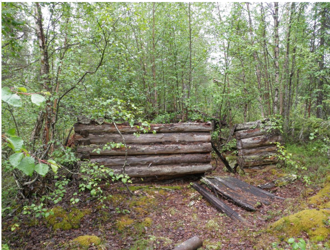
Rakennuksen oviaukko ja etuseinä.
