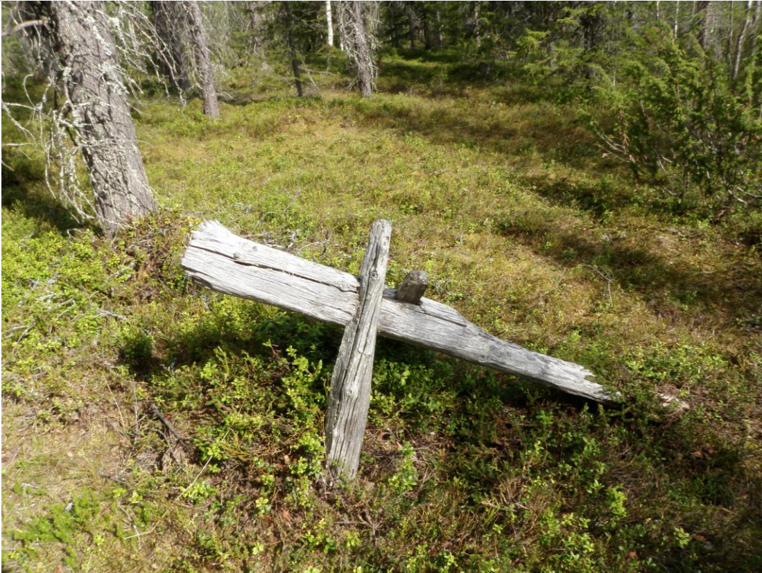
Pukin jalat on kiinnitetty salvoksin.
