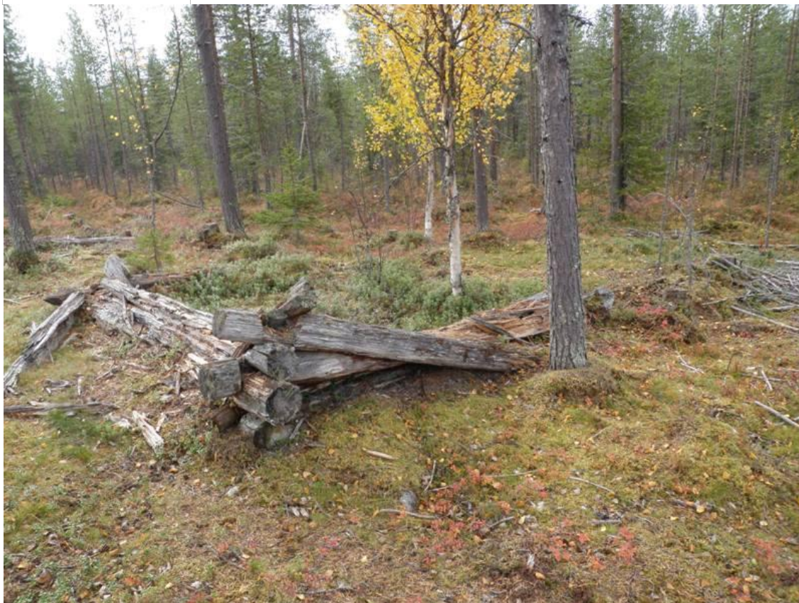
Rakennuksen viimeiset hirsisalvokset.
