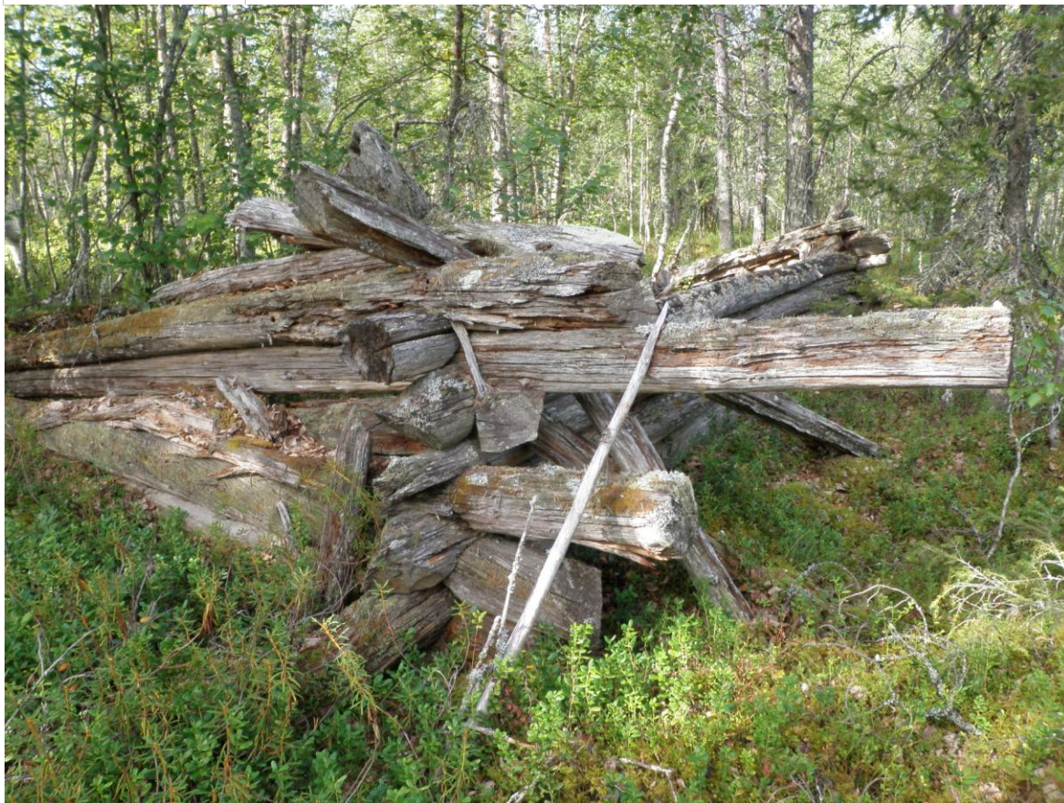
Rakennuksen 1 nurkkasalvoksia.
