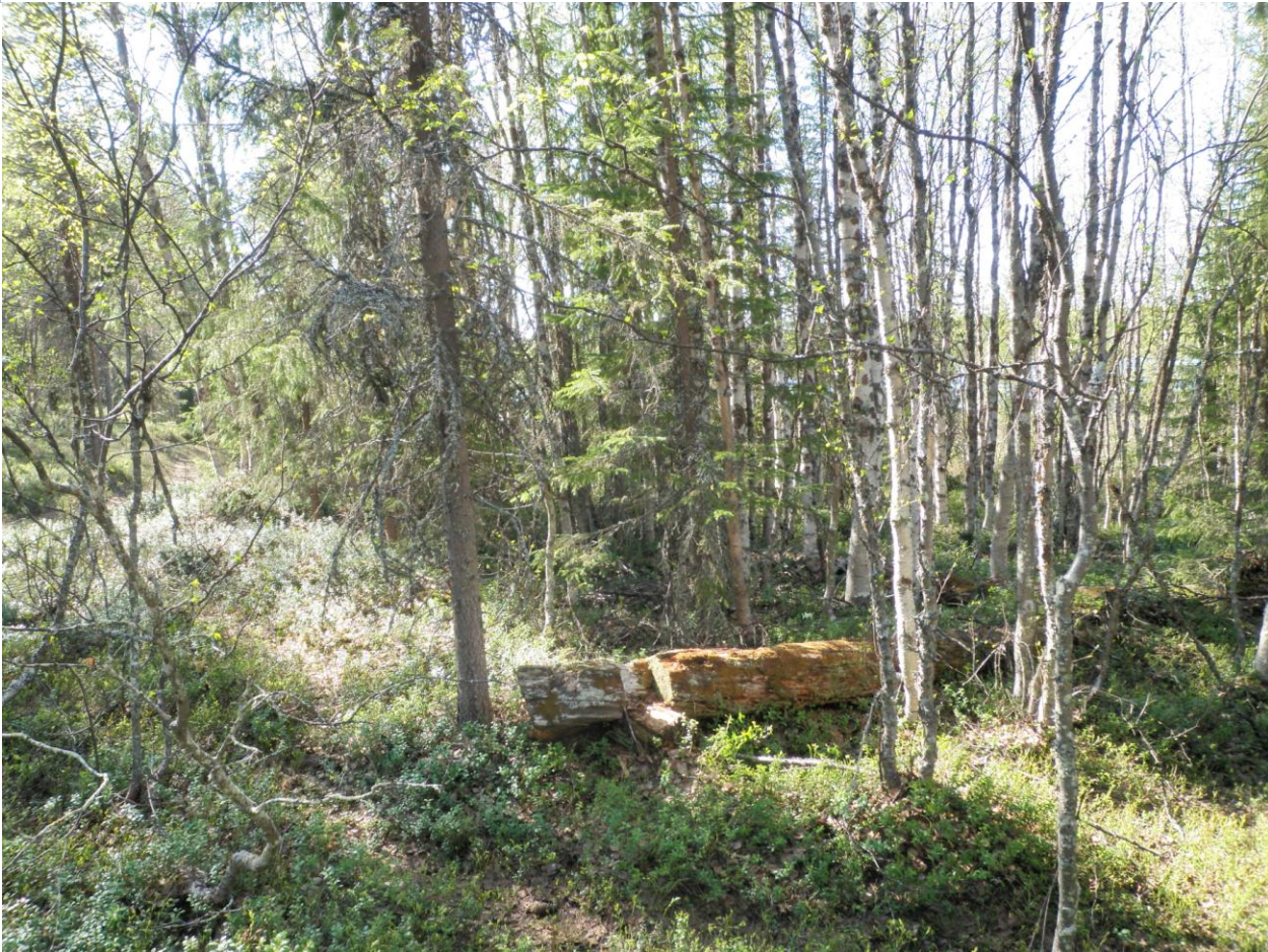
Hirsirakenteita kasvillisuuden peitossa.
