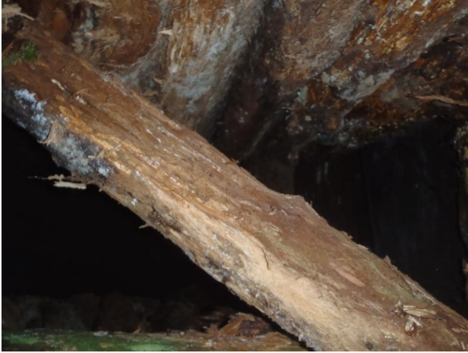
Änäkäinen Markunlampi kaivanto 6n pohjalla olevan aukon sisäosaa.
