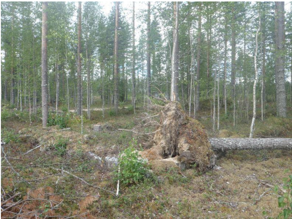
Jukolan motti. Kaatuneen puun juuret ovat siirtäneet rakennuksen kivijalan kiviä pois paikoiltaan. Kivivaaran tie taustalla. Kuvattu kaakosta.
