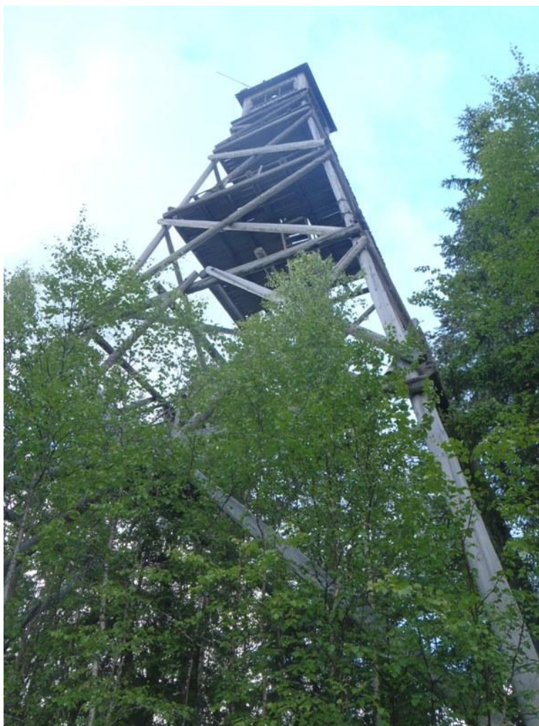
LIE093 Laklavaara 2 palovartiotorni. Kuva luoteesta.
