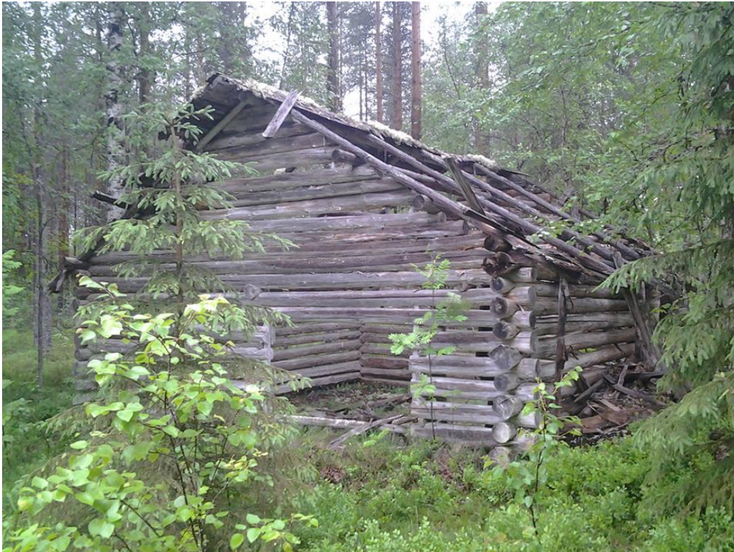
LIE195 Suuripää heinälato. Kuvattu pohjoisesta.
