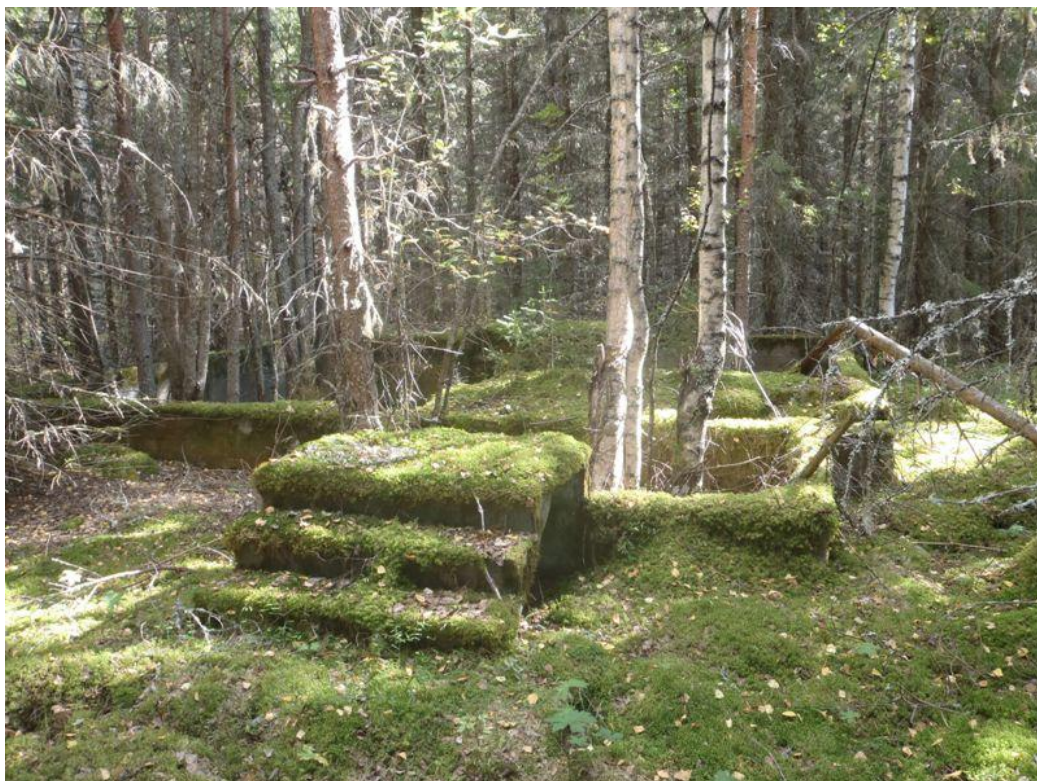
LIE190 Rajalan tila rakennus 2.
