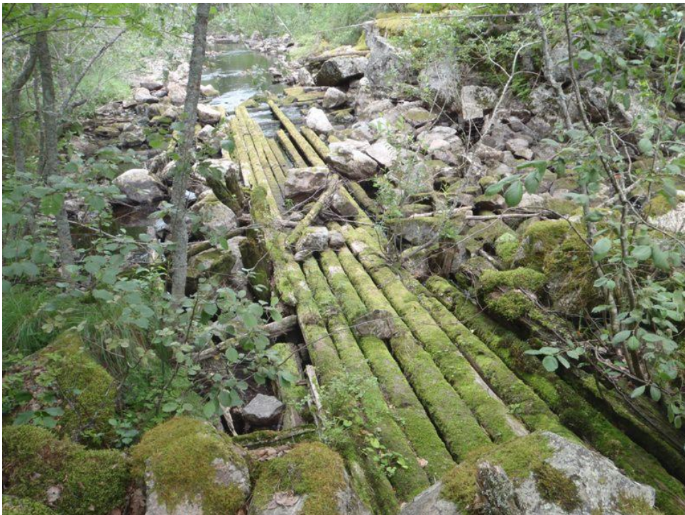
LIE136 Haukikoski uittopadon ränniä. Kuvattu etelästä.
