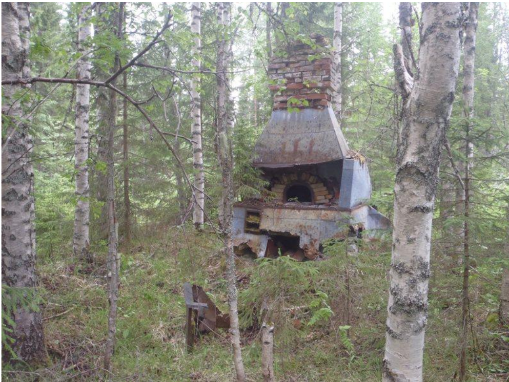
LIE103 Hanhiaho rakennus 1 uunin jäännös. Kuvattu etelästä.
