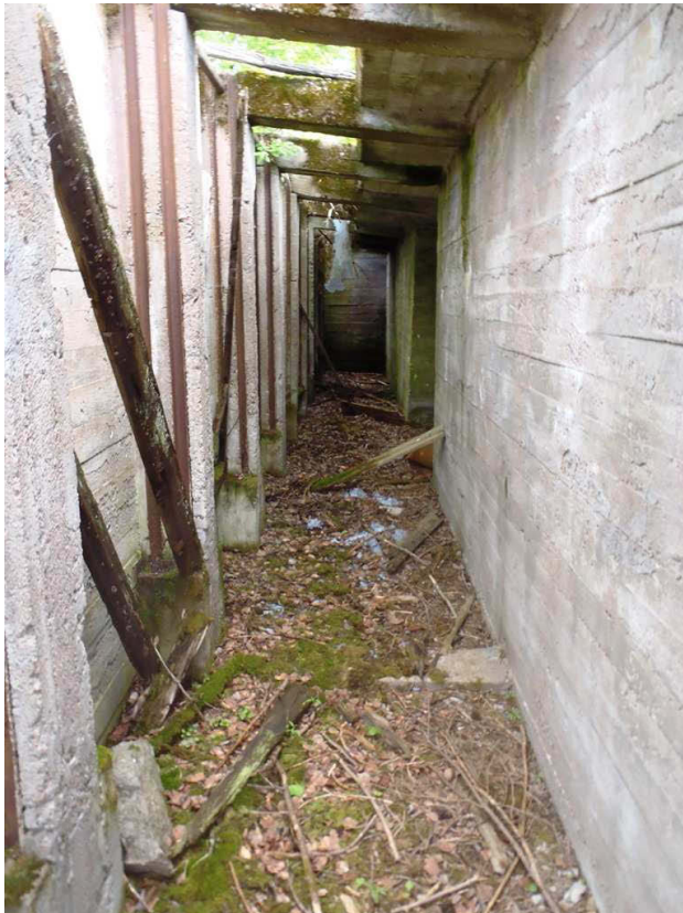
Kuva 9. Betoninen ampumataulubunkkeri. © Metsähallitus
