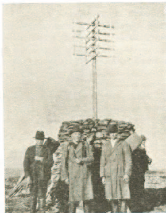
Kuva 5. Kivistä tehty tähysmerkki. Oratunturi.
