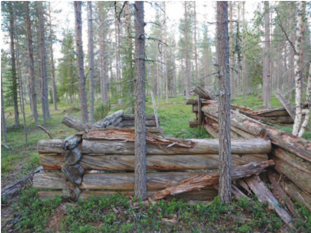
Vyötämöselkä 7 talli varastohuone. Kuva: Aki Hakonen/MH.
