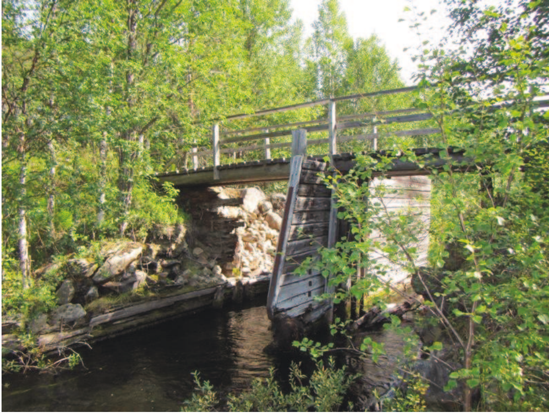
Seipäjoki 1 uittotammi koilliseen. Kuva: Siiri Tolonen/MH.
