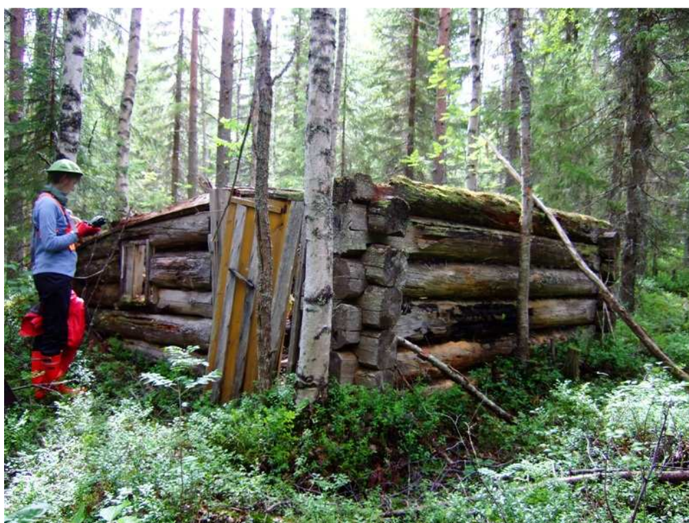
Kivijärvi rakennus jäännös.
