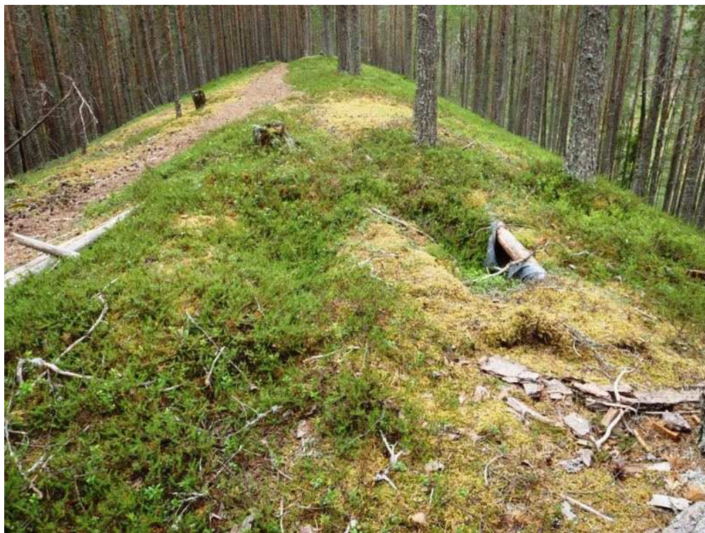
Rakenteessa on käytetty muovia tiivisteenä/suojana.
