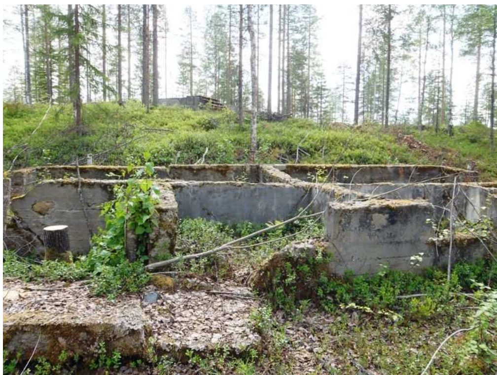
Rinteen alapuolella on betonisia varastojen pohjia.
