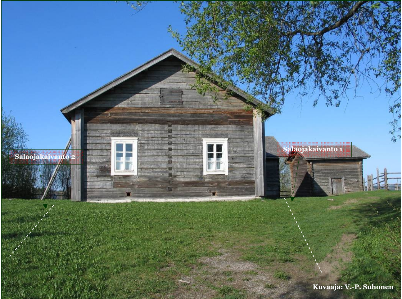
Kuva 3: Salaojakaivantojen paikat ennen kaivutöiden aloittamista.
