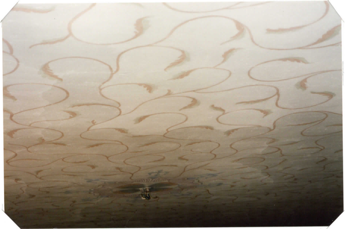
URKUPARVEEN ALAKATTOA OSIN PUHDISTETUNA
