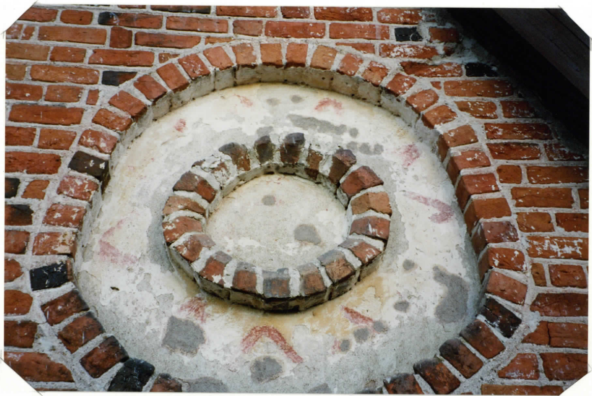
OIKEA PYÖRÖKOMERO -rakenteesta kiinnitystä
