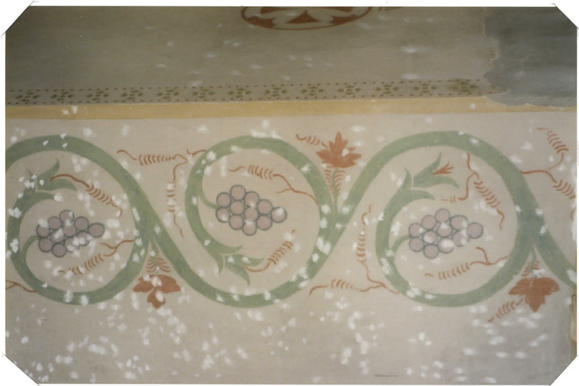
ETELÄPUOLEN KUORI-IKUNNAN REIKIÄ PAIKATTU
