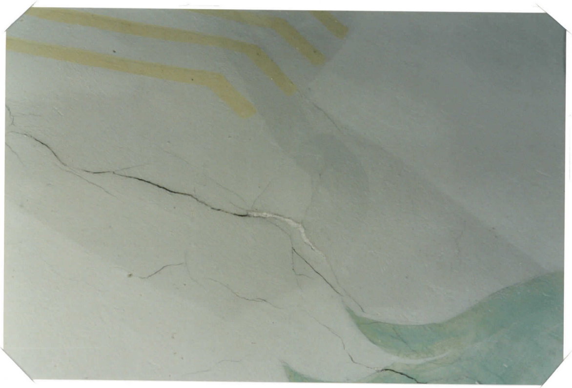
HOLVIPINTA 3B INJEKTOTAVAA PINTAA ESI EIINNETTY
