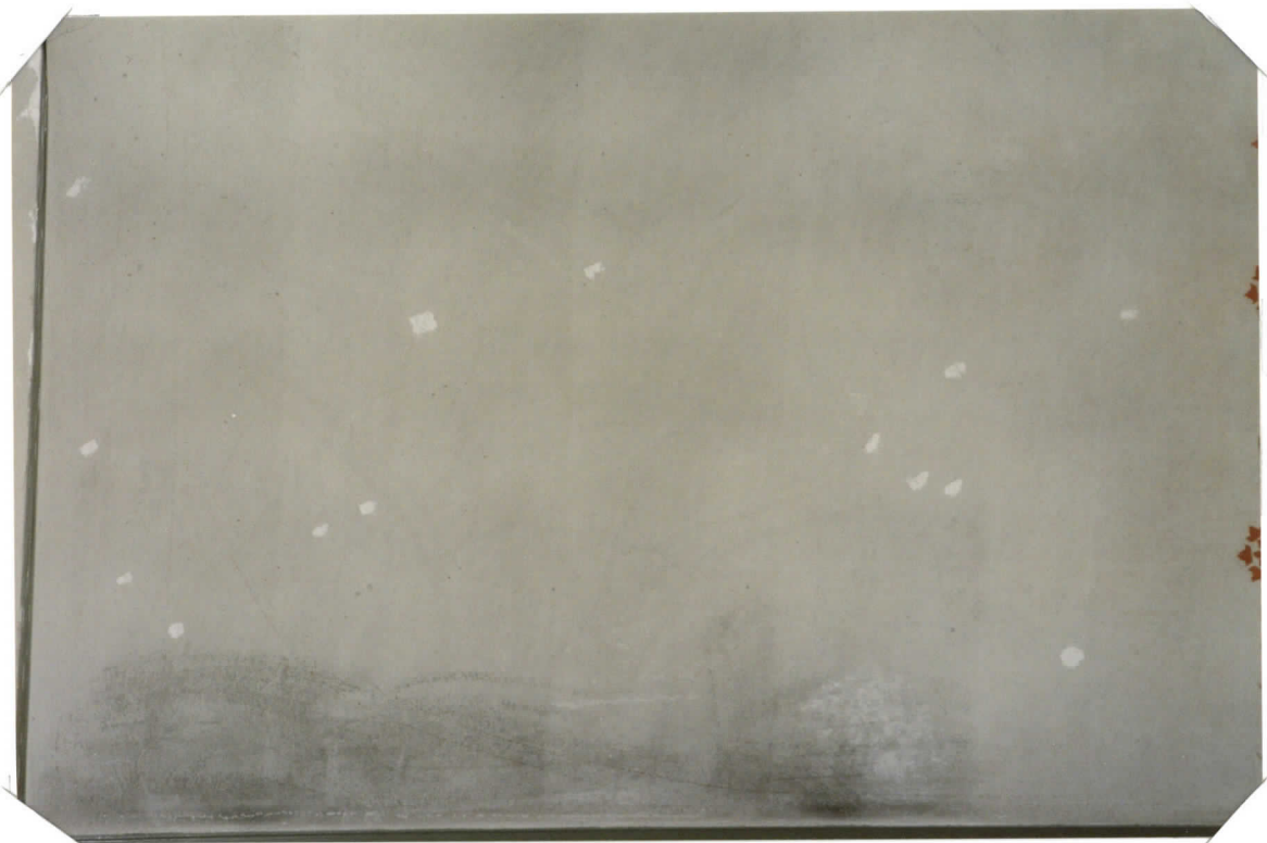
KASTEKAPPELIN OIK. PUOL. ET. SEINÄN ALAOSAA
