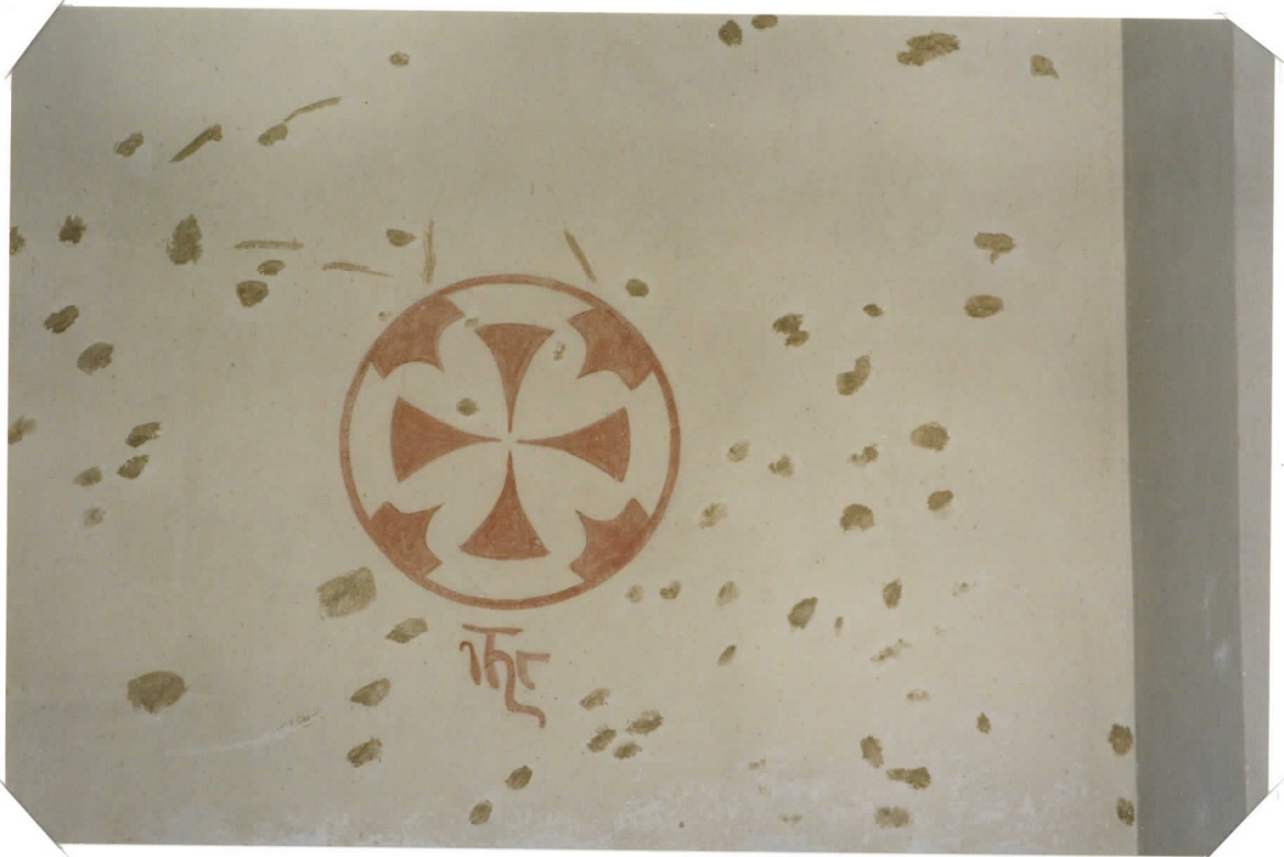
ET. SEINÄN PAIKKAUSTEN HÄIVYTYSTÄ
