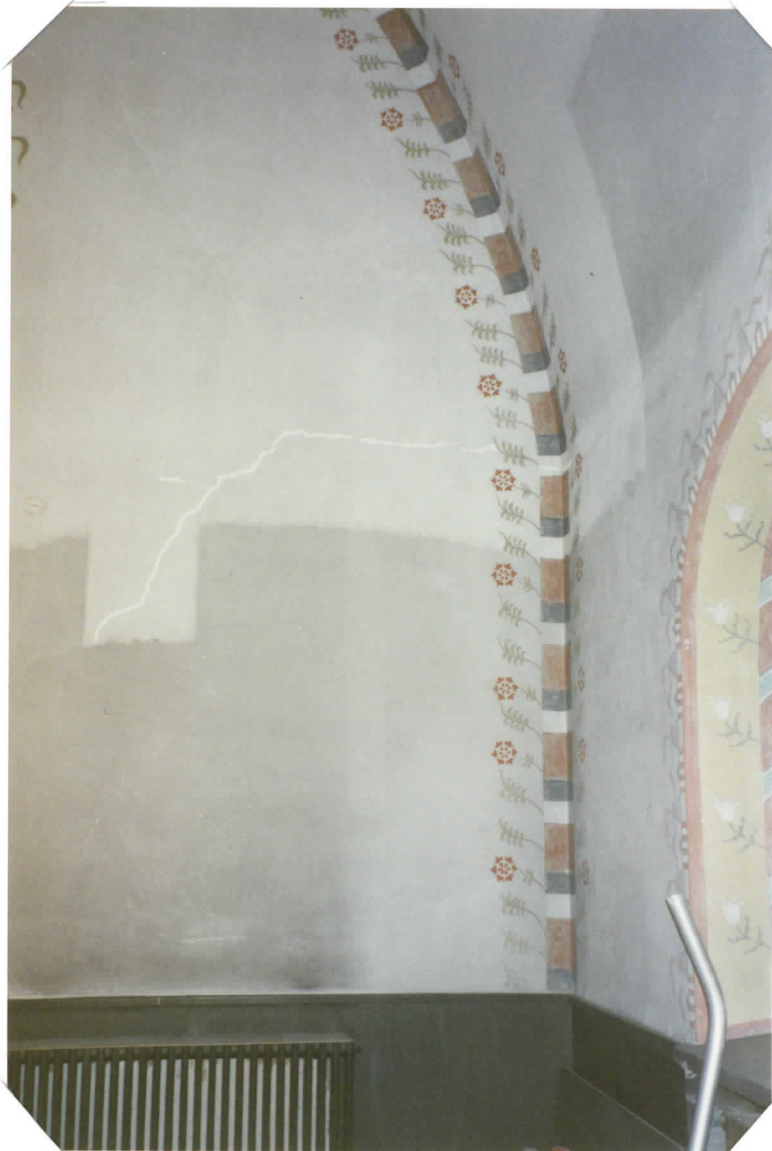
KASTEKAPELIN ET. SEINÄN PUHDISTUSTA JA HALKEAMAN PAIKKAUSTA
