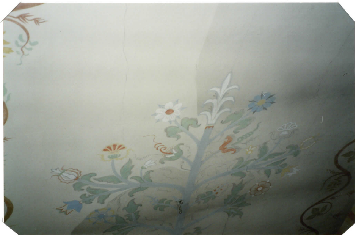
URKUPARVEN KATTOPINNAN PUHDISTUSTA
