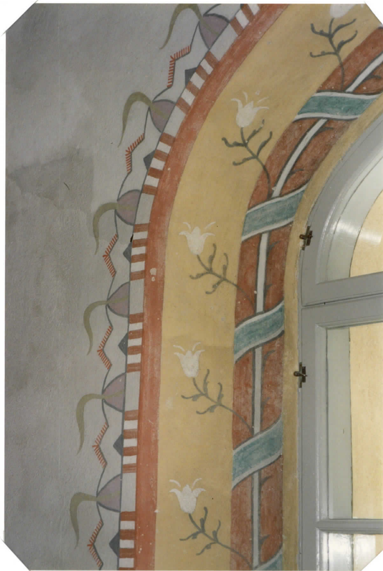
KASTEKAPPELIN LÄNSISEINÄN PUHDISTUSTA
