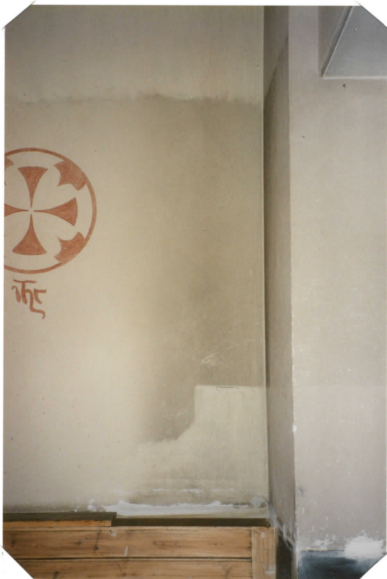
ET. SEINÄN ALAOSAN SB PUHDISTUSTA
