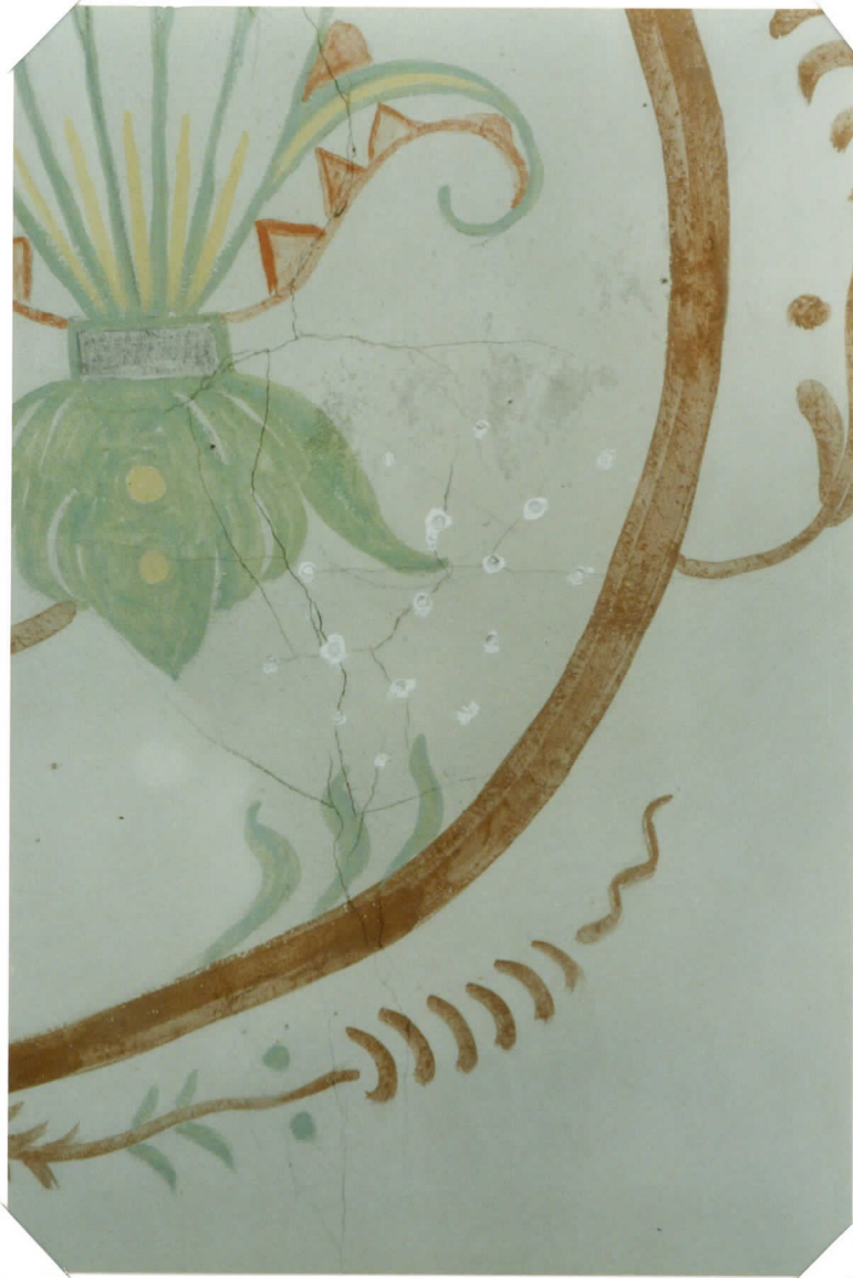
INJEKTOINTIA PÖHJ. HOLVI 3 A
