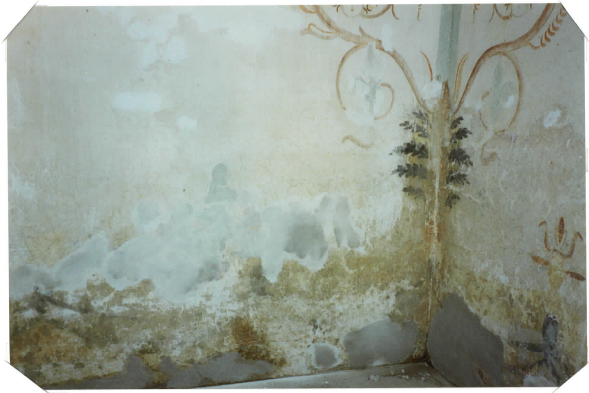
NE ALAKULMAUKSEN PAIKKAUSTA
