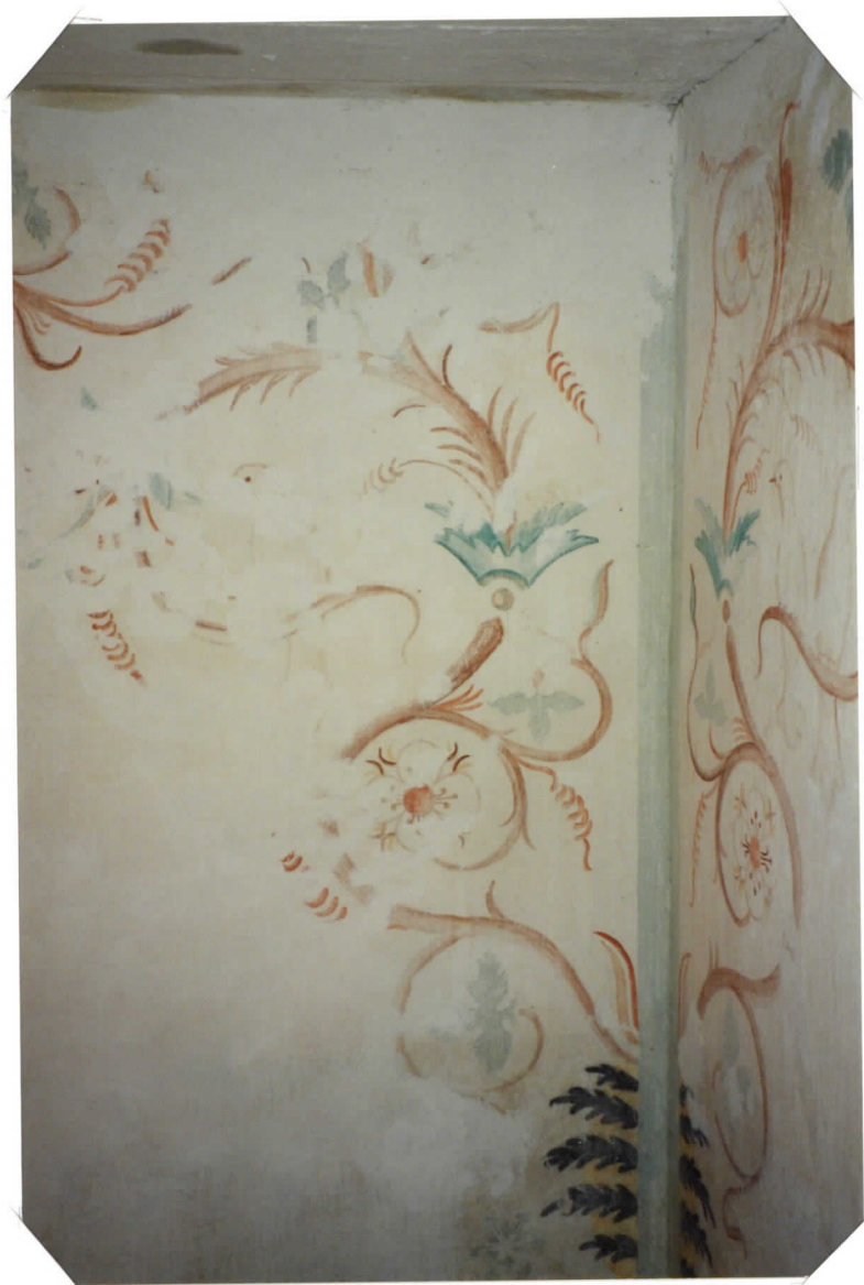
SW YLÄKULMAUS PAIKATTUNA
