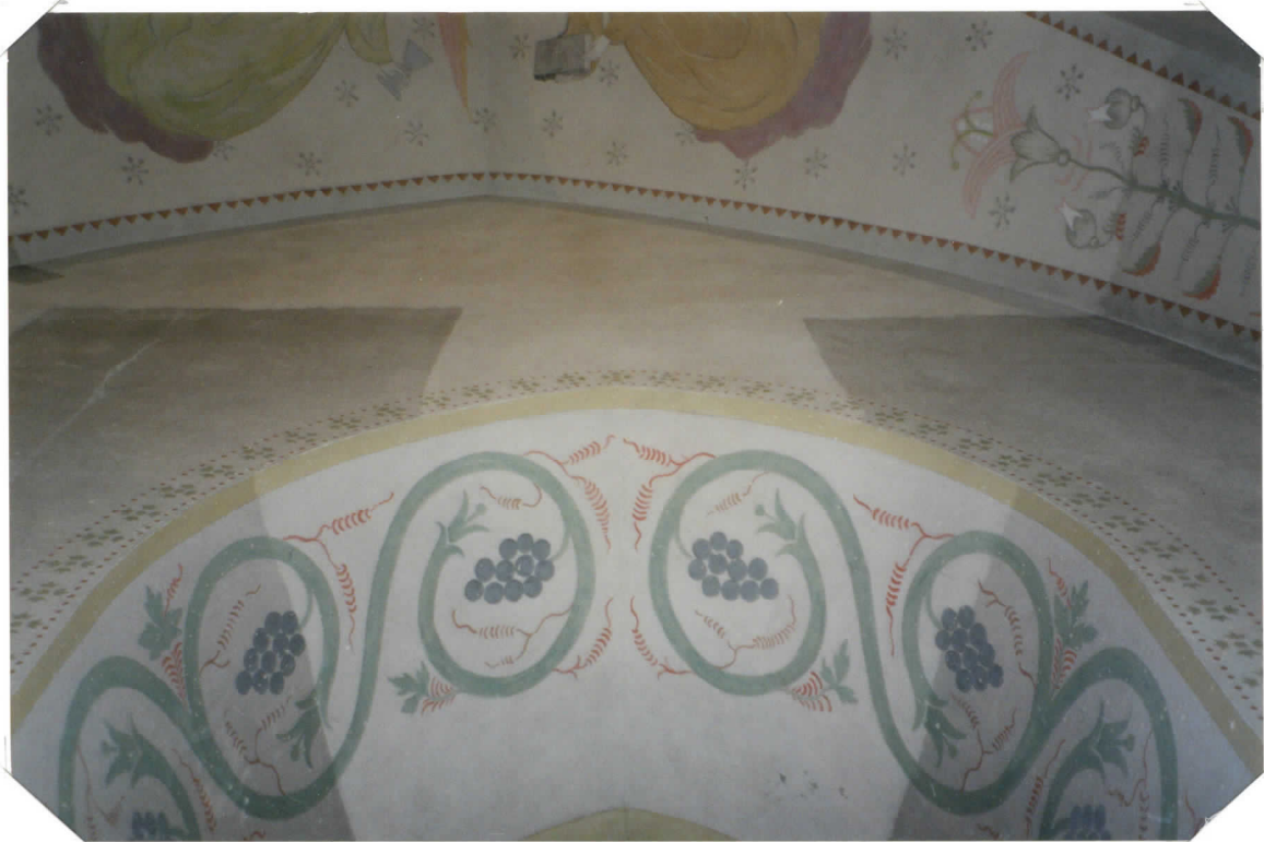
PÖHJ. KUORI-IKKUNAN YLÄOSTEN PUHDISTUSTA
