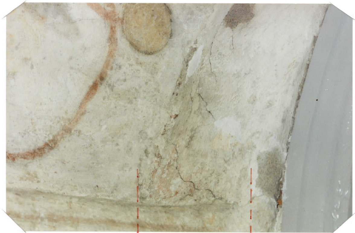
ET. PUOLEISEN KUORI-IKKUNAN PAIKKAUSTA FRAGM. VANHEMMISTA SLAMM. PINNOISTA
