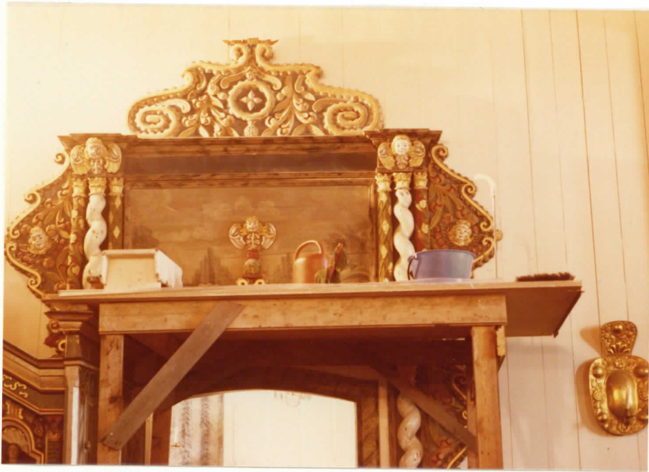
Sakastiin johtava ovi, ylimmäinen paneli osittain puhdistettu värikerroksesta.
