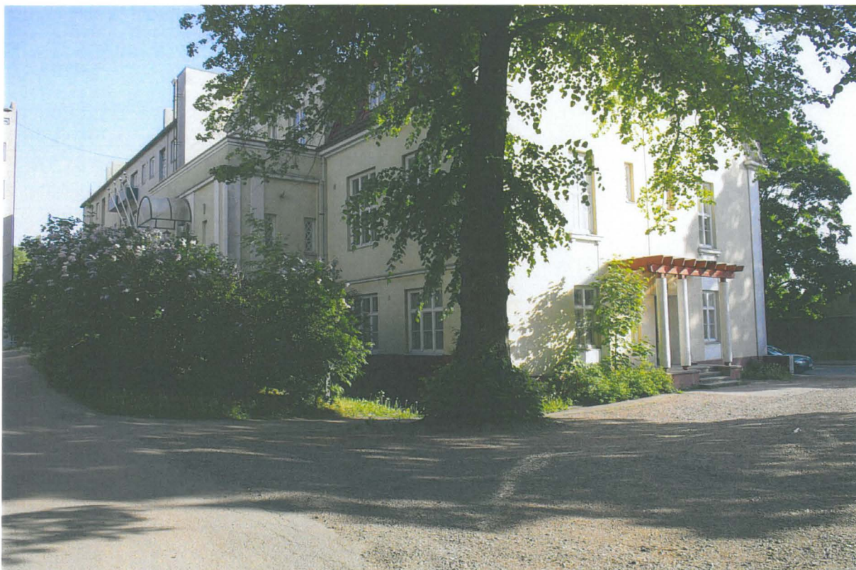
Kuva 3: Kotkan Klubin rakennus ja tontin piha-alueita ennen viemäröintiä kesäkuussa 2013. S. Kuva: KyM/M. Kykyri.
