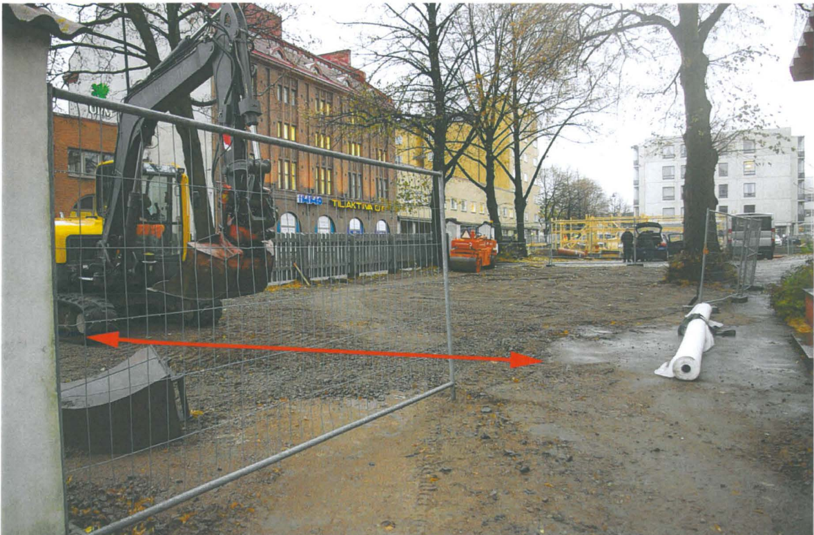
Kuva 35: Kirkkokatu 2:n piha-alue paikalla suoritetun koneellisen kuorinnan jälkeen 2.11.2012. Kuorittu ja sen jälkeen sepelillä täytetty punaruskea alue erottuu kuva-alan keskellä. Kuvan oikeassa reunassa valkoisen suodatinkangasrullan kohdalla näkyy pihan vanhaa asvaltoitua luoteisreunaa, jonne viemärioja VO6 seuraavana kesänä kaivettiin. Kuorinnan yhteydessä löytyneen mahdollisen aitarakenteen sijainti ja kulkusuunta on merkitty kuvaan punaisella nuolella. N. Kuva: KyM/M. Kykyri.
