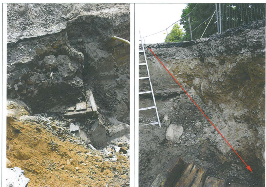
Kuvat 46–47: Hirsirakenne R6 pohjalaudoituksineen purettiin ainoastaan N-osaltaan ja loput Kirkkokadun suuntaan jatkuneesta rakenteesta jätettiin viemärikaivannon pohjalle ja peitettiin (vas.). N. Oikealla on saman kaivannon NW-seinämään merkitty punaisella nuolella raja, jota myöten vanhat kulttuurikerrokset ja rakenteet olivat tuhoutuneet aiempien kaivutöiden yhteydessä. Nuolesta oikealle myöhäistä viemärikaivannon täyttöä. Kuvan alareunassa näkyy hirsikehikon R6 pohjalaudoitusta. S. Kuvat: KyM/M. Kykyri.
