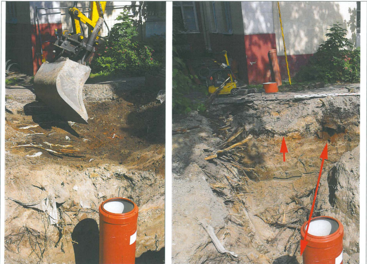
Kuvat 26–27: Kivetyin ojan (rakenne R4) N-osan pinta alkoi paljastua jo pihasepelikerroksen poiston yhteydessä (vas.). S. Oikeanpuoleiseen kuvaan on merkitty punaisilla nuolilla Ruotsinsalmen aikainen maanpinta (vas.) ja rakenne R4:n N-pään kulkusuunta (oik.). S. Kuvat: KyM/M. Kykyri.
