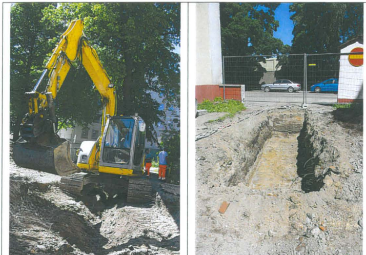
Kuvat 33-34: Viemäriöja VO6:n lounaispäättä täytetään (vas.). NE.
