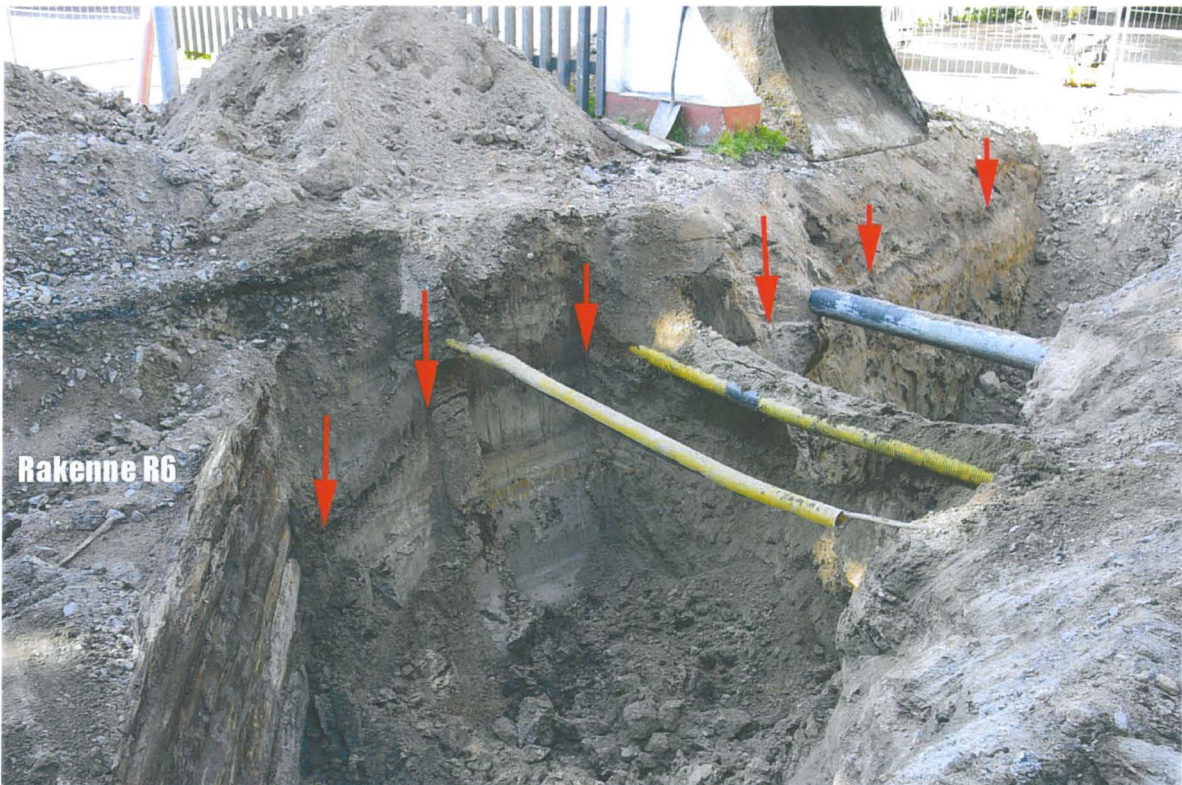
Kuva 37: Viemärioja VO6:n Ruukinkadun laajennusalueen SE-seinämää hirsikehikko R6:n W-puolella. Punaisilla nuoliilla on kuvaan merkitty jalkakäytävä- ja katualueella kaukolämpöputken ja kaapelien alapuolella sijainnut Ruotsinsalmen aikainen maanpinta. Horisontti oli säilynyt alueella koskemattomana Ruukinkadun alta paljastuneen hirsiseinän edustalle asti, missä se oli mennyt poikki ja laski voimakkaasti kehikon suuntaan. Kuvassa tämän tummanruskean kerroksen päällä hirsiseinän edustalla erottuu paksu siniharmaa eristesavikerros. N. Kuva: KyM/M. Kykyri.
