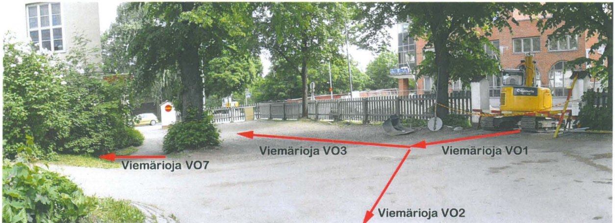
Kuva 7: Kirkkokatu 2:n tontti ennen viemäröintiä. Kuvaan on merkitty kaivettujen viemäriojien sijainti tontilla. SW. Kuva: KyM/M. Kykyri.
