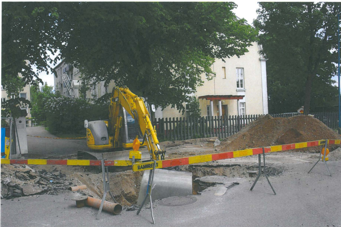
Kuva 4: Viemäröintityöt aloitettiin Kirkkokadulta, mistä edettiin Kirkkokatu 2 piha-alueen kautta kuvassa takana oikealla sijaitsevalle Ruukinkadulle. S. Kuva: M. Kykyri/KyM.
