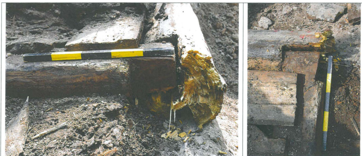
Kuvat 44–45: Vasemmalla poikkileikkaus hirsikehikko R6:n pohjalaudoituksesta R6a. Kuvassa näkyy lattianiska ja sen päällä sijainneita lautoja sekä hirsikehikon alin hirsikerta, johon niskahirsi on salvottu. N. Oikealla sama rakenne ylhäältäpäin kuvattuna. E. Kuvat: KyM/M. Kykyri.
