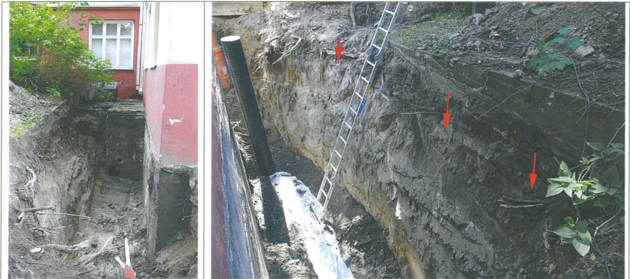
Kuvat 49-50: Vasemmalla viemärioja VO7 pohjaan kaivettuna. SE. Oikealla ojan SW-seinämää, johon on merkitty punaisilla nuolilla Ruotsinsalmen aikaisen maanpinnan sijainti. N. Kuvat: KyM/M. Kykyri.
