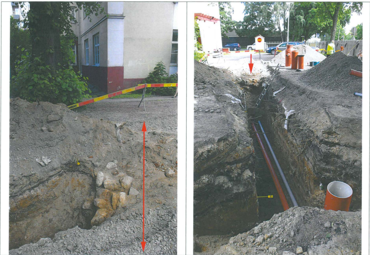
Kuvat 19–20: Vasemmalla rakenne R4 esiin kaivettuna. Rakenteeltaan ja kooltaan vastaava kivillä täytetty kaivanto (rakenne R3) sijaitsi vajaan kolmen metrin päässä etelämpänä samassa ojassa. S. Oikealla viemäriöija VO4 pohjaan kaivettuna. Rakenne R4:n sijainti on merkitty kuvaan punaisella nuolella. SW. Kuvat: KyM/M. Kykyri.
