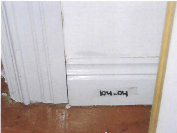
Kuva 17. Huoneen H104 eteläseinän oviaukon länsipuolen ovilista ja jalkalista.
