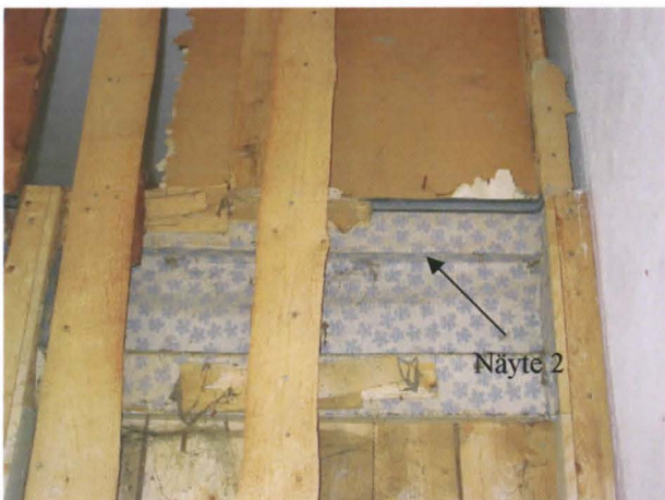
Kuva 11. Tapettinäyte 2 väliseinän sisältä.
