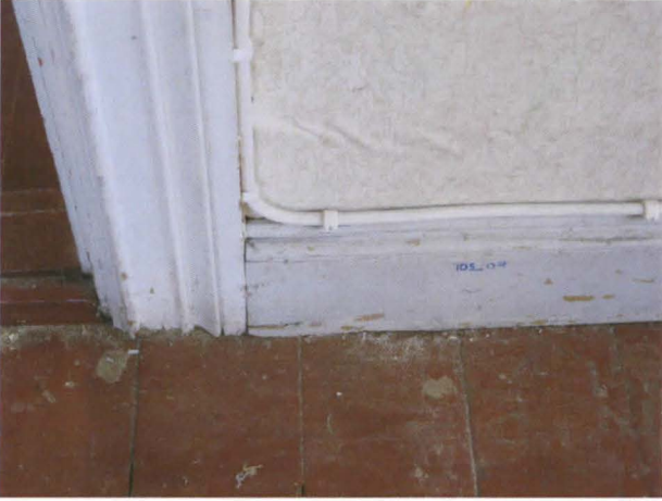
Kuva 30. Huoneen 105 eteläseinän oviaukon länsipuolen jalkalista.
