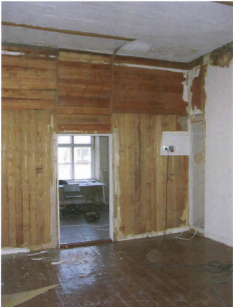
Kuva 26. Huoneen H104 pohjoisseinän raakalaudat.
