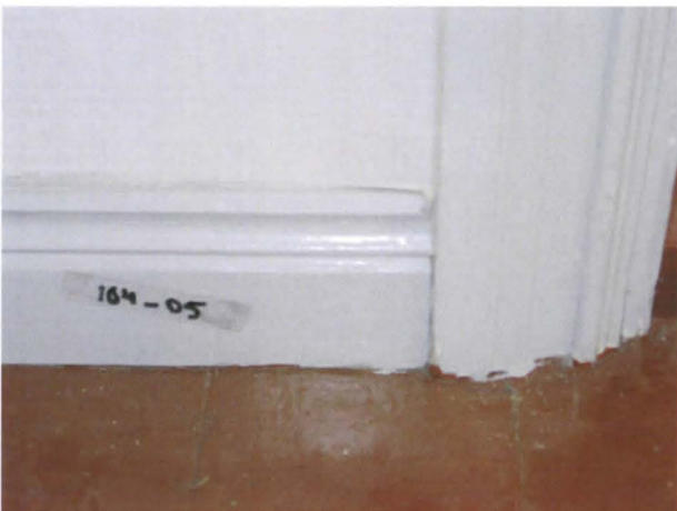
Kuva 18. Huoneen H104 eteläseinän oviaukon itäpuolen ovilista ja jalkalista.
