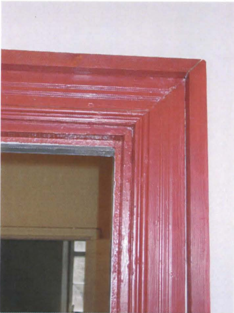
Kuva 3. Huoneen H103 pohjoisseinän oviaukon oikea pieli ja yläpieli.
