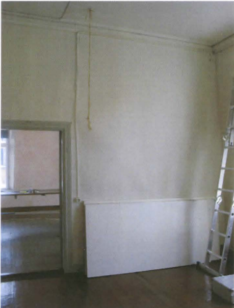
Kuva 13. Huoneen H104 eteläseinän länsipuoli ja oviaukko huoneeseen H103.
