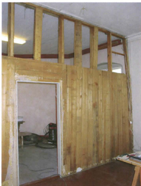
Kuva 24. Huoneen H104 eteläseinän raakalaudat.
