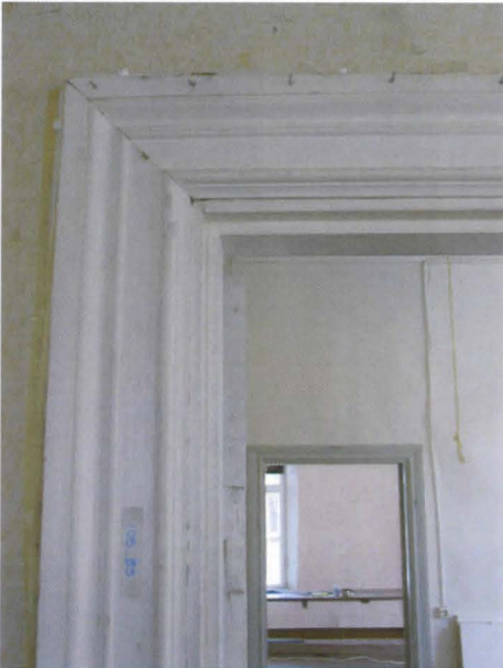
Kuva 28. Huoneen H105 eteläisen oviaukon itä- ja yläpieli.
