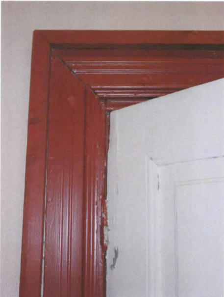
Kuva 4. Huoneen H103 pohjoisseinän oviaukon vasen pieli ja yläpieli.
