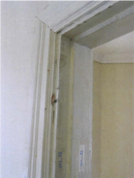
Kuva 21. Huoneen H104 pohjoisseinän oviaukon länsipuoleinen ovilista ja ylälista.
