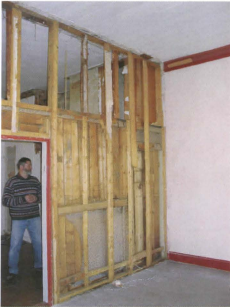
Kuva 9. H103 pohjoisseinä kipsilevyjen poiston jälkeen.
