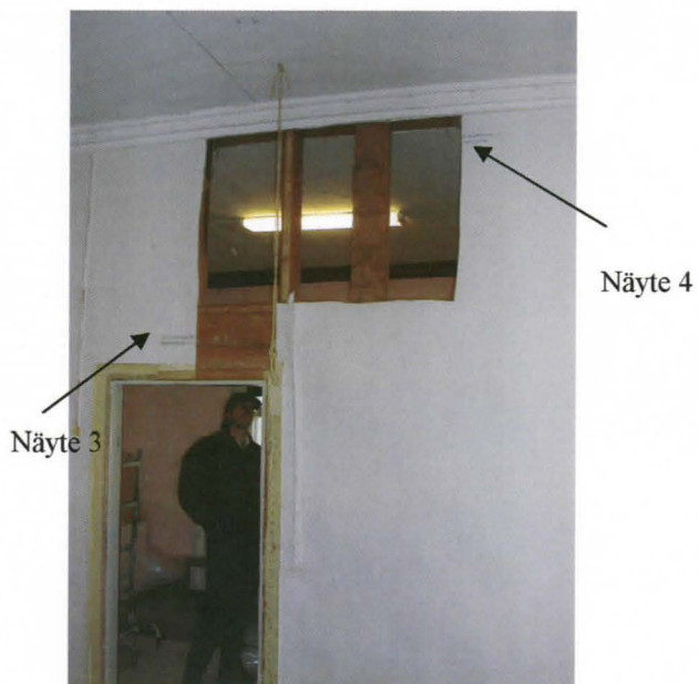
Kuva 23. Huoneen H104 eteläseinän tapettinäytteet: 3 ja 4.
