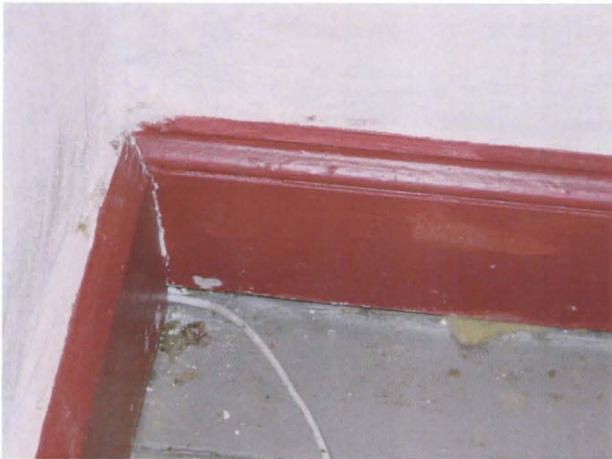
Kuva 6. Huoneen H103 koillisnurkan lattialistat.
