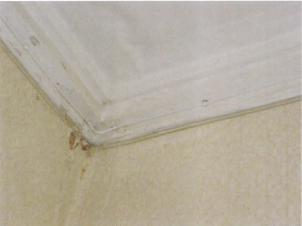
Kuva 32. Huoneen 105 eteläseinän kattolista.
