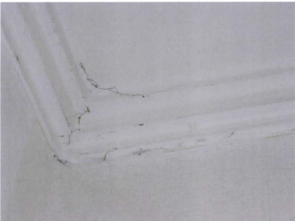
Kuva 19. Huoneen H104 lounaisnurkan kattolistat.
