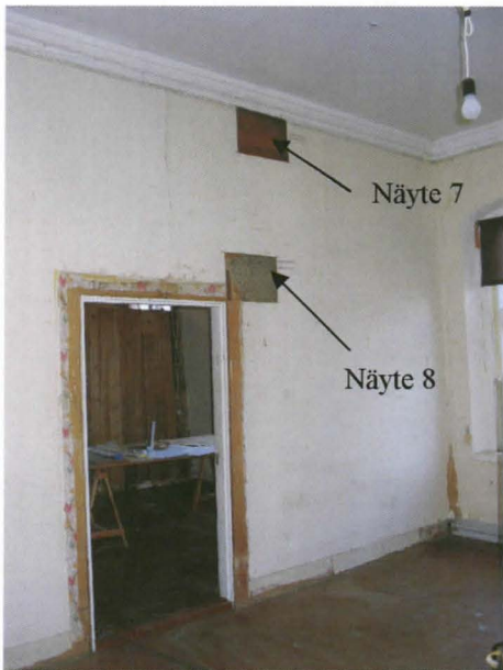
Kuva 33. Huoneen H105 eteläseinän tapettinäytteet 7 ja 8.
