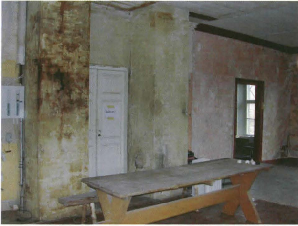
Kuva 36. Kavaljeerisiiven länsiosa. Näkymä koilliseen.
