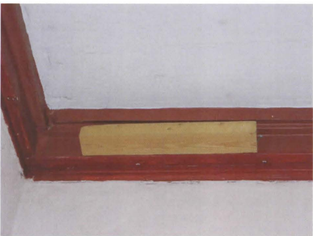
Kuva 7. Huoneen H103 kattolista.
