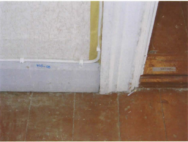
Kuva 31. Huoneen 105 eteläseinän oviaukon itäpuolen jalkalista.
