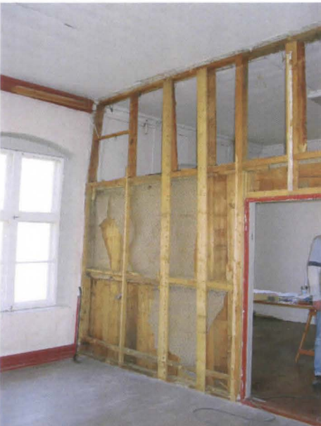
Kuva 8. H103 pohjoisseinä kipsilevyjen poiston jälkeen.
