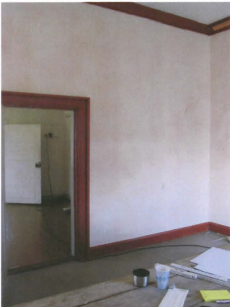
Kuva 2. Huoneen H103 pohjoisseinän itäpuoli ja oviaukko huoneeseen H104.
