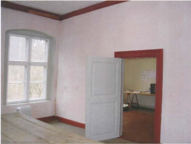
Kuva 1. Huoneen H103 pohjoisseinän länsipuoli ja oviaukko huoneeseen H104.
