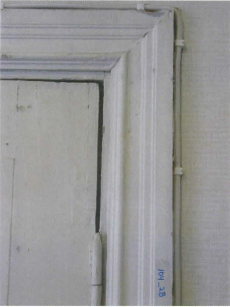
Kuva 20. Huoneen H104 pohjoisseinän oviaukon itäpuoleinen ovilista ja ylälista.
