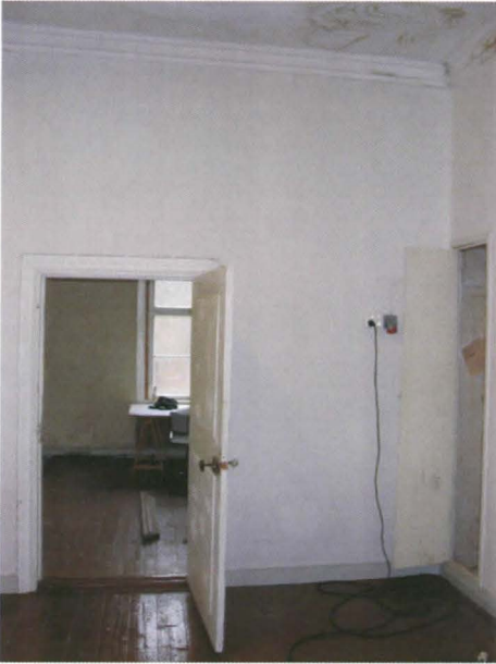
Kuva 14. Huoneen H104 pohjoisseinän itäpuoli ja oviaukko huoneeseen H105. Itäseinällä komero 104_b.
