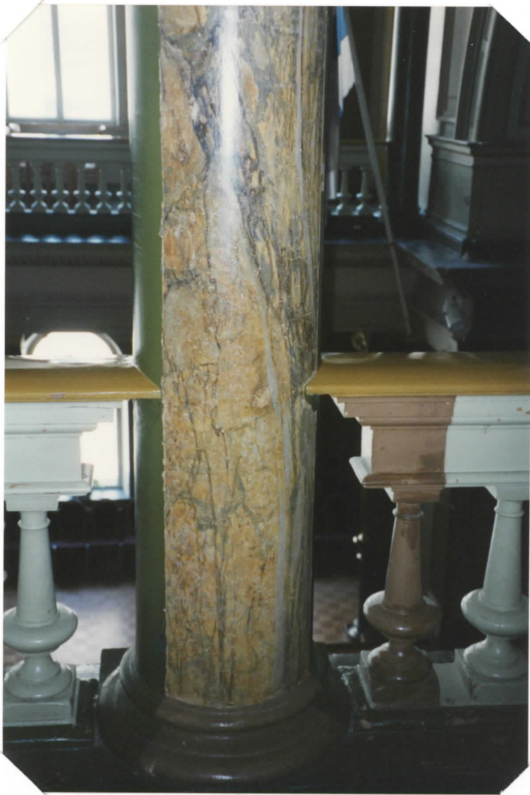
PARVEN PYLVÄÄN ALKUPERÄIS- TÄ PINTAA
