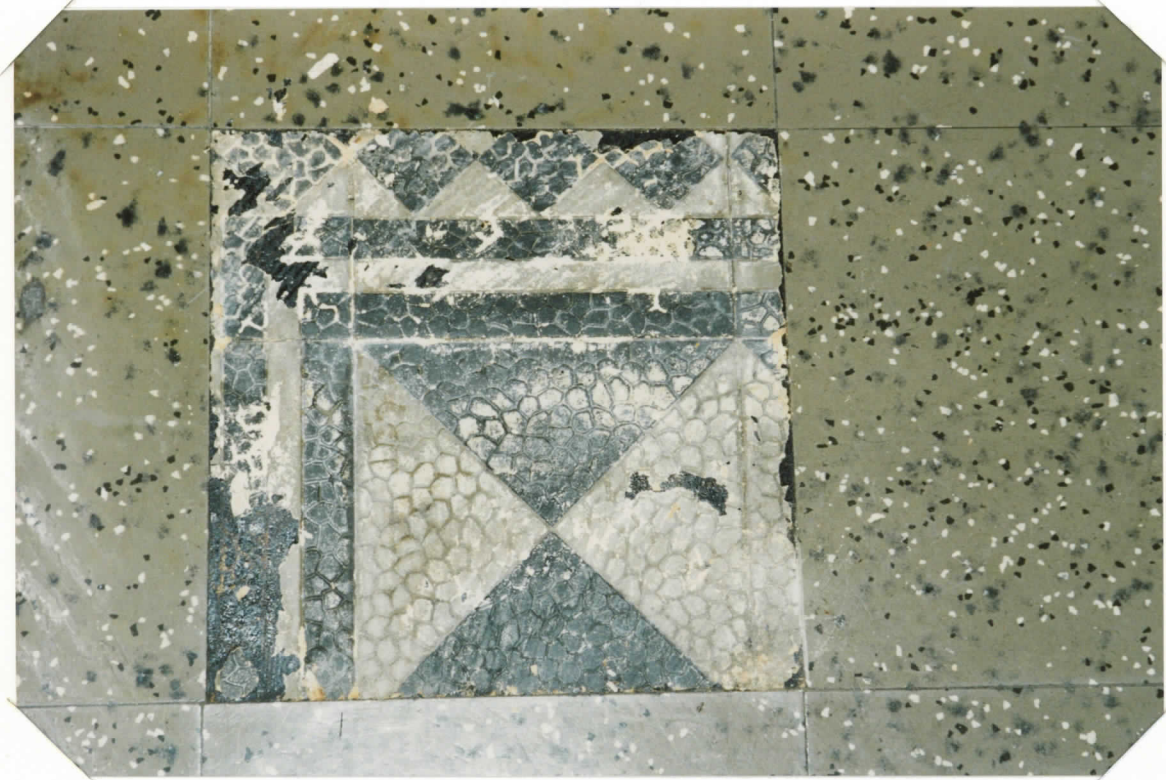
ALKUPERÄISTÄ LATTIAA PORRASTASANTEELLA
