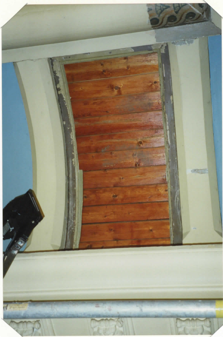
PORRASHUONEEN KATTOA, SUOJAKÄSITELTY PUUPANEELI
