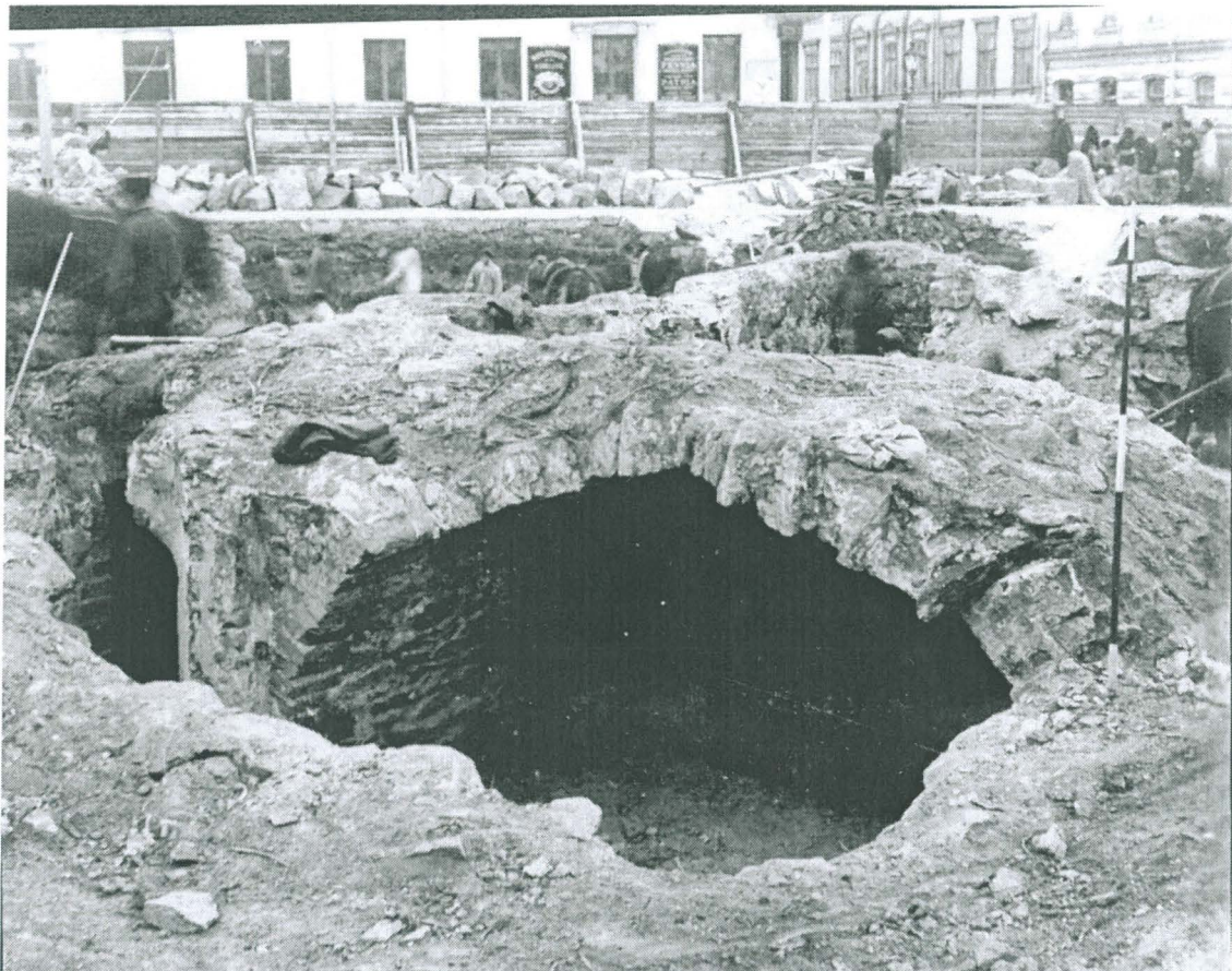
Kuvio 6. Huone N4 kaakosta. Huom. mittalanka, jonka avulla Nyström piirsi leikkauksen G-H.
