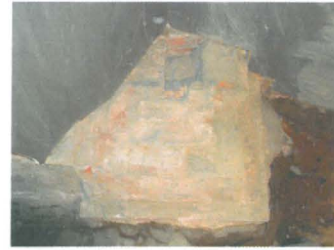
3. Tiilirakenne kaivausalueen l...
