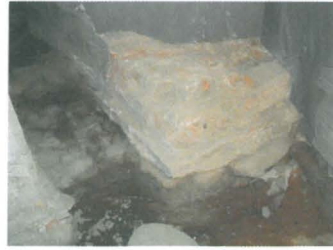
2. Tiilirakenne kaivausalueen l...
