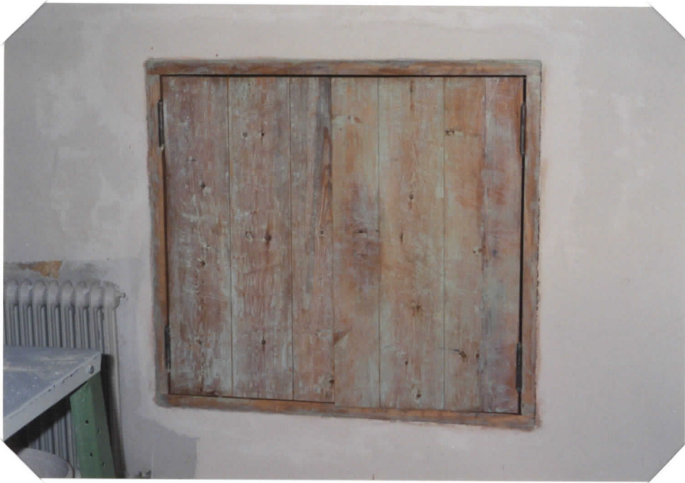
sakariston komero länsiseinällä, uudet reunapuut ja sisäosa patinoitu
