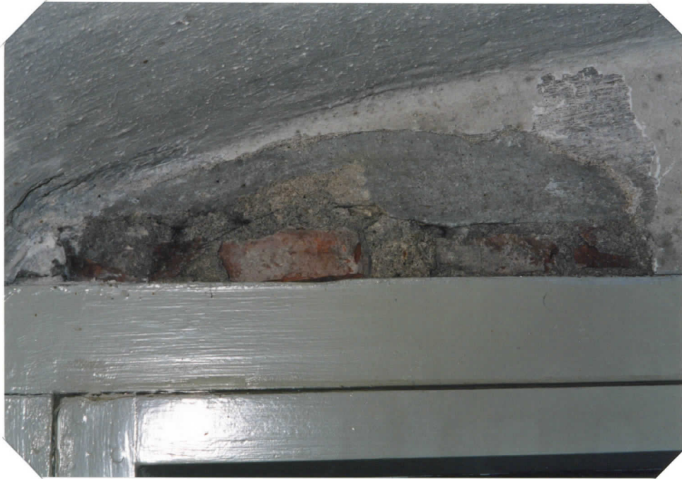
pohjois-seinän ikkunan yläosa urkupar- vella. Kuvassa näkyvillä kaksi vanhaa vätikerrosta, harmaa ja vihertävä
