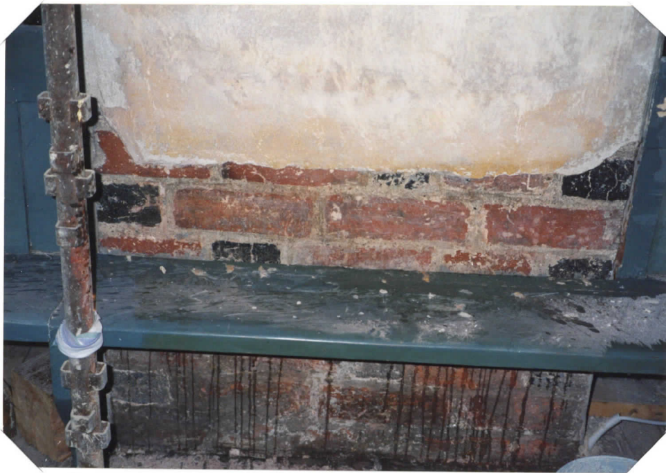
alkuperäistä tiilipilaria, osa tiilistä lasitettu
