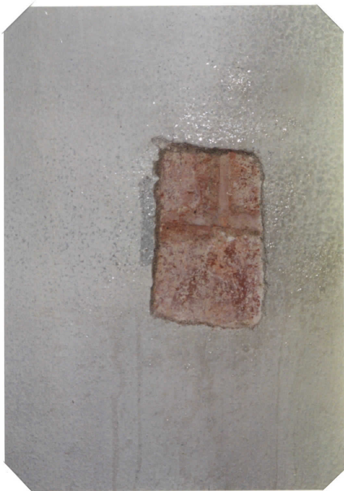
kiiltävää liima- ainetta, esiin otettu tiili- pintaa, jossa kalk- kiväri.
