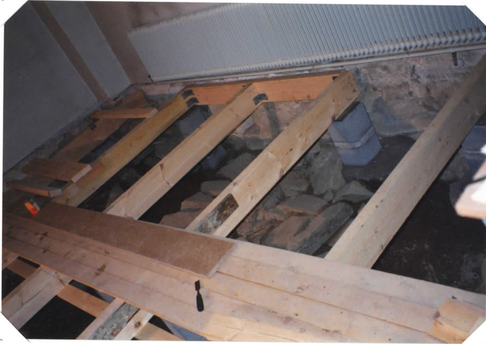
sakastin uuden lattian rakenteita
