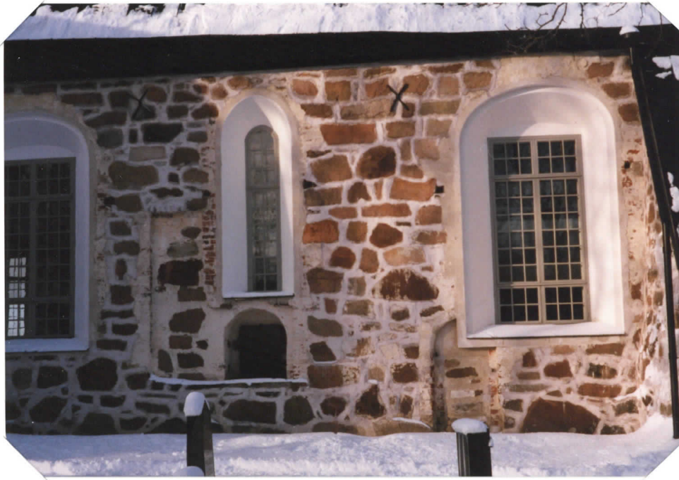
kirjon eteläseinää ; keski-ikkuna vanhin, oikealla olevan ikkunan alla pappien ovi, joka laitettiin umpeen v. 1905, jolloin ikkunoita madallettiin
