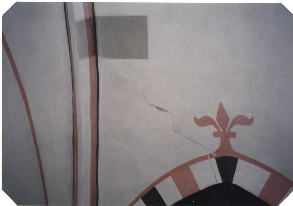
etelä-holviin jätetty pieni puhdistamaton alue
