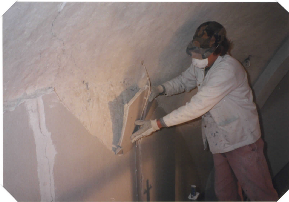
laastikerrokset irtosivat osin helposti
