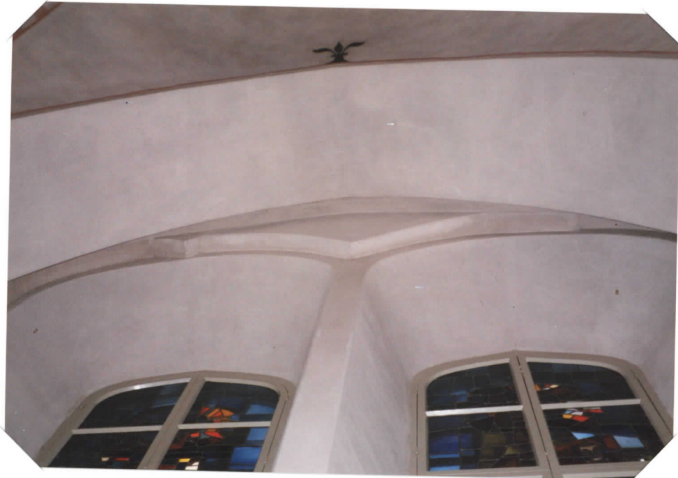
vasemmalla ikkunan yläpuolella pykälä, josta tiedetään ikkunan olleen kolmi- osaisen
