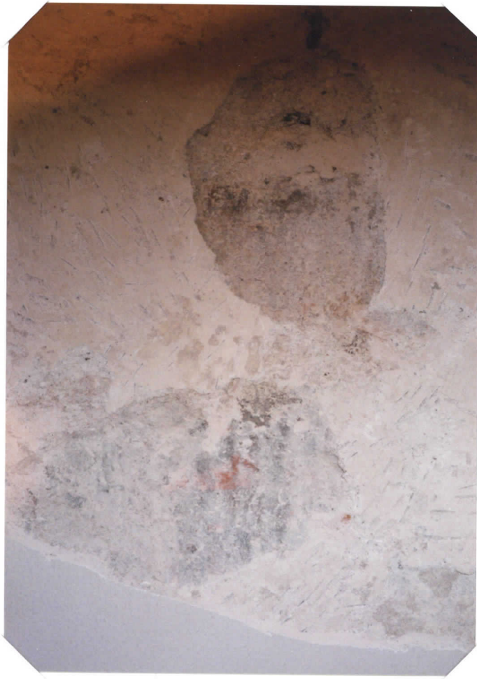
osa punamultakuviota poh- jois-seinällä alimmassa kalk- kivärikerroksessa
