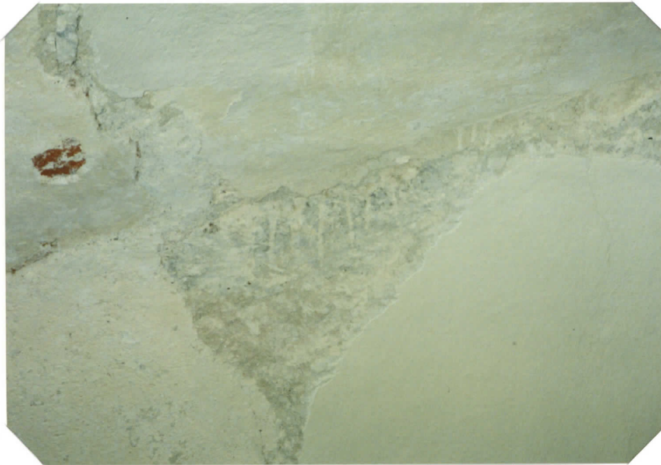
paksu kerros oikaisu- laastia länsi-seinällä
