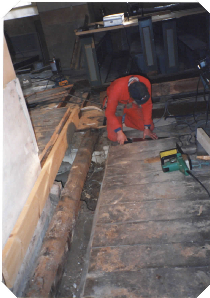
lattiasta poistettu lahonneet lautojen osat, hirsí sakastin vanhasta lattiasta
