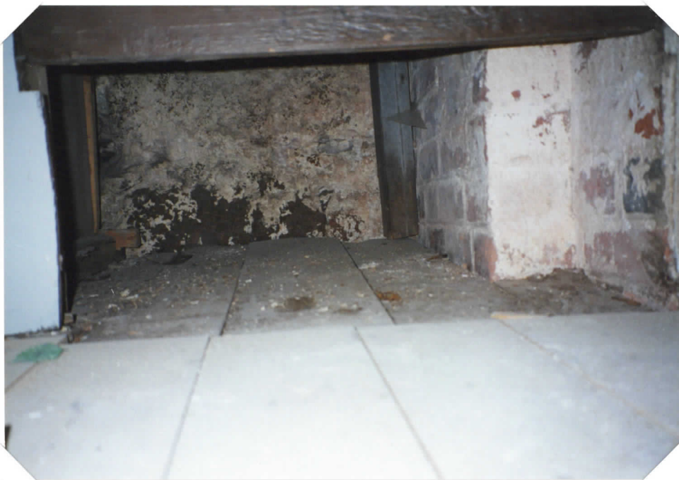
poistetun askelman takaa näkyy vaaleaa seinäväriä, pohjoislehtereiden puolella siniharmaata
