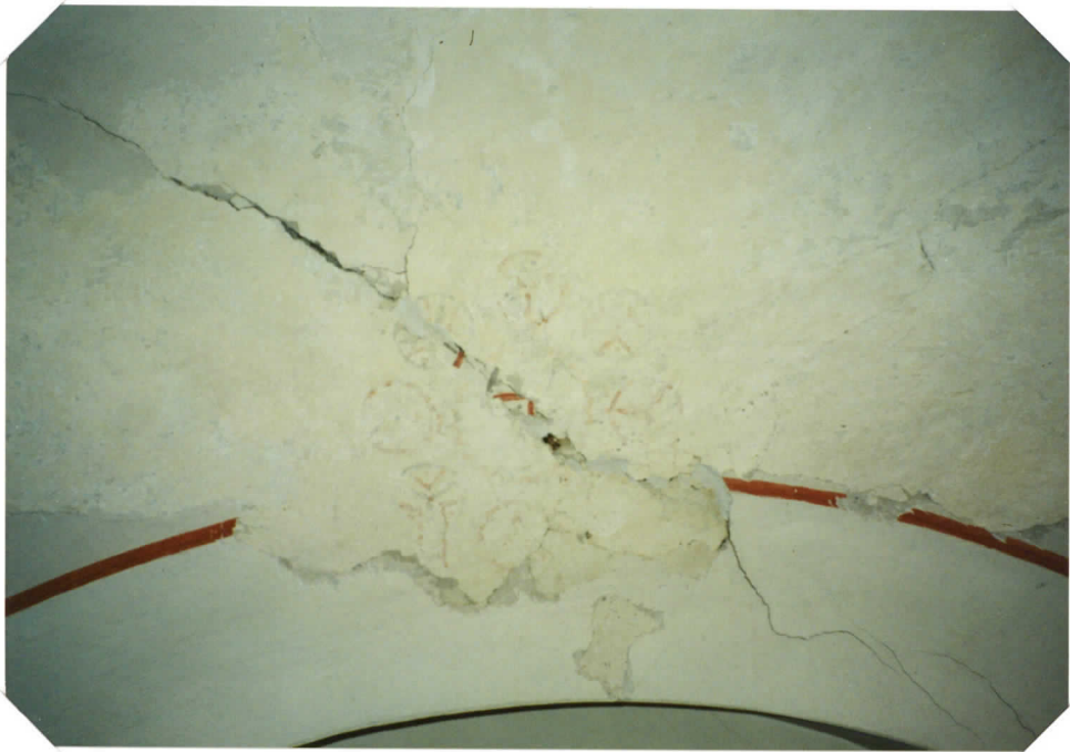
pohjoisseinän esille otettu kuvio
