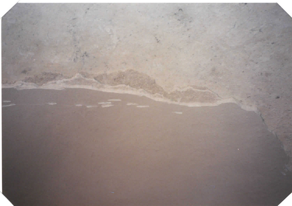
seinissä ainakin kaksi oikaisu- laastikerrosta (samanaik.)
