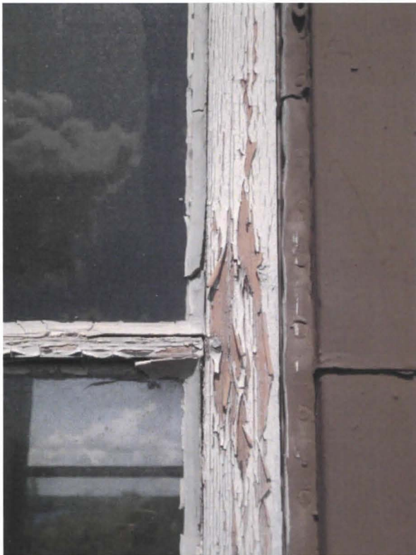
KUVA 19. Kattolyhdyn ikkunaa ja seinäpintaa
