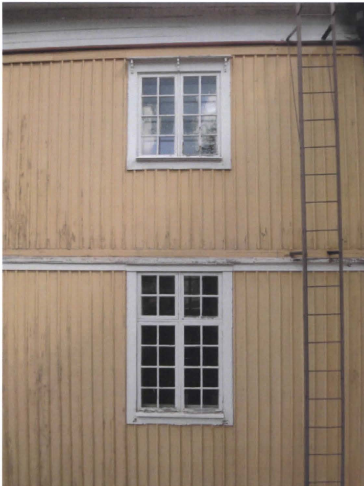
KUVA 17. Läntisen julkisivun ikkunoita ja kerroslista
