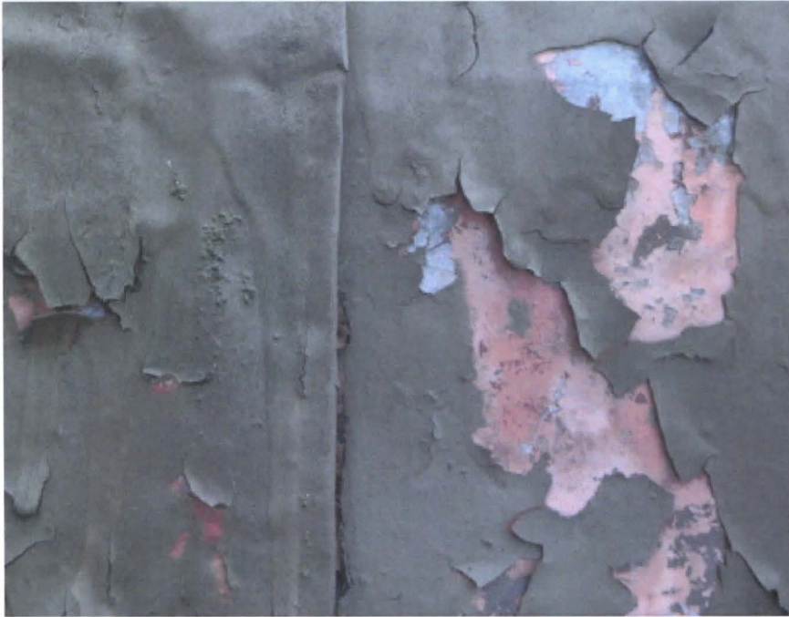
KUVA 7. Katon hilseilevää maalipintaa.
