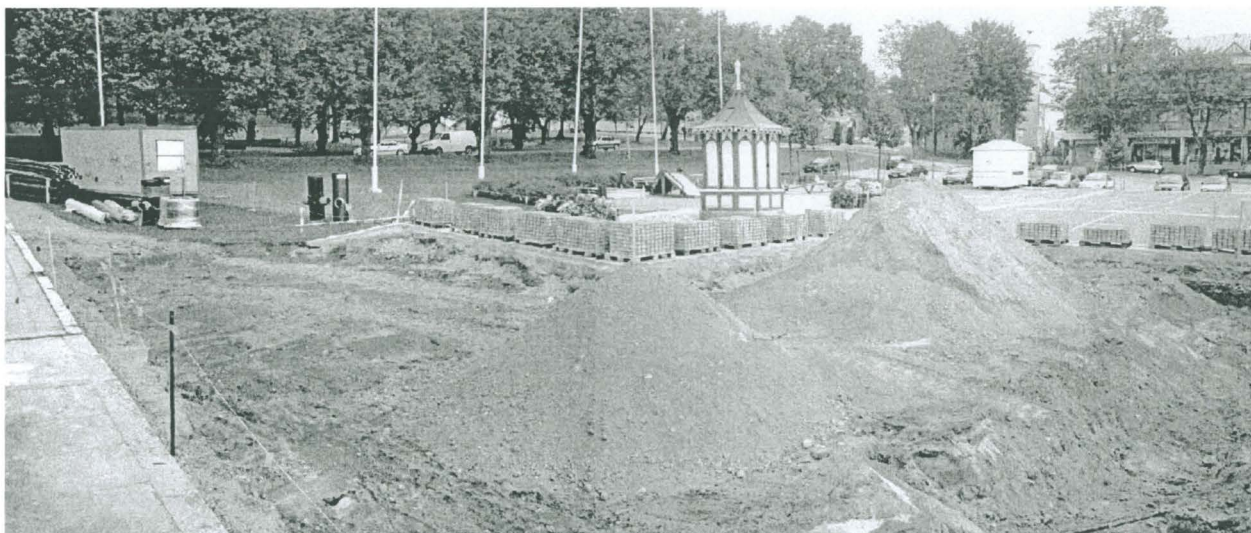
124699: 3-4. Panoraama. Yleiskuva kauppatorin pohjustus- ja uudelleen kiveämistöistä. Torialueen hyvin ohut kulttuurikerros on tuhoutunut paikoitellen. Kuvan oikeassa laidassa näkyy luonnollisiin kerrostumiin asti kaivettu viemärikaivanto. Kuvan vasemmassa laidassa tumman siimapylvään takana näkyy heikosti miltei pohjois-etelä -suuntaisia huonokuntoisia puujäänteitä. Kuvan keskellä sijaitsevan kaivon vasemmalla puolella äärimmäisenä olevan päällystetiilikasan edessä kaivannossa oli havaittavissa epämääräistä kiveystä, mahdollisesti uuninpohja (?). Kuva on otettu linja-autoaseman itäseinustalta.
