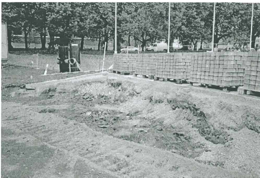
124699: 1. Kauppatorin länsiosan pohjustus- ja kiveystyöt. Kauppatorin linja-autoaseman itäpuolella pohjustustöiden yhteydessä kaivutyöt on tehty osittain kulttuurikerrosten läpi. Kuvassa keskellä kaivannossa näkyy kiviä, jotka kuuluvat todennäköisesti välillä 1753-1855 rakennetun rakennuksen uuninperustaan. Kulttuurikerros on hyvin ohut ja paikoin tuhottu. Taustalla näkyy kirkko ja Kirkkopuisto.
