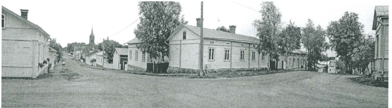
124699: 14-16. Panoraama. Yleiskuva Vuorikadun ja Mäyhälänkadun risteyksestä. Kirkko häämöttää kuvassa vasemmalla taustalla.
