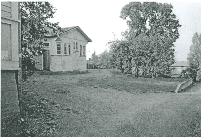
124699:49. Tontin 2-7-2 eteläosa on ollut rakennettua aluetta vuoden 1721 kartan perusteella Ison vihan päättyessä. Sisäpihan kerrostumat ovat oletettavasti säilyneitä. Sisäpiha kuvattuna Ylisenkadun puolelta.
