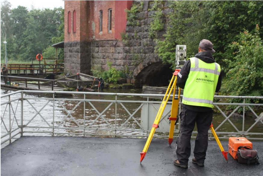
Kuva 4. AKMA201405:6. Hirsiarkkujen kulmat mitattiin takymetrillä. Takymetriä käyttää Petro Pesonen. Kuva Lajja Simponen.
