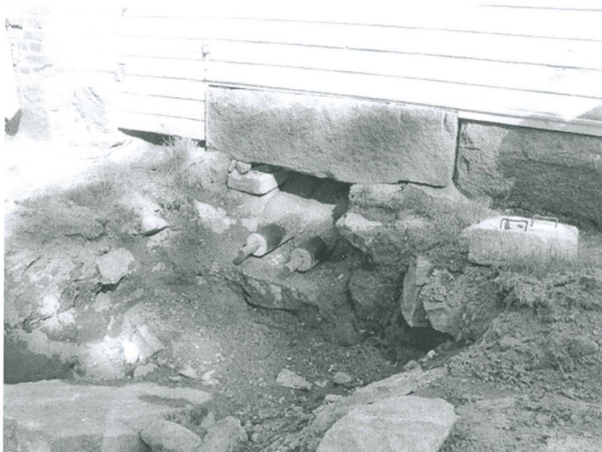
130_3027 Kaukolämpöputkien lävistys perustuksessa.
