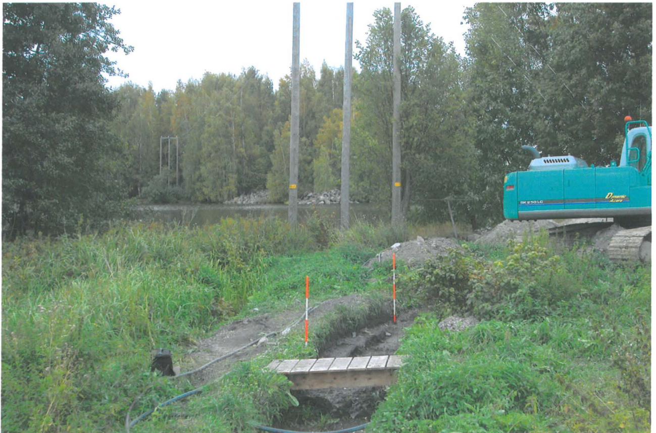
Kaivausalue: yleiskuva. Linjakepit ovat pisteissä 300/500 ja 306/500. Taustalla Hiukkasaari. SSE
