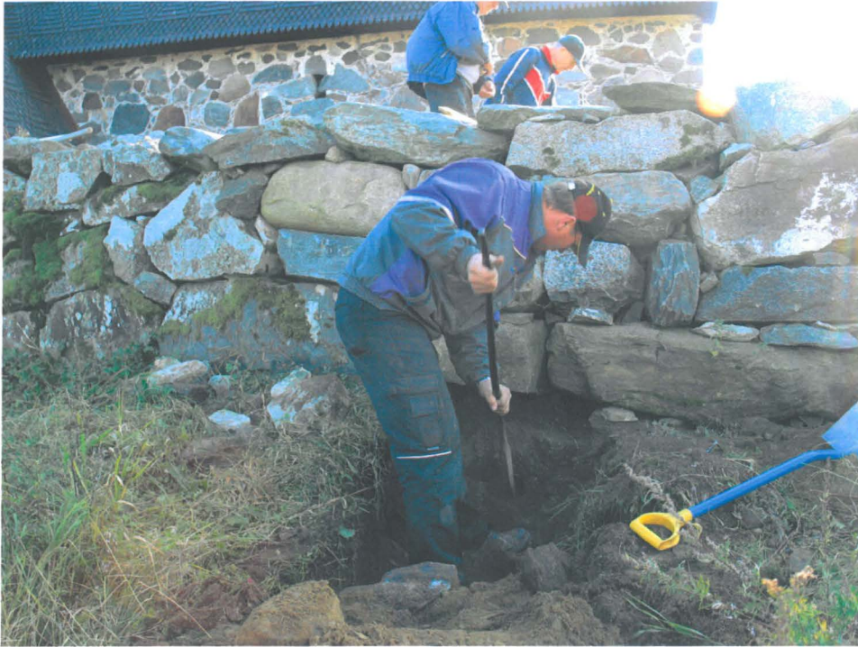
5) Salaojapukelle kaivettiin reikä kiviaidan alitse
