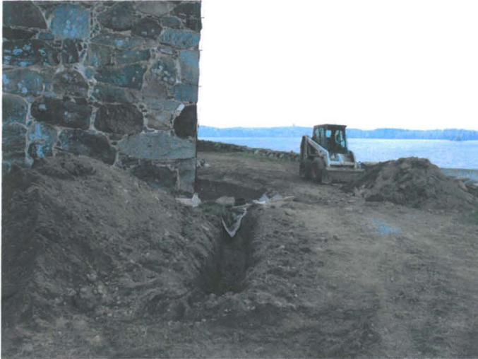
1) Alkutilanne. Ojaa oli jo kaivettu n. 2 m.
