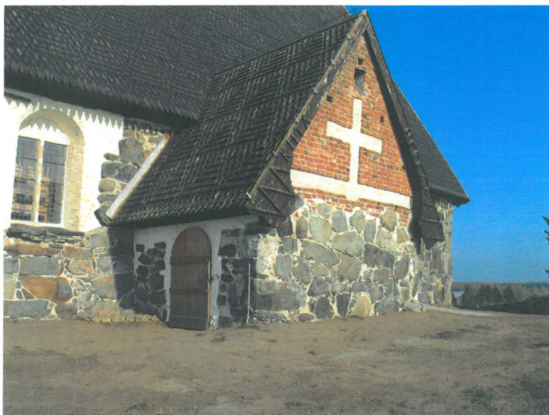
Kirkkoa ympäröivä kaivanto oli valvojan saapuessa paikalle jo täytetty umpeen.
