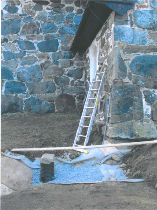
1. Sakariston koillisnurkan salaojakaivo
