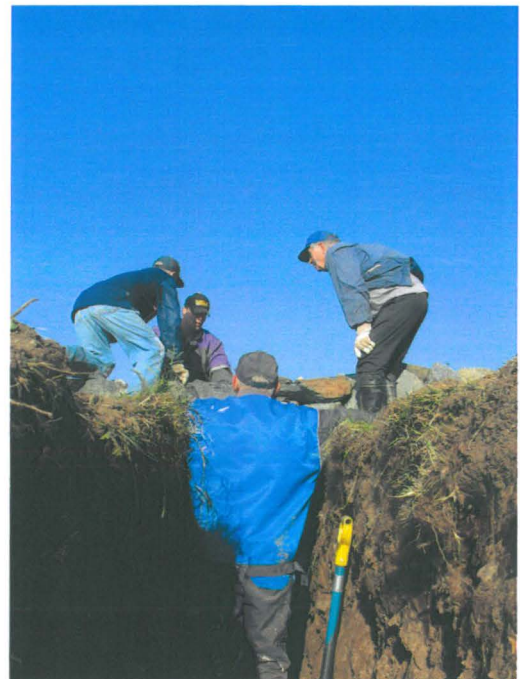
4) Ojaa kaivettiin 130 cm syvyyteen asti
