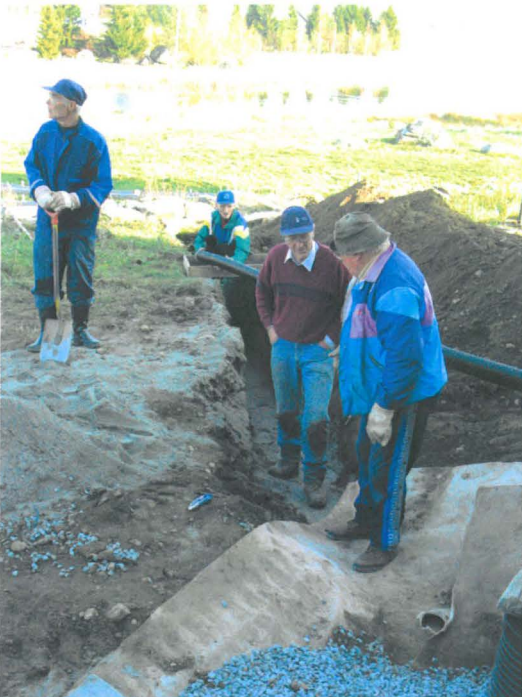
6) Putki asetetaan paikoilleen
