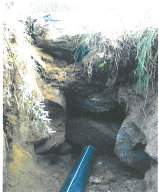
5. Putki menossa kiviaidan läpi
