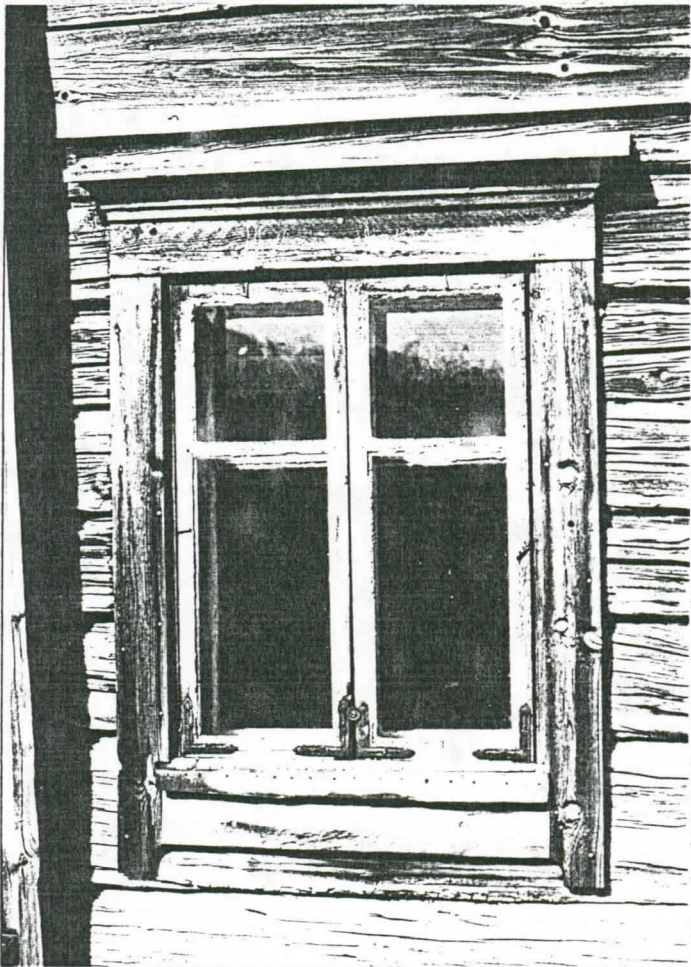
5. ENT. PESUHUONEEN IKKUNA LOUNAISEEN
