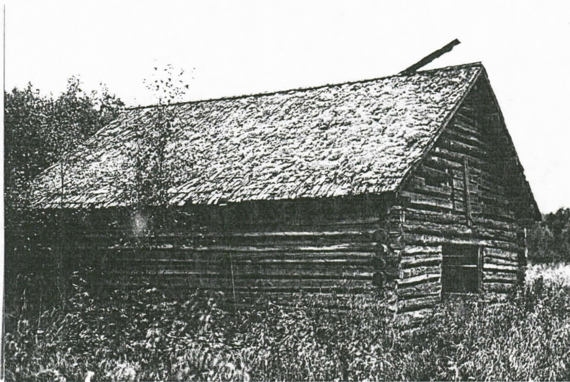
21. LATO IV POHJOISESTA
