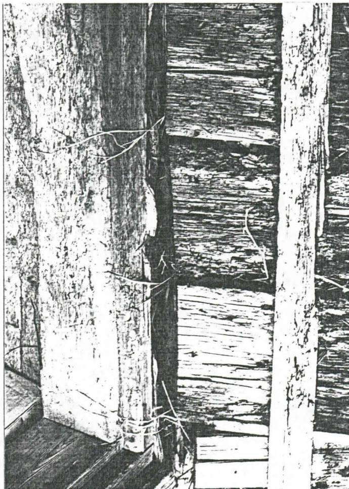
TALLIN ETEISEN OVEN KYNNYS JA MAATUNUTTA PORRASTA
