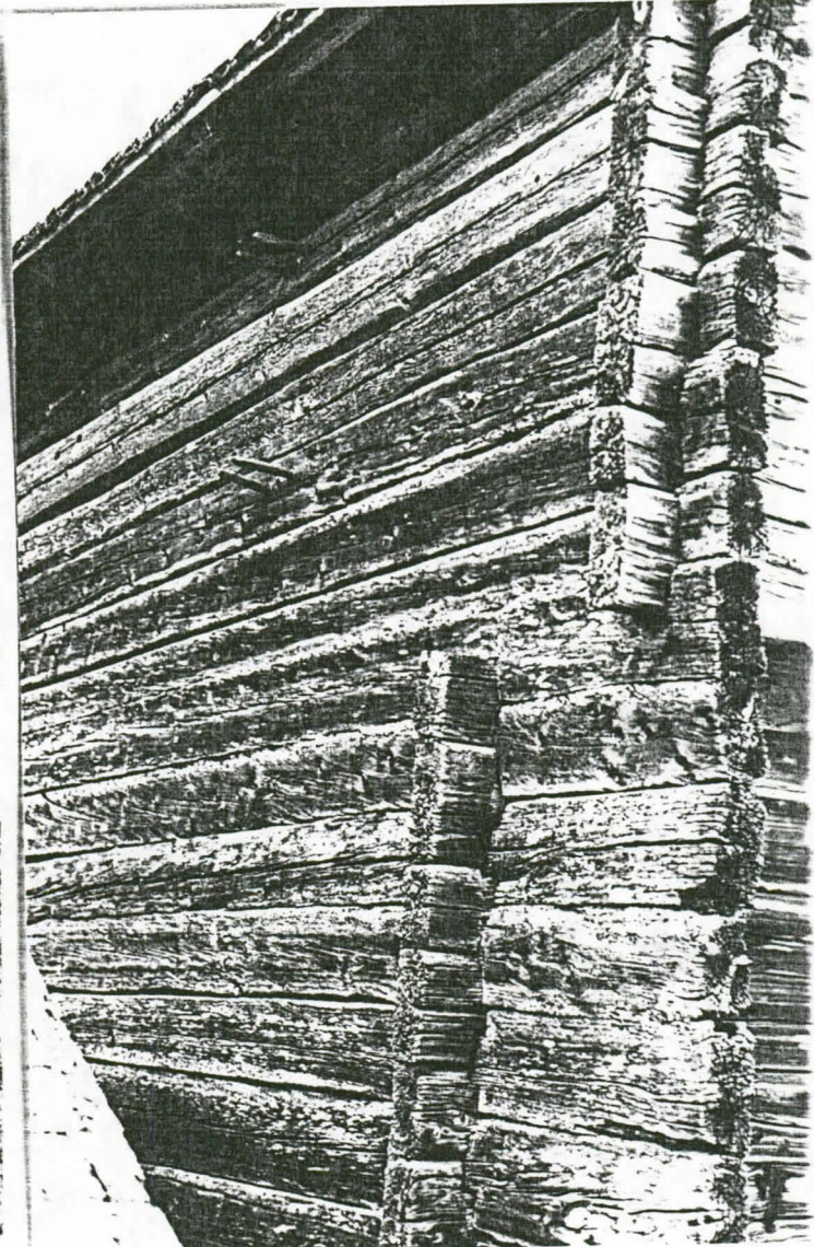
16. LÄNSINURKAN JA LUOTEIS- SEINÄN YLÄOSAA
