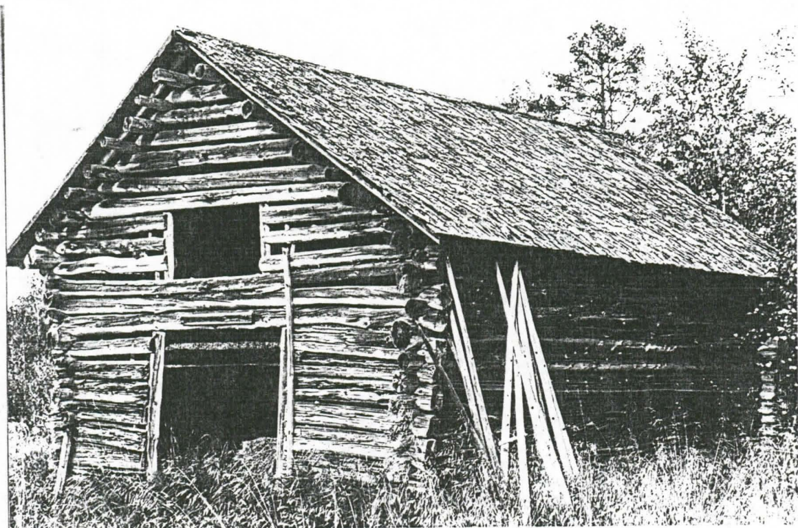
2. LATO I ETELÄSTÄ
