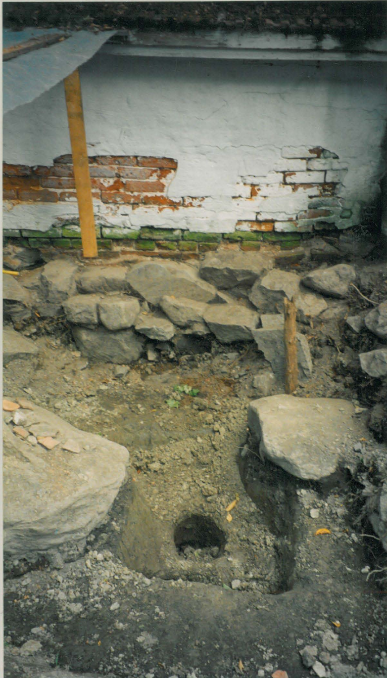
Alue 9601. Portaiton eteläseinä. Perusrakente S. RHO neg 119396
