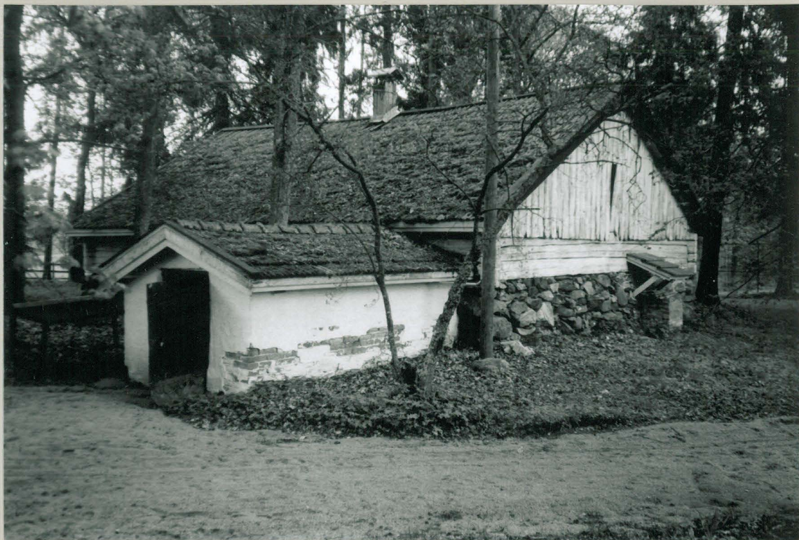
Laukon kellarirakennus. yk SW
