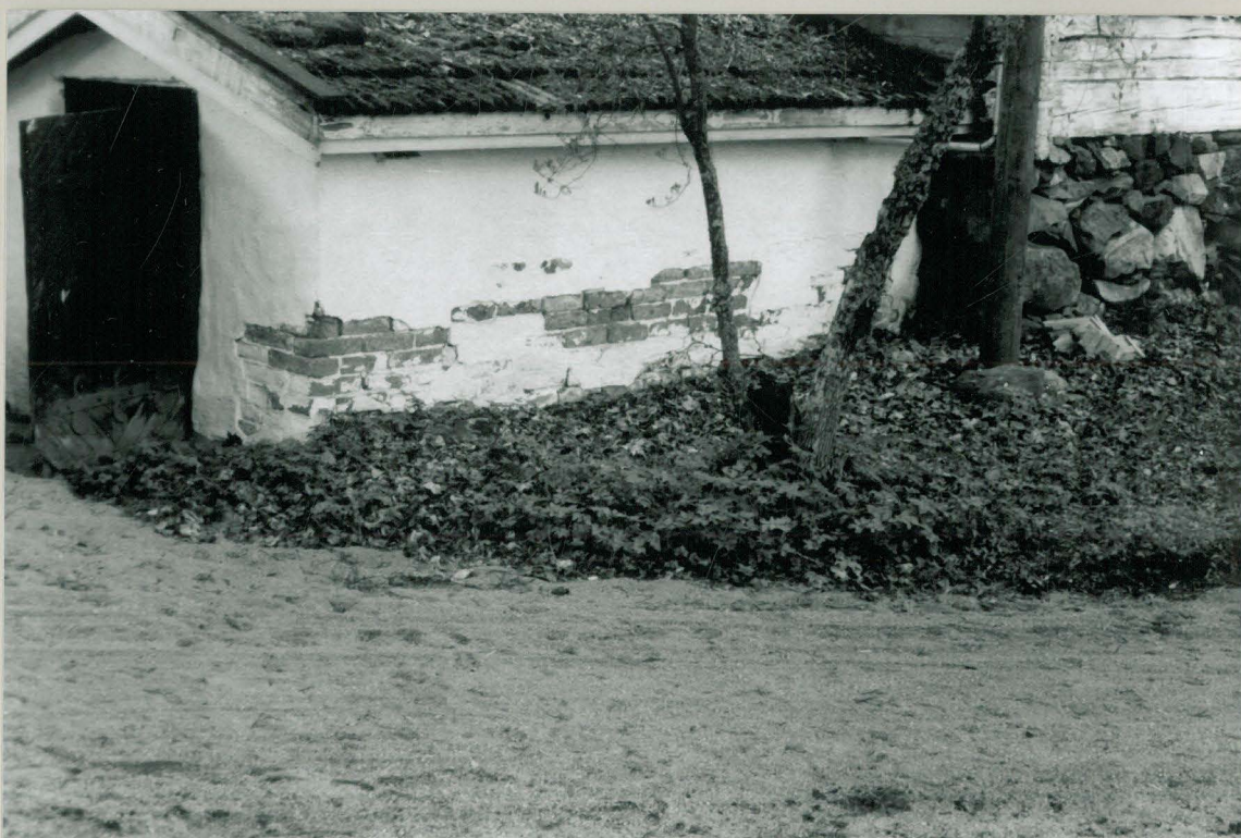
Laukon kellarirakennus. Portaiden eteläpuoli (alue 9(01)) SW RHO neg 119373
