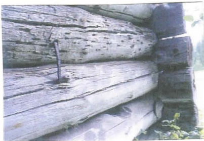
Kuva 8 ja 9, Kohde 26, Edellisen ladon seinää, hirsien liitosholkki, hirret paksuja ja suorina.
